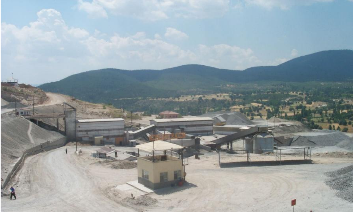
Resim 2.2 Hisarcık Konsantratör Tesisi
