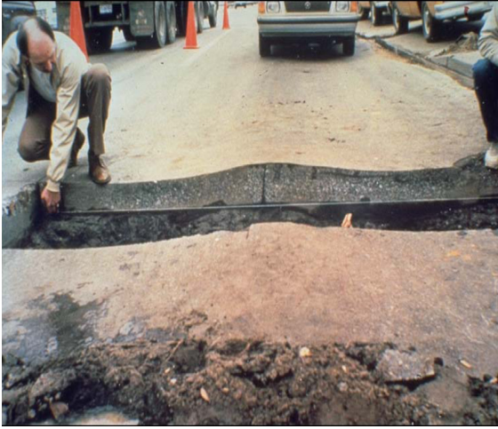
Resim 3.1 Bir Esnek Kaplamada Meydana Gelen Deformasyon.
