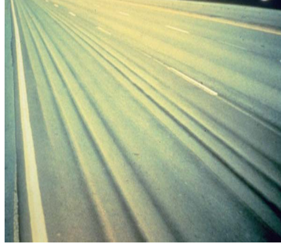
Resim 3.2 Bir tekerlek izi deformasyonu.
