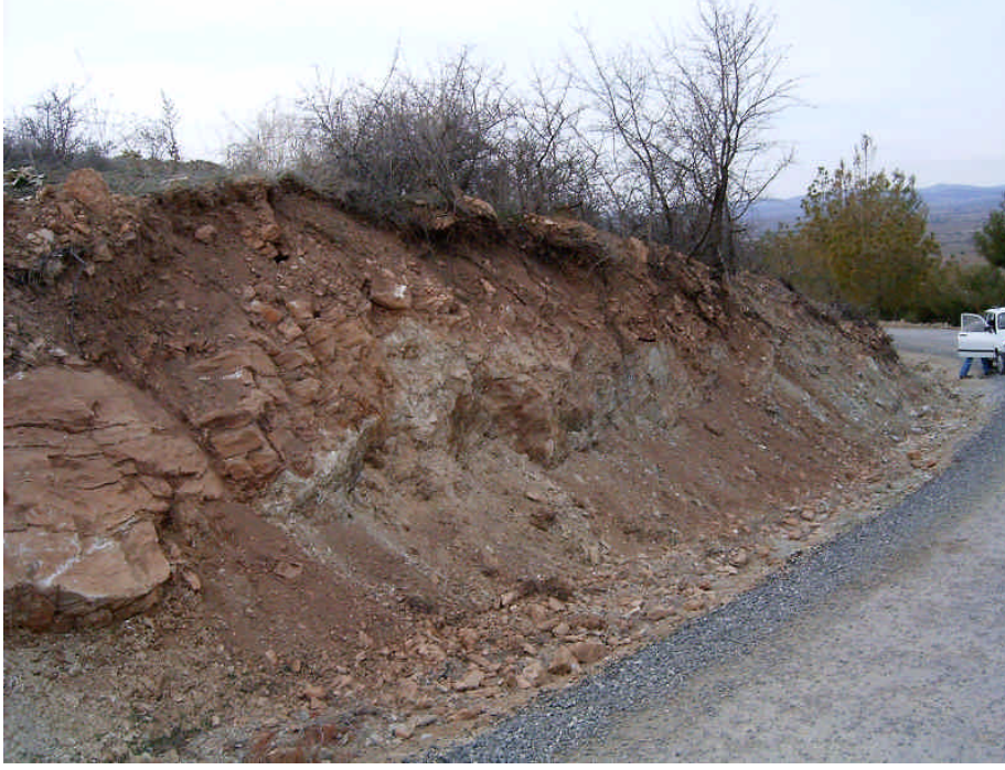
Resim 5.73. Kocaköy’de yol yarması üstünde yer alan asbest oluşumları (Evyapan ve diğ. 2008a).
