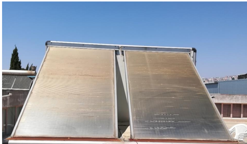
Şekil: 3.8. Güneş Toplayıcı Sistem (Havalı Güneş Kolektörü) Resmi
