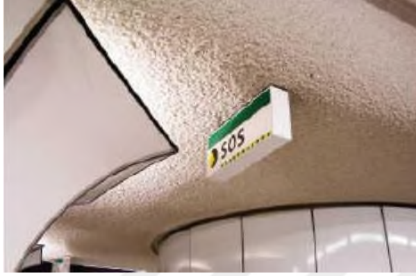
Şekil 2.13. Vermikülitin Sıva Uygulaması [47]
