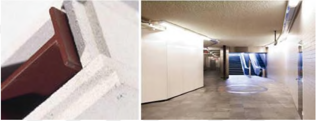
Şekil 2.15 Vermikülitin Yangından Koruma Uygulamaları [47]
