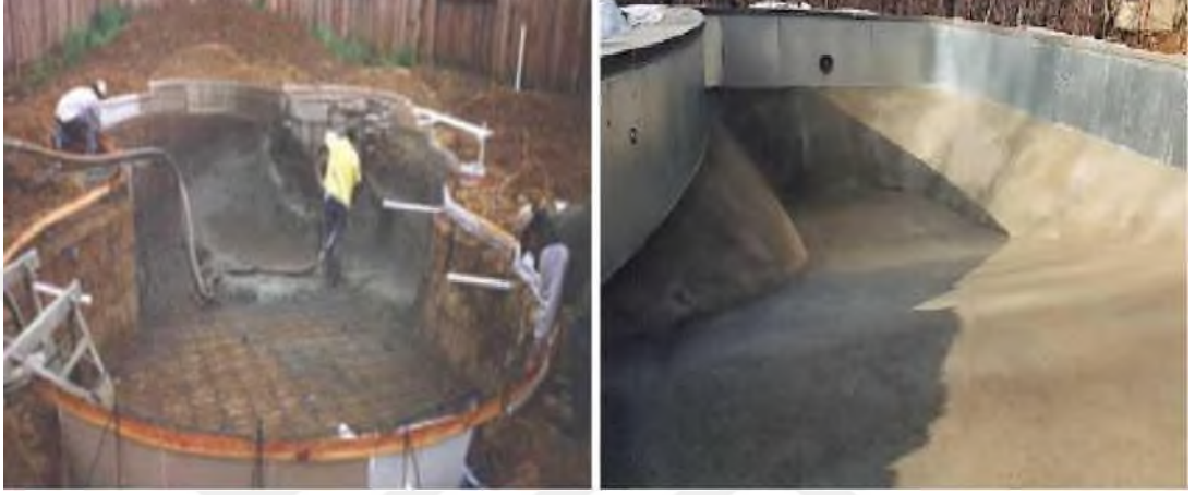
Şekil 2.17. Vermikülitin Su Yalıtımı Uygulaması [47]
