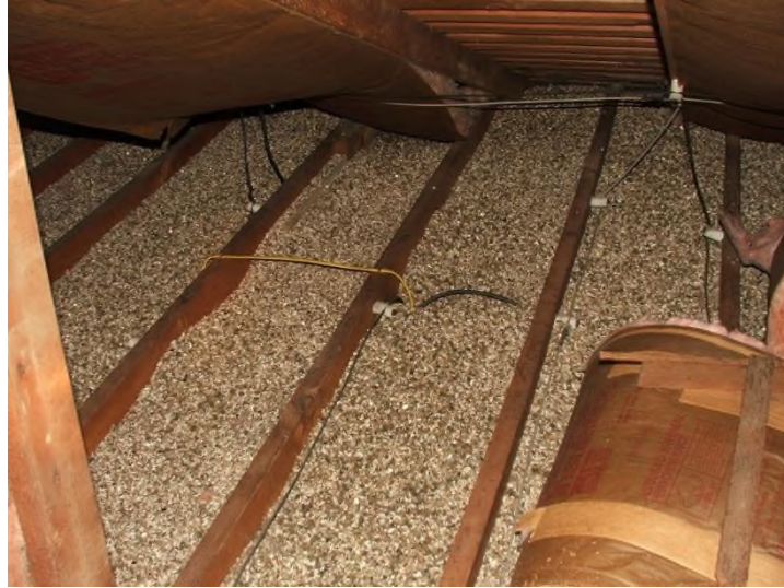
Şekil 2.14. Vermikülitin Çatı Yalıtım Uygulaması [47]
