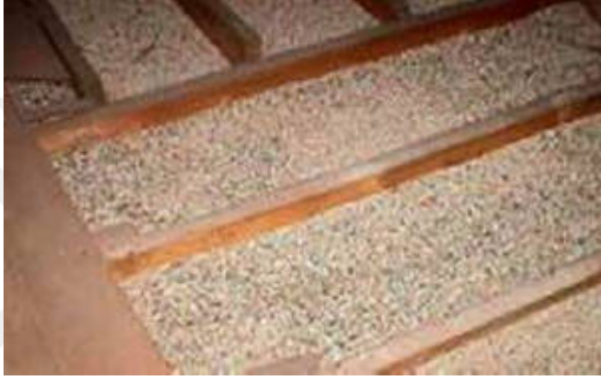
Şekil 2.8. Vermikülitin Çatı Yalıtım Uygulaması.
