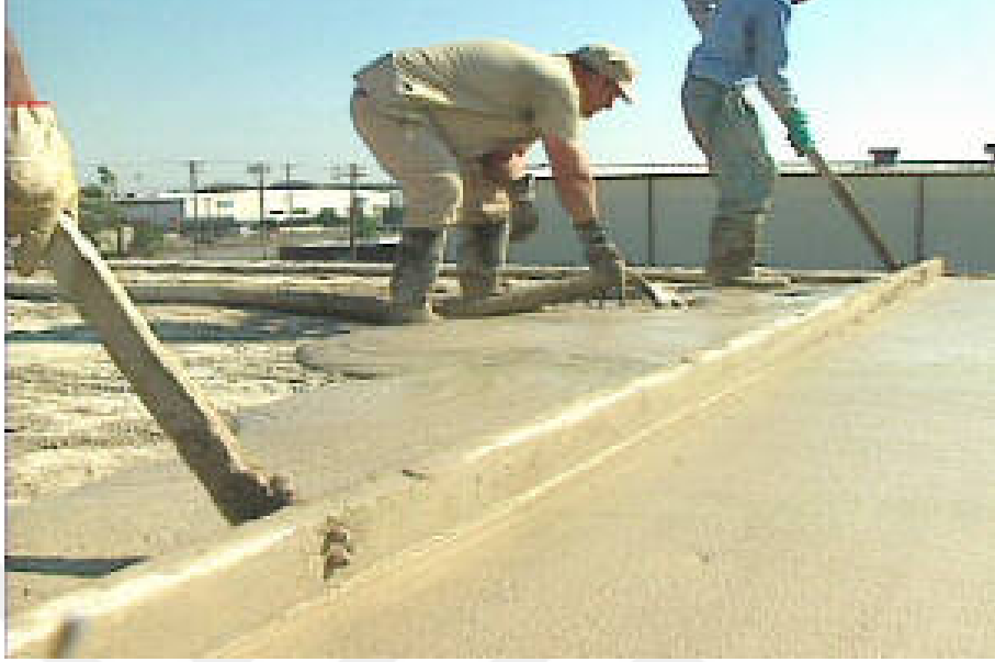
Şekil 2.6. Vermikülitin Hafif Beton Uygulaması.
