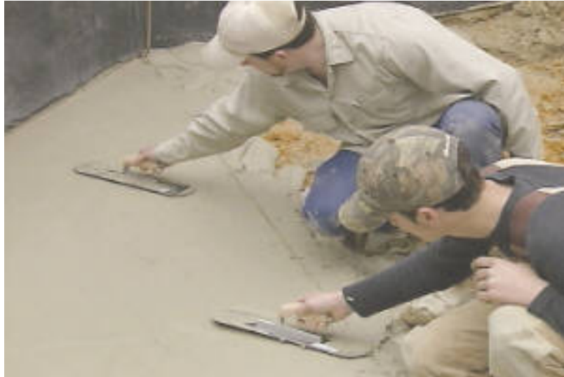
Şekil 2.5. Vermikülitin Hafif Beton Uygulaması.
