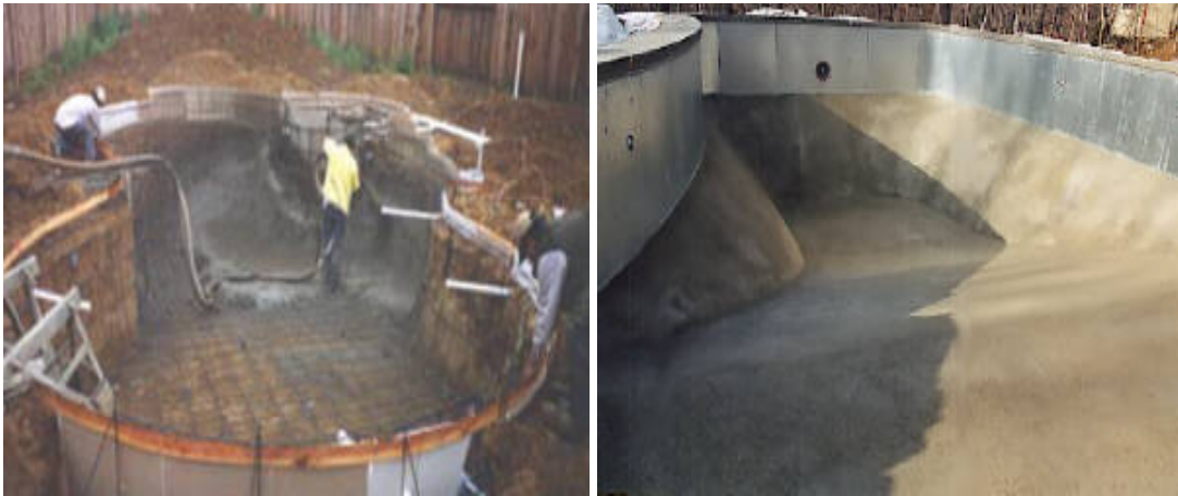
Şekil 2.12. Vermikülitin Su Yalıtımı Uygulaması [35]
