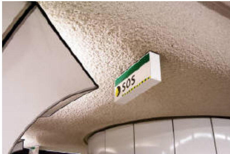
Şekil 2.7. Vermikülitin Sıva Uygulaması [35]
