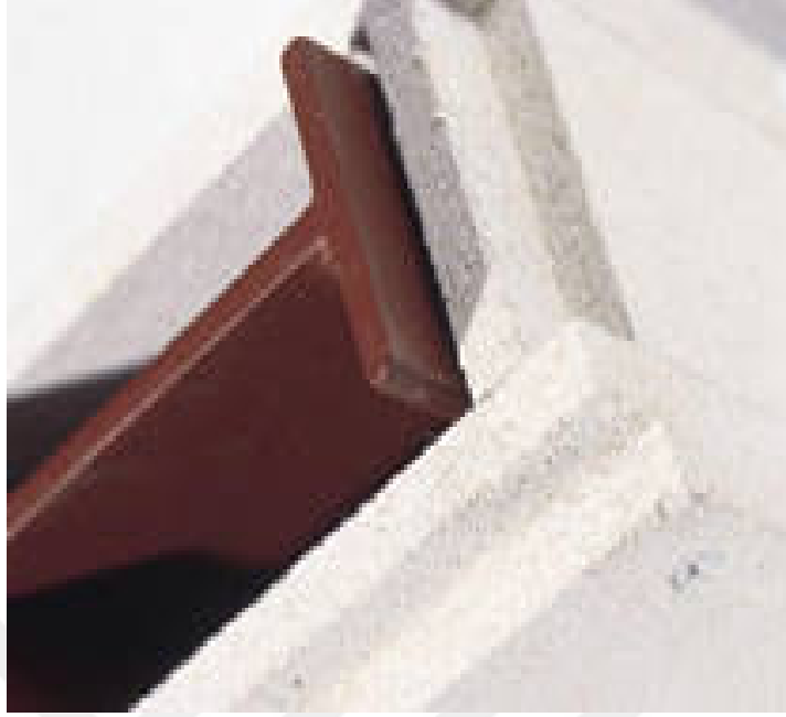
Şekil 2.9. Vermikülitin Çelik Elemanları Yangından Koruma Uygulaması.
