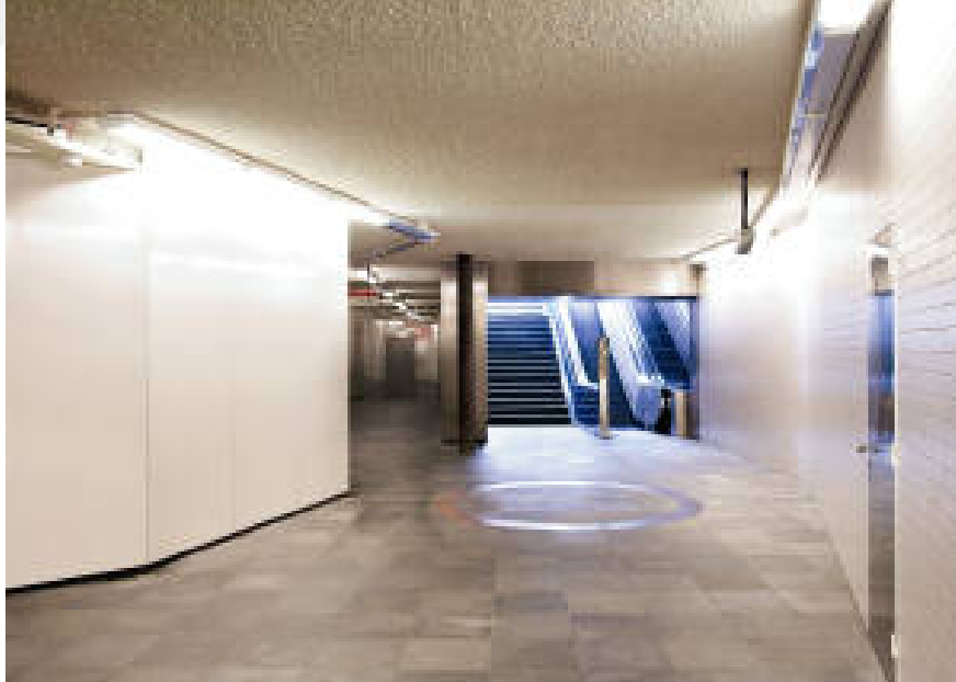
Şekil 2.10. Vermikülitin Yangın Koridoru Uygulaması.
