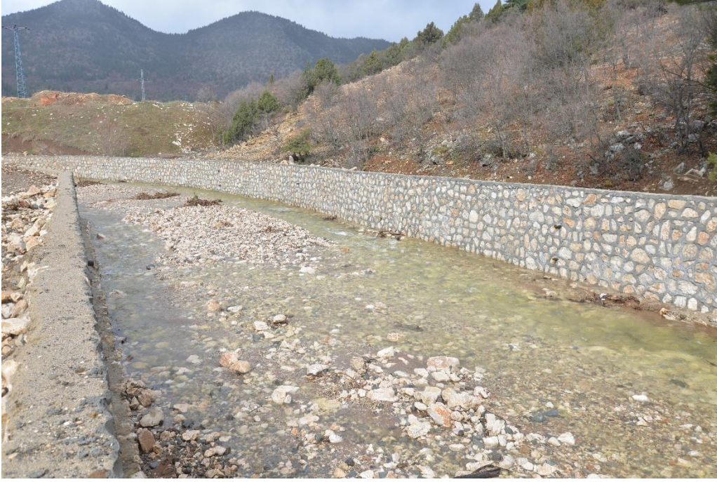
Şekil 1.10. Kaya Dolgu malzemesinin tahkimat olarak kullanılması (DSİ,2017).
