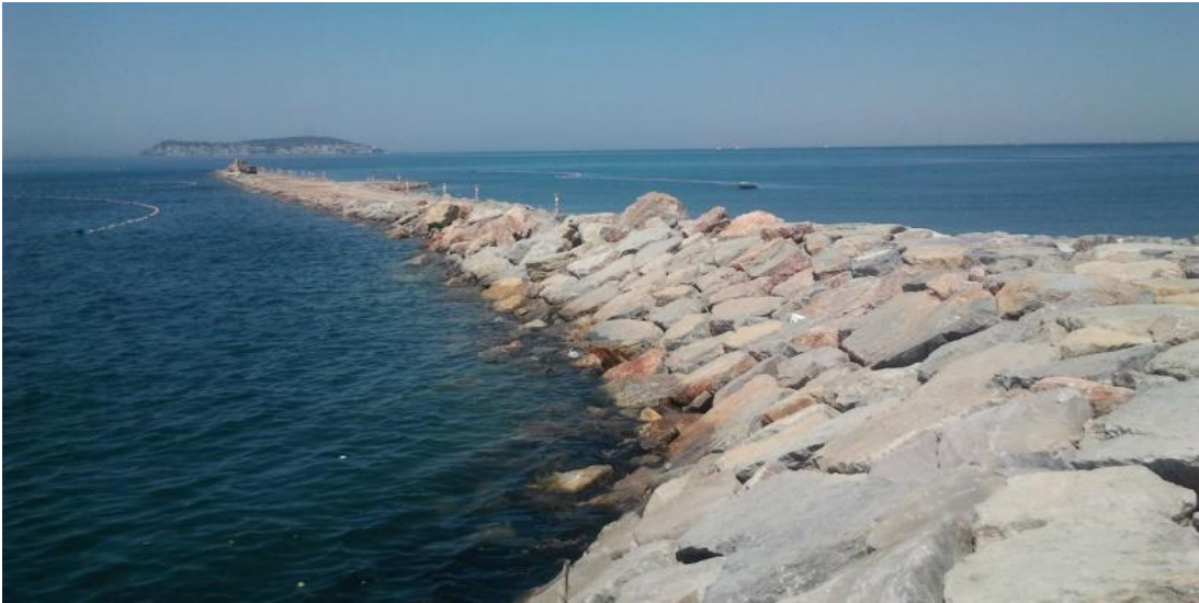
Şekil 1.11. Kaya Dolgu malzemesinin anroşman olarak kullanılması ( http://www.ozkainsaat.com/Projeler/maltepe-sahil-duzenlemesi-1.-etap-anrosman-insaati ).
