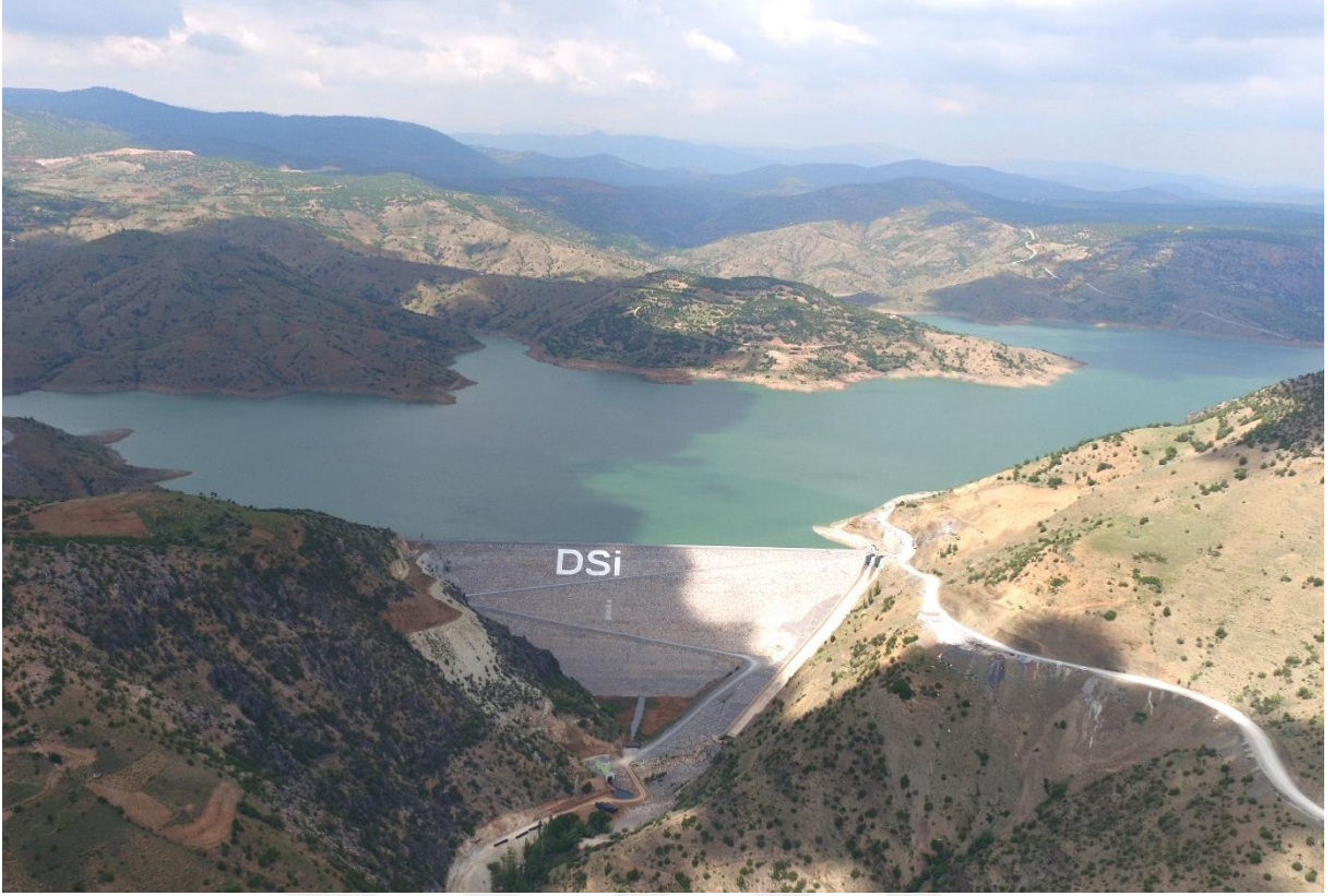
Şekil 1.1. Bağbaşı Barajı – Konya (DSİ, 2015).
