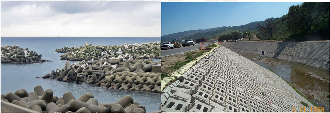
Şekil 1.15. Riprap olarak kullanılacak beton bloklar (a) ve beton döşemeler (b). ( http://www.gilladventures.com/Izu-Oshima-Island-rip-rap-2.html )
