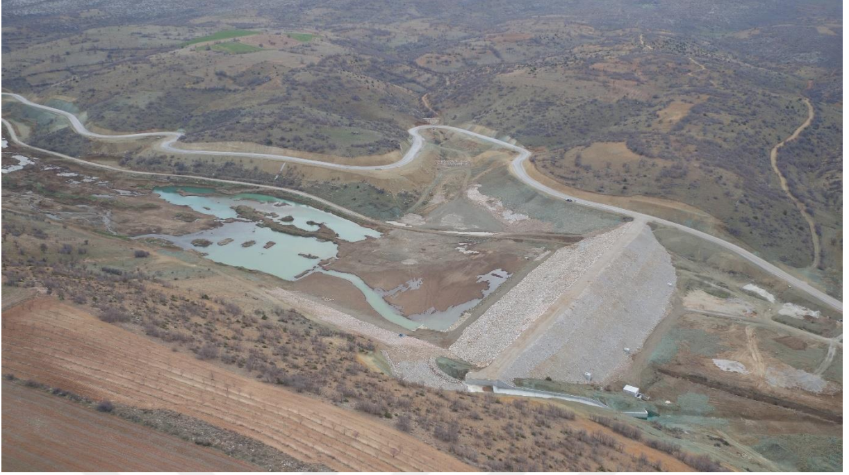
Şekil 1.12. Kaya malzemesinin barajlarda memba tarafında riprap, mansap tarafında kaya dolgu olarak kullanılması (DSİ, 2017).
