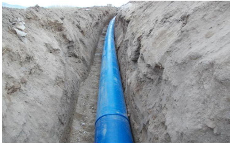
Şekil 2.2: Döşenmesi Yapılmış Borular
