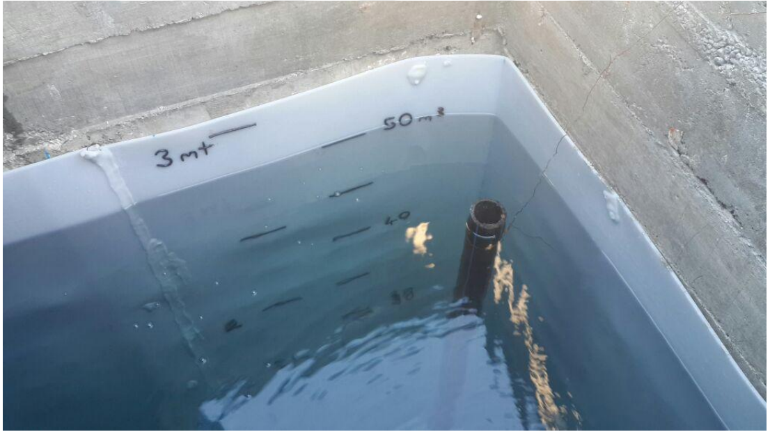
Şekil 2.27: 5 mm Kalınlıkta HDPE Levhalarla Su Yalıtımı
