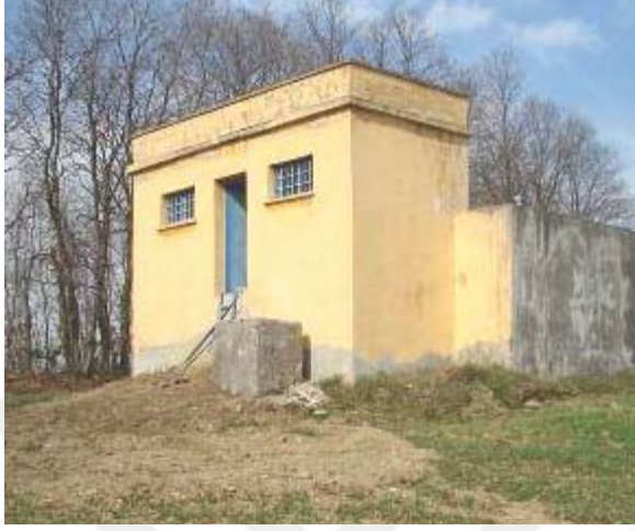
Şekil 2.26: Yarı gömme ve ayaklı su deposu(Kaynak: Çevre Sağlığı,Su Depolarının ve Su Kuyularının Islahı 850CK0014M.E.B, Ankara, 2012)
