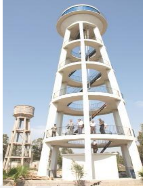
Şekil 2.26: Yarı gömme ve ayaklı su deposu(Kaynak: Çevre Sağlığı,Su Depolarının ve Su Kuyularının Islahı 850CK0014M.E.B, Ankara, 2012)
