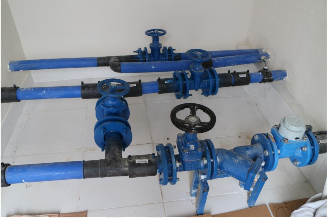
Şekil 2.28: Betonarme İçme Suyu Deposu Manevra Odası (Vana Odası) (İl Özel İdaresi/ÇORUM)
