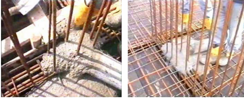
Resim 2.2 Sık donatılar arasından vibrasyon uygulamadan KYB geçişi
