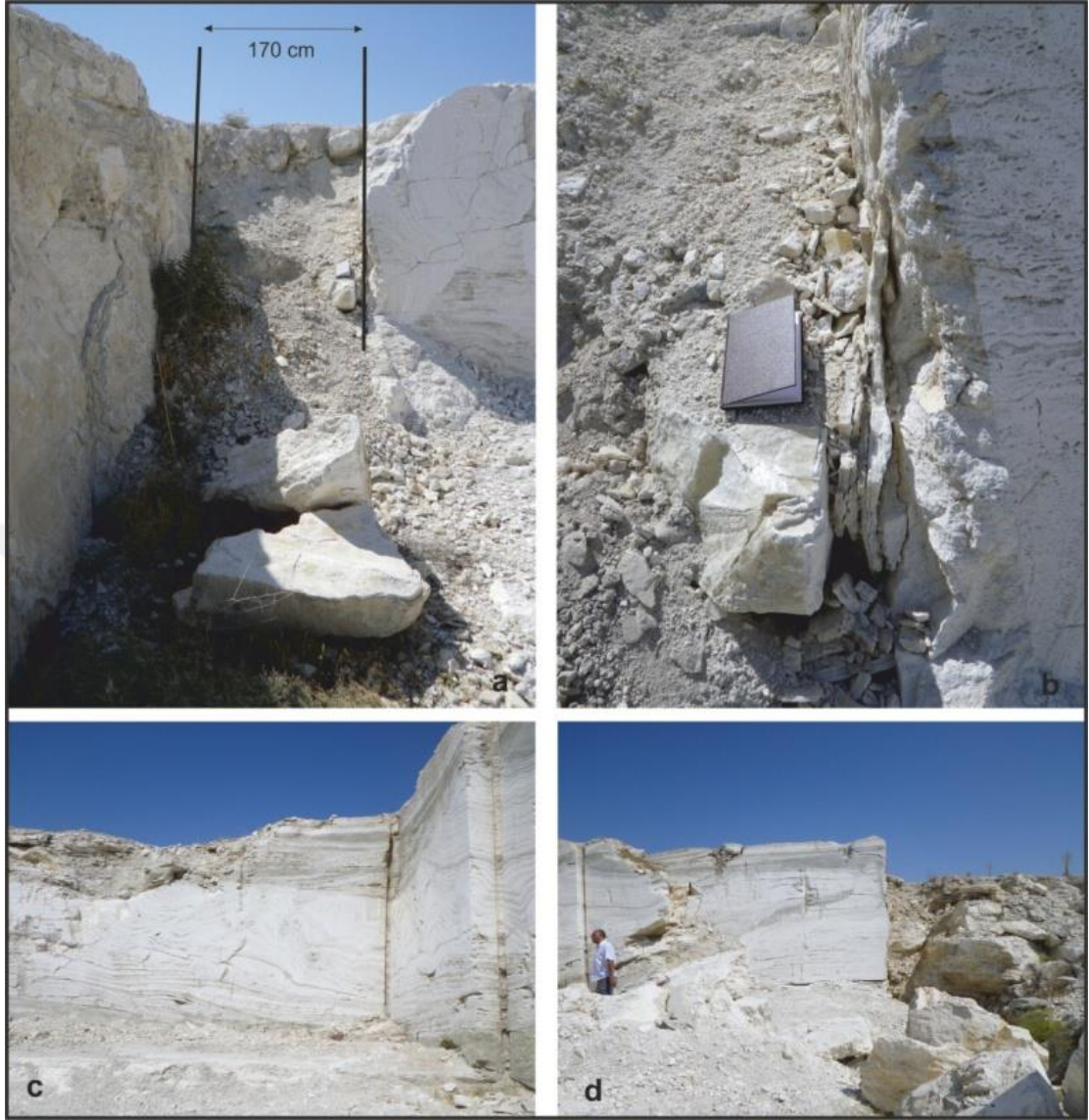
Şekil 5.7. a, b) 1 no lu travertenin merkezi çatlak genişliği ( Bakış Kuzey Batı'ya). c, d) 1 no lu travertenin genel yapısı (Bakış Kuzey Doğu'ya).
