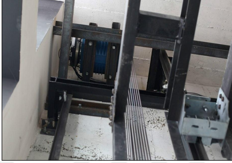
Şekil 3.8. Makine dairesiz asansör motoru kuyu içi görüntüsü
