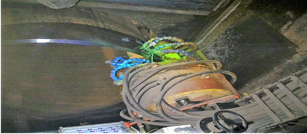
Şekil 6.30. Boru Ucu Manyetik Test-2
