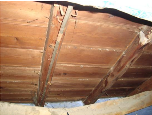
Resim 3.7 Tavan kirişi ve kaplaması
