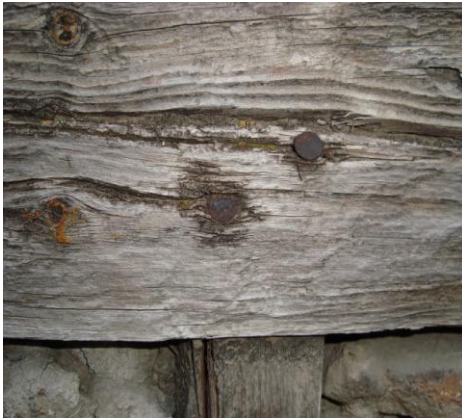
Resim 3.50 Birleşimlerde demirci çivisi kullanımı
