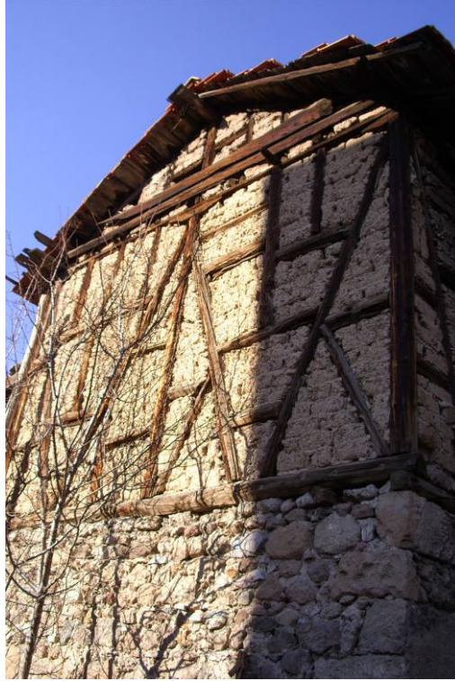
Resim 2.30 Ahşap karkas sistem
