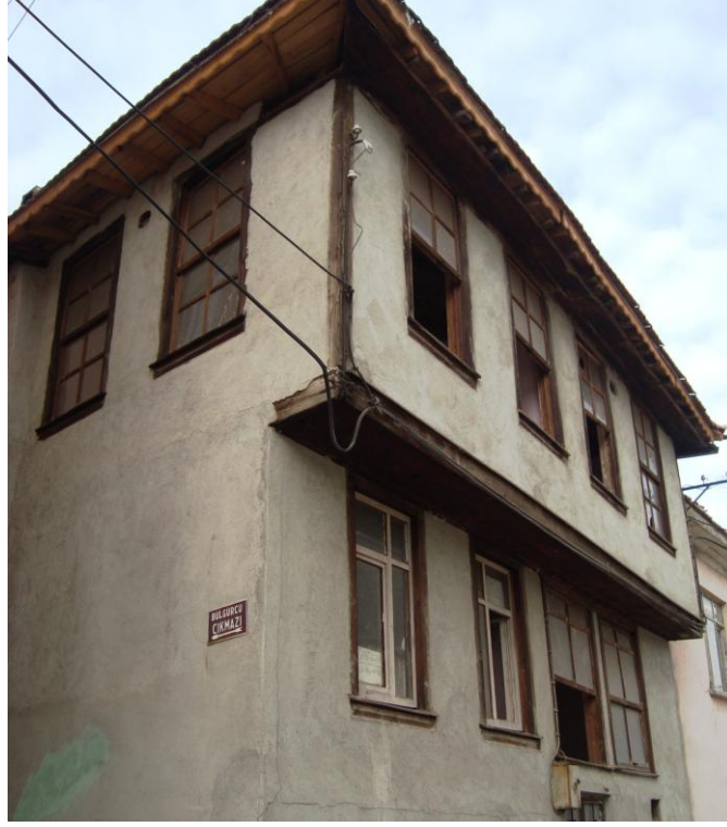
Resim 2.53 Konsol çıkma örneği
