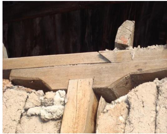
Resim 3.23 Orta dikme-başlık-üst taban ve ek yapılması
