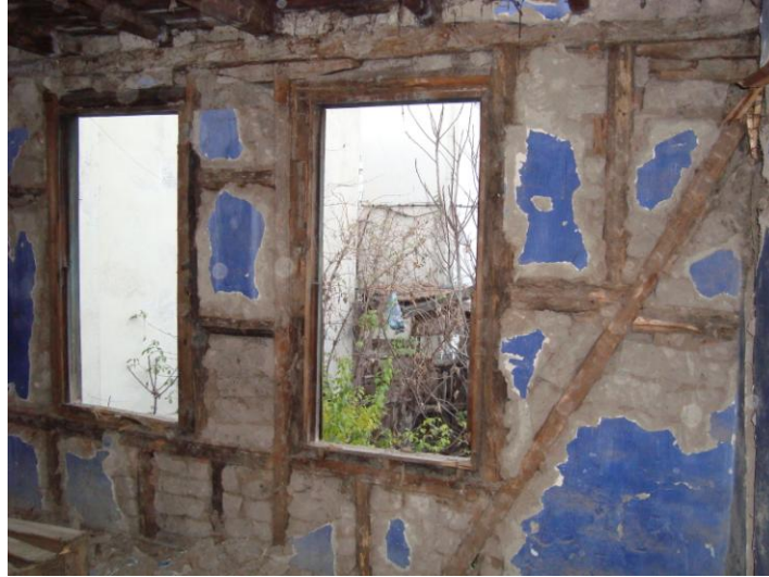
Resim 3.2 Evin iç ön cephe karkas yapı görünüşü
