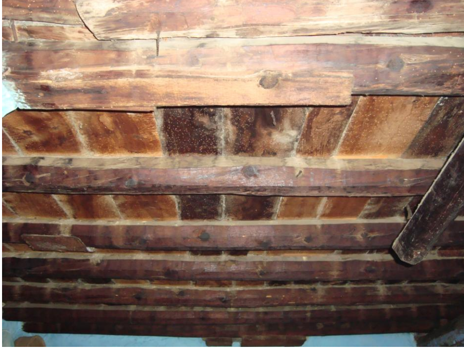
Resim 2.59 Döşeme kirişleri ve döşeme tahtaları
