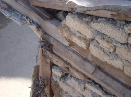
Resim 3.12 Köşe dikmesi-başlık- üst taban
