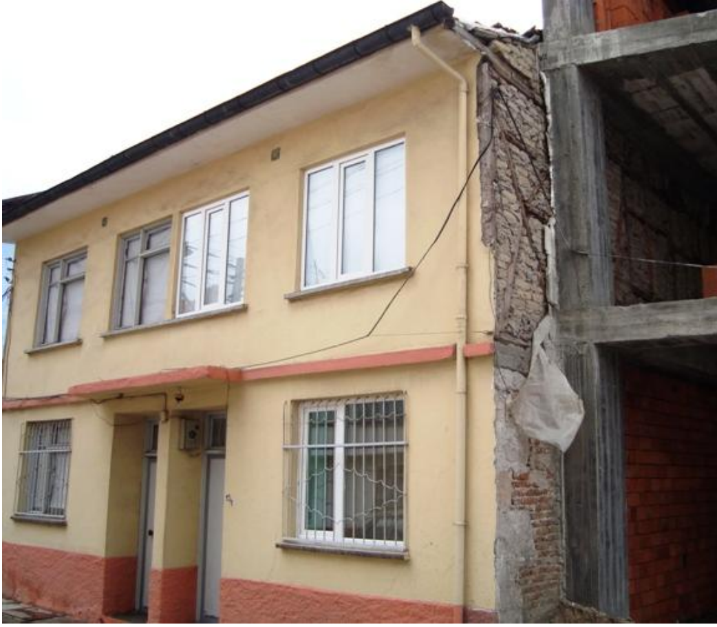
Resim 3.9 Abdullah Şahin evi cephe görünüşü
