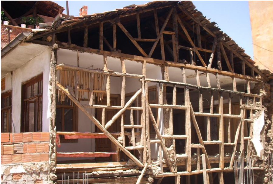
Resim 3.39 Abdullah Tabak evi çatkı sistemi
