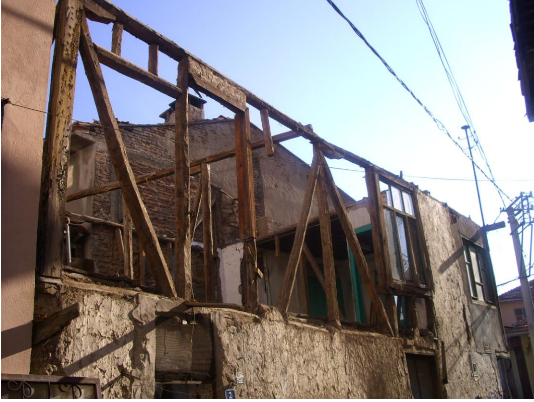
Resim 3.53 Osman Ortaç evi çatkđ sistemi
