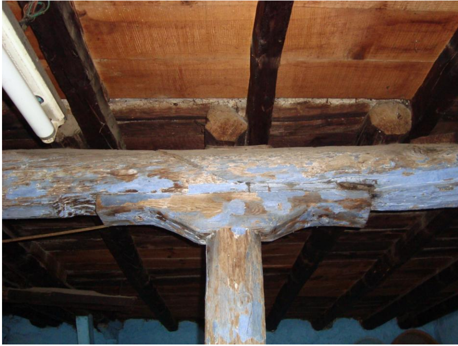
Resim 2.60 Döşeme altında dikme-başlık-taşıyıcı kiriş birleşimi
