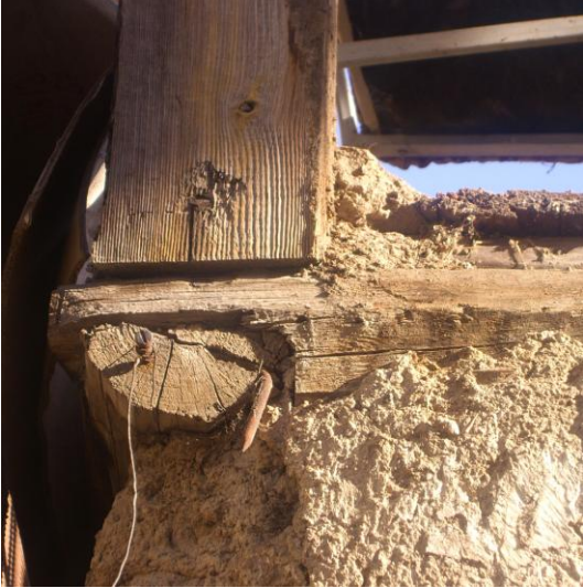
Resim 3.54 Hatıl-dikme birleşimi
