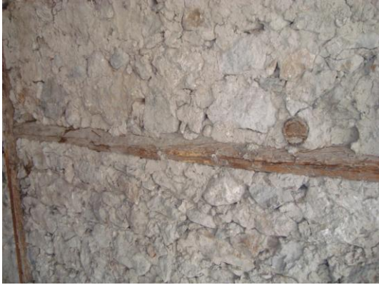
Resim 3.63 Taş duvarda yatay hatıl
