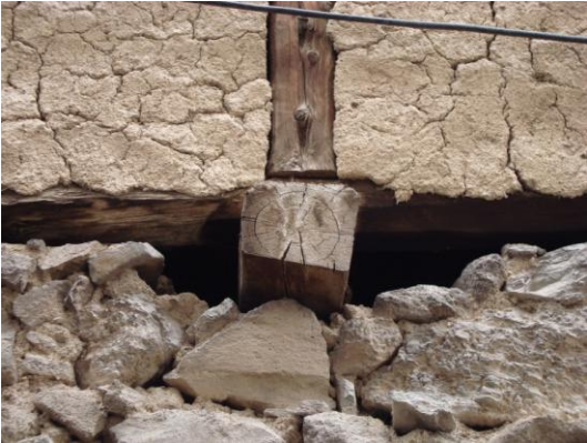
Resim 3.79 Taşıyıcı kiriş-hatıl-dikme
