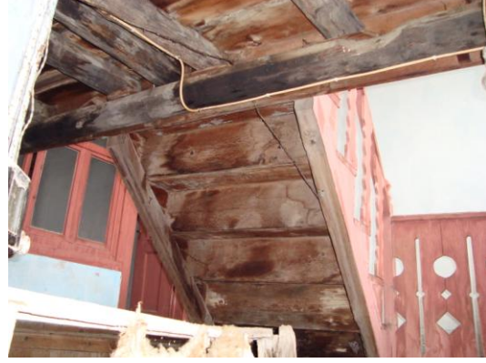
Resim 3.87 Üst kata çıkış merdiveni taşıyıcıları
