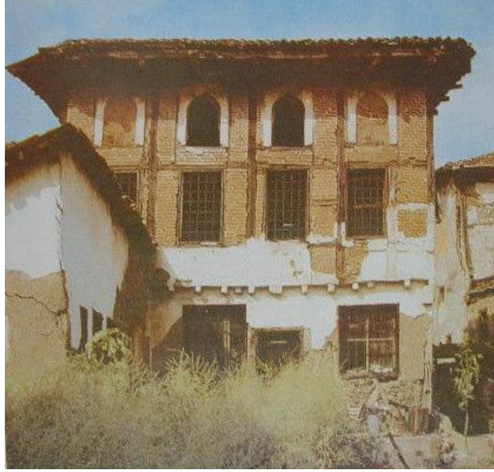
Resim 2.2 17.yüzyılda yapılmış tuğla dolgulu ev (Özhan 2006).
