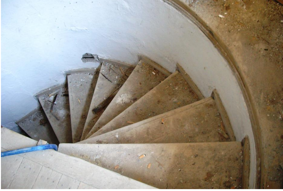
Resim 2.49 Ahşap döner merdiven
