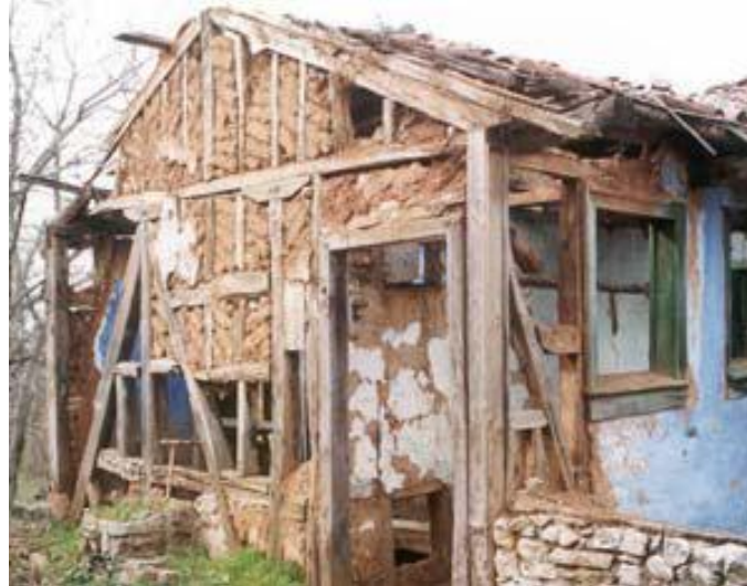
Resim 2.4 Ahşap karkas yapım sistemi (Perker ve AkıncıTürk 2006).
