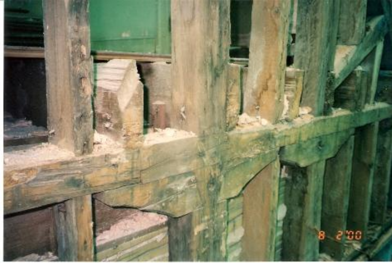
Resim 2.22 Ahşap başlığın üstünde kiriş geçme detayı (İnt. Kyn. 2).
