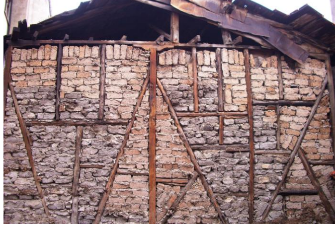
Resim 3.19 Yan duvar ahşap karkas sistem görünüşü
