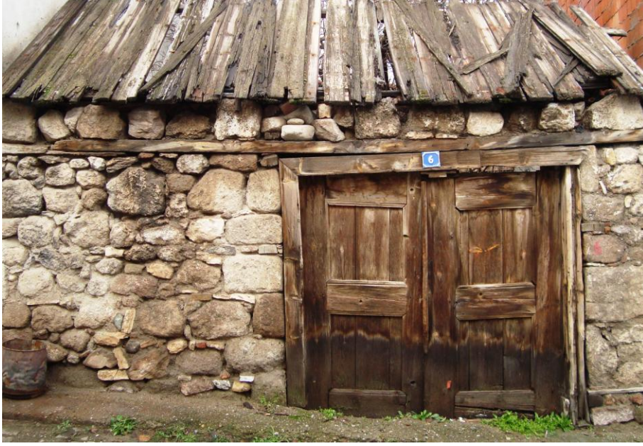
Resim 2.25 Bahçeye giriş kapısı
