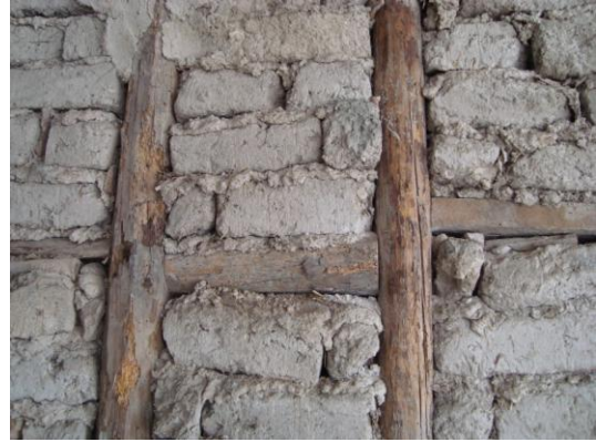
Resim 3.64 Yatay ve düşey ara eleman
