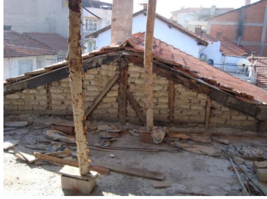
Resim 3.15 Kerpiç dolgulu çatı kalkan duvarı
