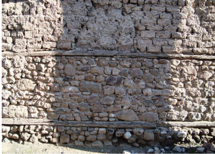
Resim 2.41 Taş ve kerpiçten oluşturulmuş yığma duvar
