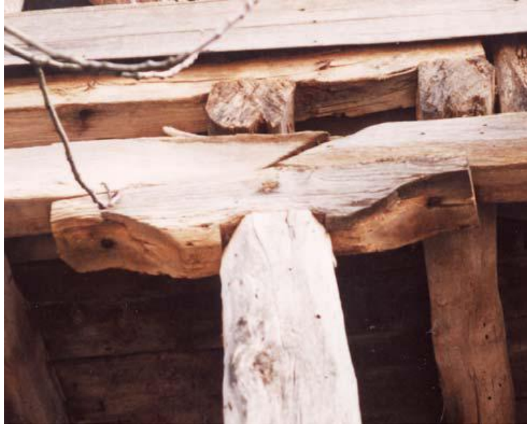
Resim 2.17 Bazı geleneksel yapılarda tabanlara ek yapılması ( Aksoy ve Ahunbay 2005).
