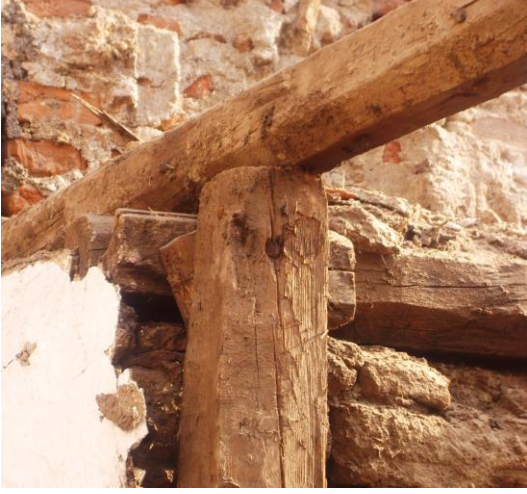
Resim 3.56 Hatıl-dikme-üst taban kirişi
