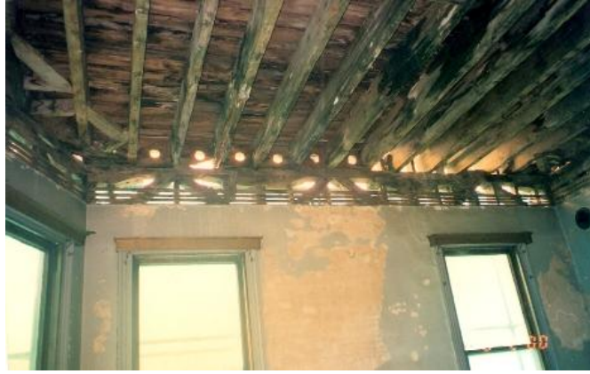
Resim 2.24 Üst kat tavan kirişleri (İnt. Kyn. 2).
