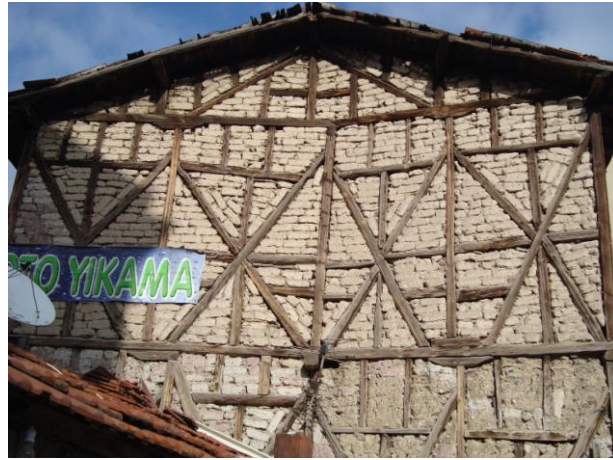
Resim 3.30 Ömer Gürcan evi ahşap karkas sistemi
