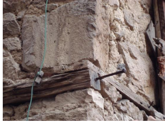
Resim 3.76 Zemin kat taş duvarı
