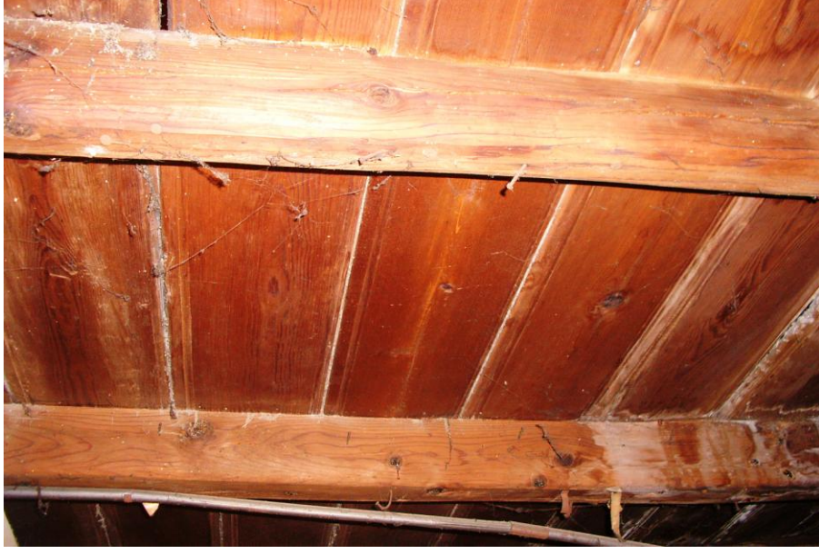
Resim 2.57 Üst kat döşeme kirişleri
