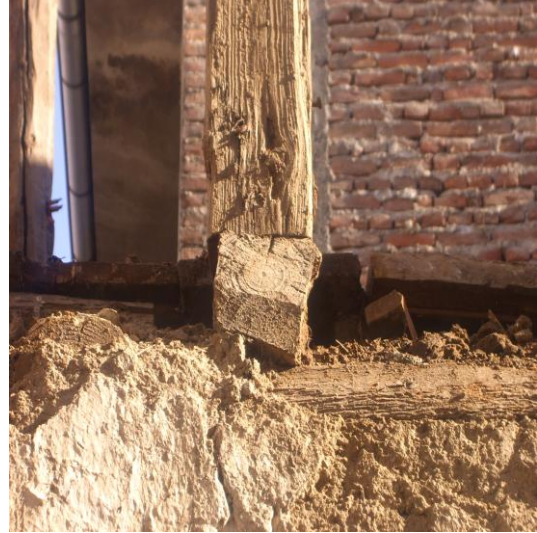
Resim 3.55 Hatıl-taban kiriş-i-dikme
