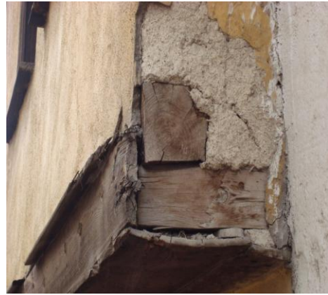
Resim 3.51 Taban kirişleri ve çıkma
