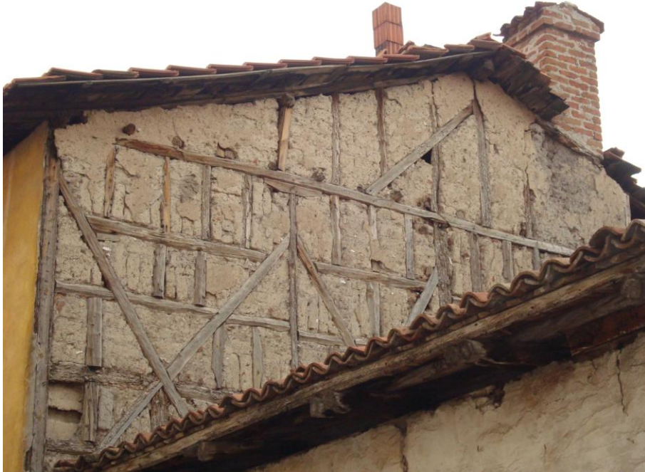
Resim 3.45 Neşet Eriş evi ahşap karkas sistemi
