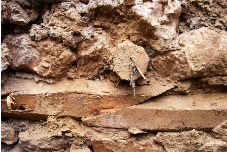
Resim 2.38 Yığma taş duvarda hatıl boyunun eklenmesi
