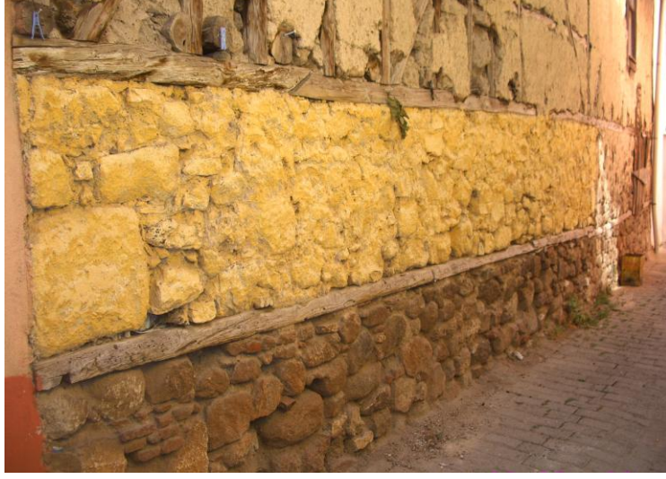
Resim 2.42 Yığıma taş duvar üzerine ahşap karkas sistemin oturtulması
