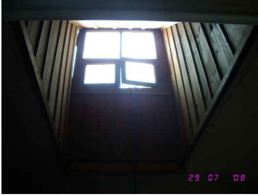
Resim 3.37 Odanın çatıdan aydınlatılması
