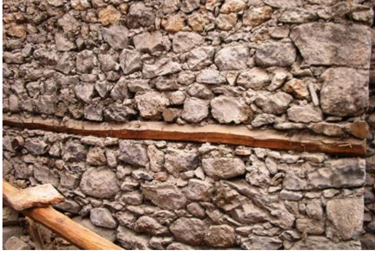
Resim 2.33 Yığma taş duvar
