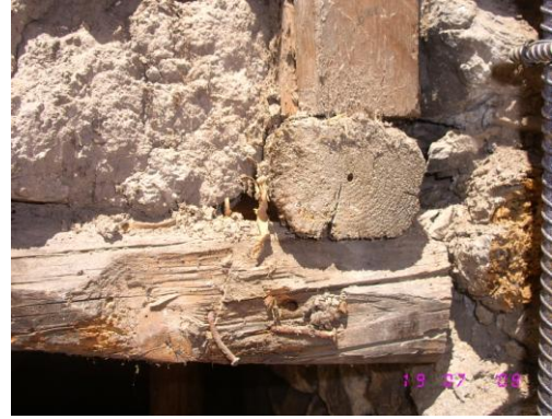
Resim 3.43 Taban kirişleri-köşe dikmesi
