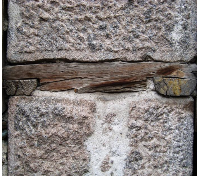
Resim 2.39 Taş duvarda hatılların birbirine düz geçme ile bağlanması
