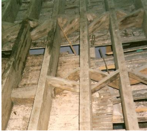
Resim 2.23 Döşeme kirişleri ve bağdadi sıvalı tavan (İnt. Kyn. 2).
