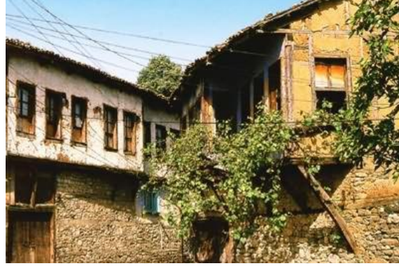
Resim 2.9 Merteklerin uzatılmasıyla saçak oluşması (Özhan 2006).
