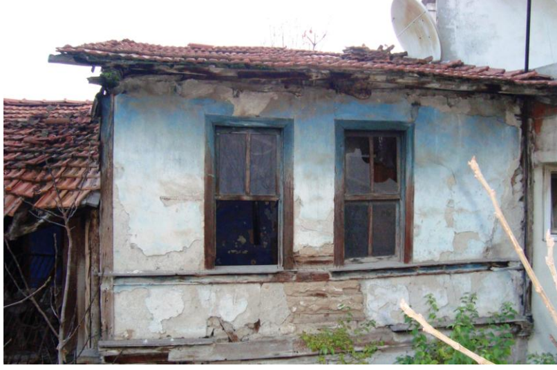
Resim 3.1 Mehmet Boyar evi cephe görünüşü
