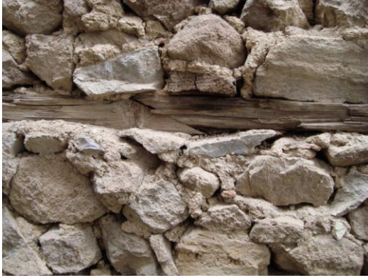
Resim 3.77 Taş duvarda hatıl ve eklenmesi
