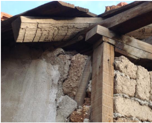
Resim 3.22 Köşe dikme-başlık-taban-mertek
