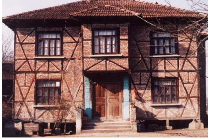
Resim 2.12 Yakın tarihli ahşap iskeletli yapılara bir örnek ( Aksoy ve Ahunbay 2005).
