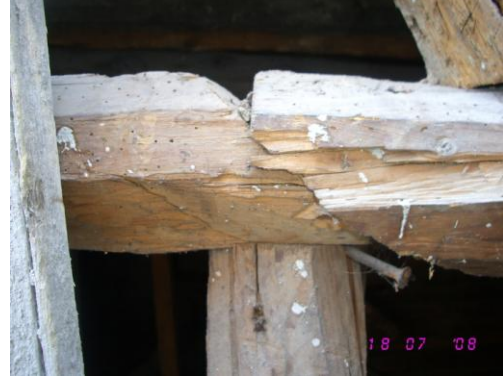
Resim 3.41 Dikme-üst taban boy eklemesi
