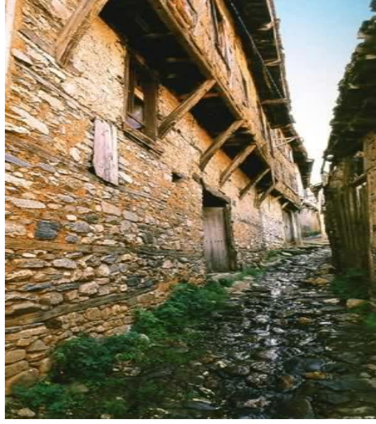
Resim 2.10 Payandalı çıkma cephe boyunca devam etmiş (Özhan 2006).
