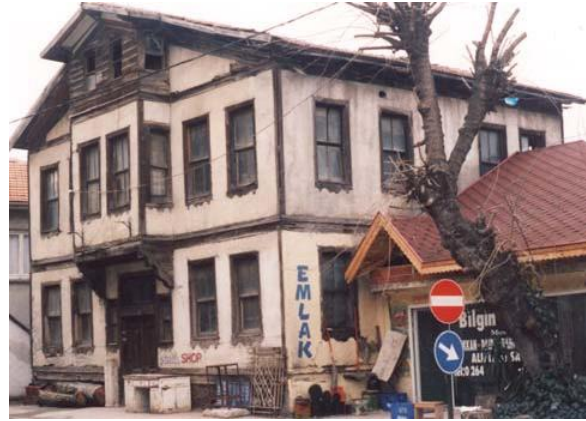
Resim 2.11 Geleneksel ahşap iskeletli yapılardan bir örnek
