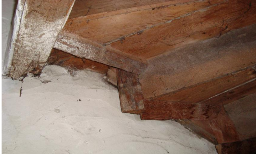
Resim 2.51 Merdivende taşıyıcı görünüşü
