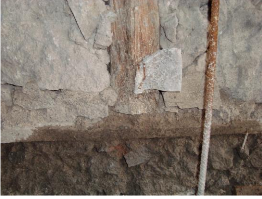
Resim 3.65 Yatay-düsey hatıl
