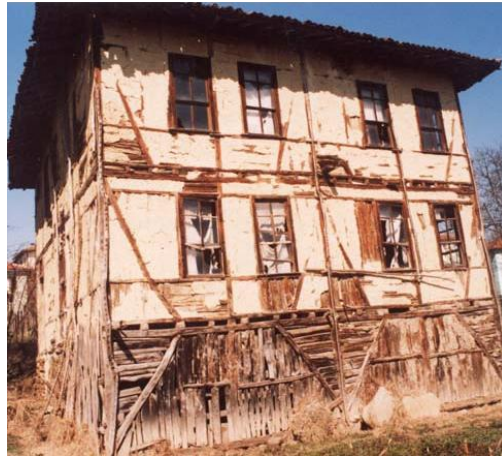
Resim 2.15 Zemin katı hımiş, üst katı bağdadi yapı ( Aksoy ve Ahunbay 2005).
