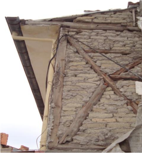
Resim 3.10 Ahşap karkas duvar
