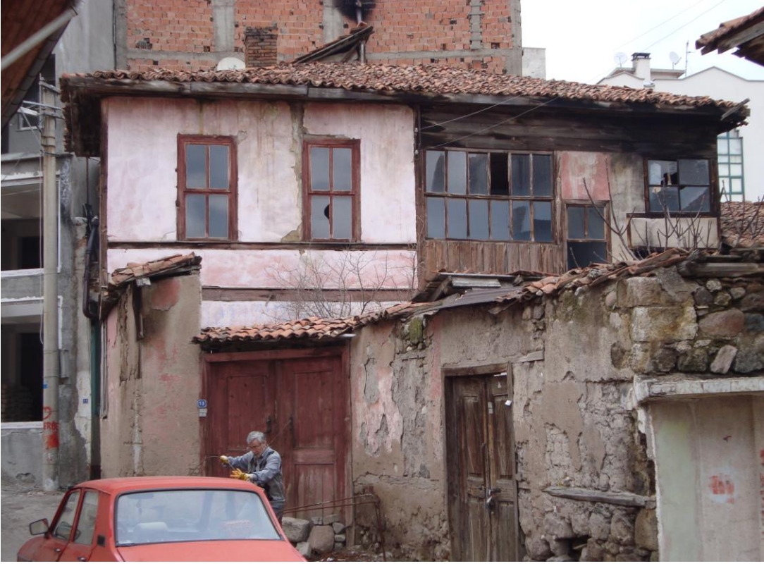
Resim 3.81 Mustafa Sıkıcı evi cephe görünüşü
