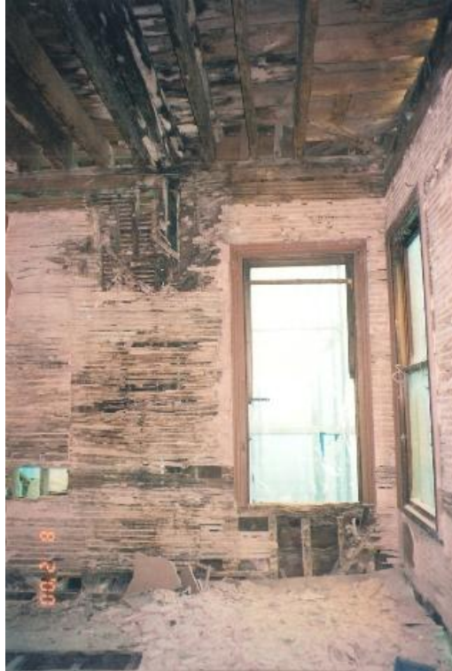
Resim 2.21 Su alan kısımlardaki ahşapların çürümesi (İnt. Kyn. 2).
