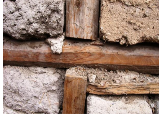
Resim 3.25 Yatay-dikey ara elemanlar
