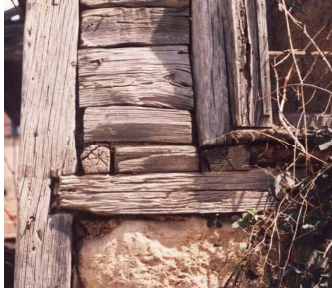
Resim 2.18 İki kat boyunca devam eden dikmeye, yatay bölme elemanının saplanması ( Aksoy ve Ahunbay 2005).
