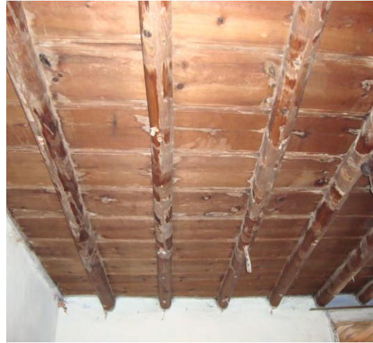
Resim 3.83 Üst kat döşemesi kirişleri
