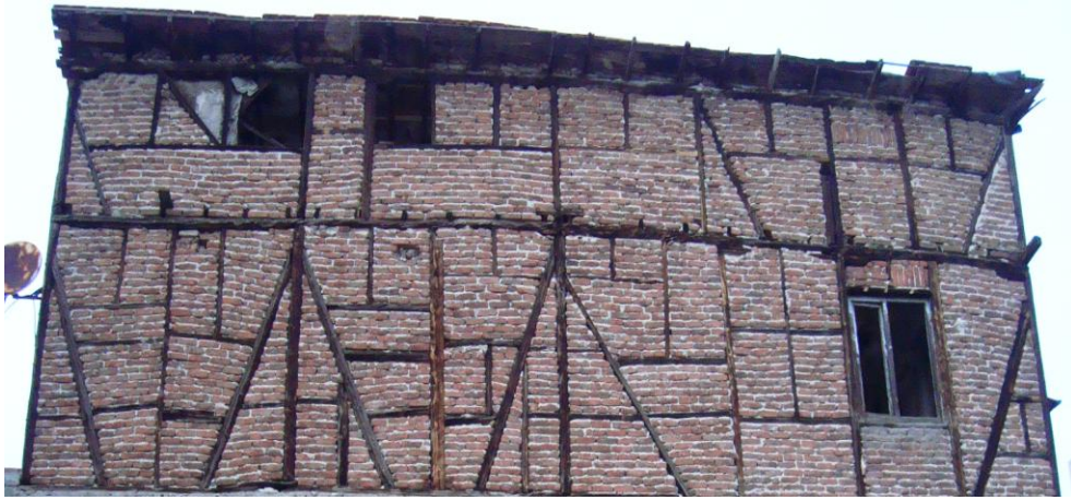
Resim 2.36 Dolgusunda tuğla kullanılmış yapı örneği
