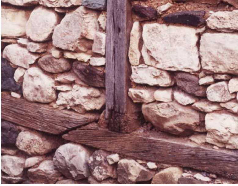
Resim 2.16 Hatılda pahlı boy birleştirme ( Aksoy ve Ahunbay 2005).
