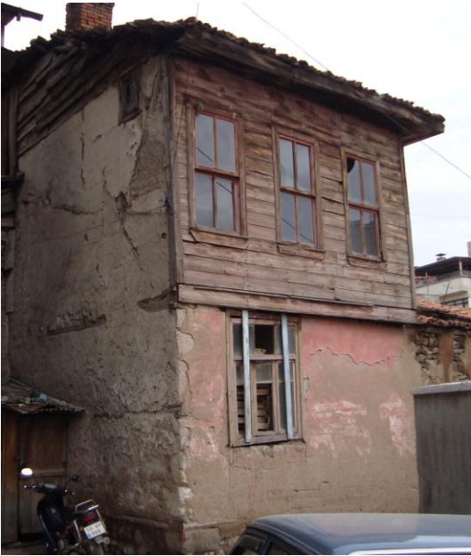
Resim 3.82 Yan cephe görünüşü
