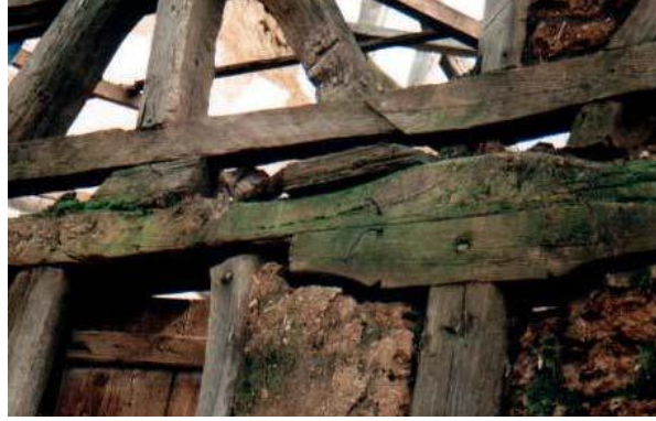
Resim 2.6 Dikme-başlık-taban birleşimi (Perker ve AkıncıTürk 2006).
