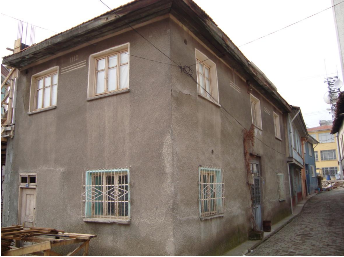
Resim 3.62 Süleyman Pişkin evi cephe görünüşü
