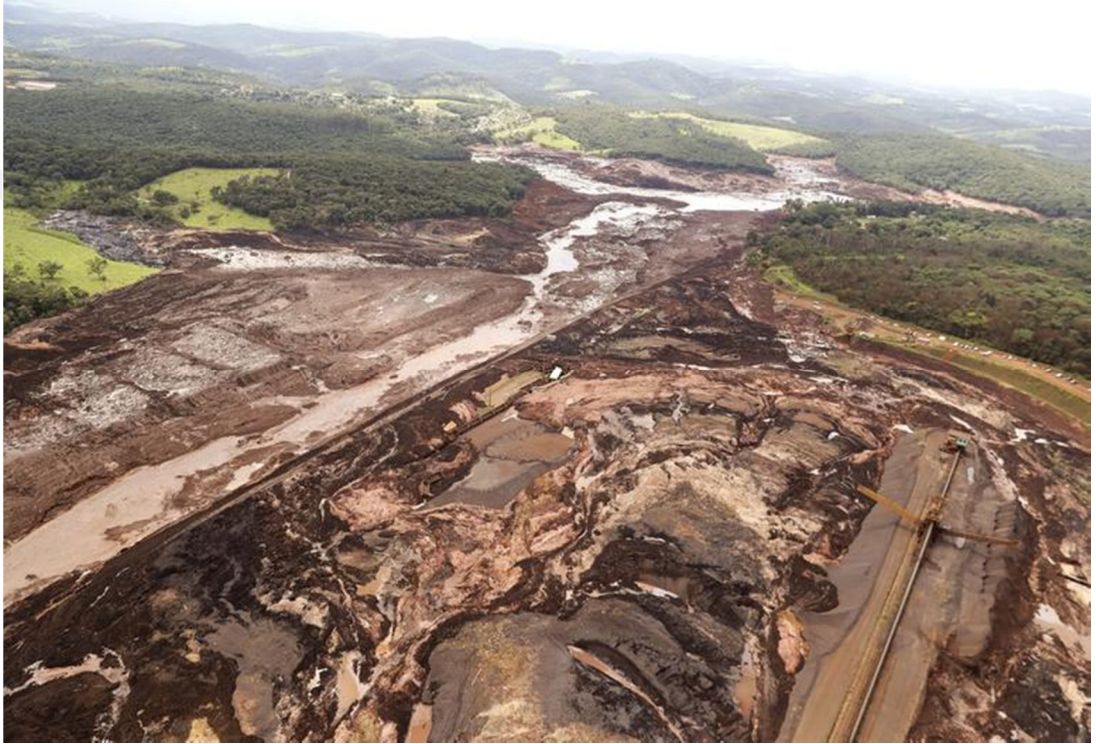
Şekil 2.2. Brezilya'daki Baraj Yıkılması Sonucunda Oluřan Görüntü (03.02.2019) https://www.aksam.com.tr/dunya/brezilya-madencilik-sirketinden-baraj-uyarisi/haber-839072
