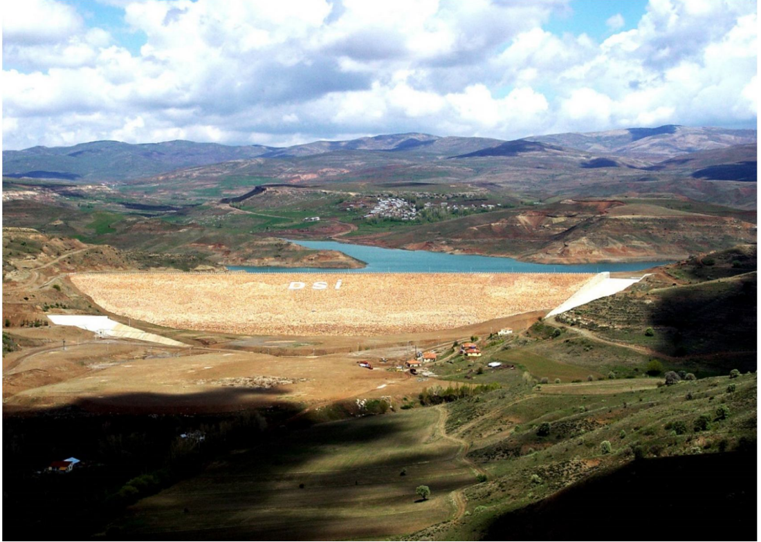
Şekil 3.4. Sivas 4 Eylül Barajı'na Ait Görüntü (09.11.2017)
