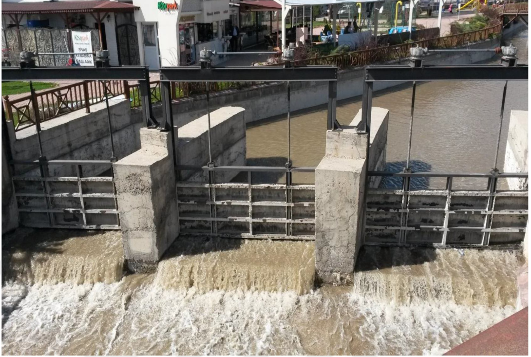
Şekil 3.9. Mısmılırmak Üzerindeki Mevcut Kabartma Yapısı (10.11.2017)
