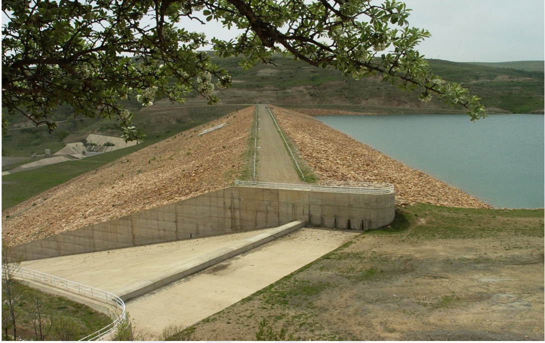
Şekil 3.5. Sivas 4 Eylül Barajı'na Ait Görüntü (09.11.2017)
