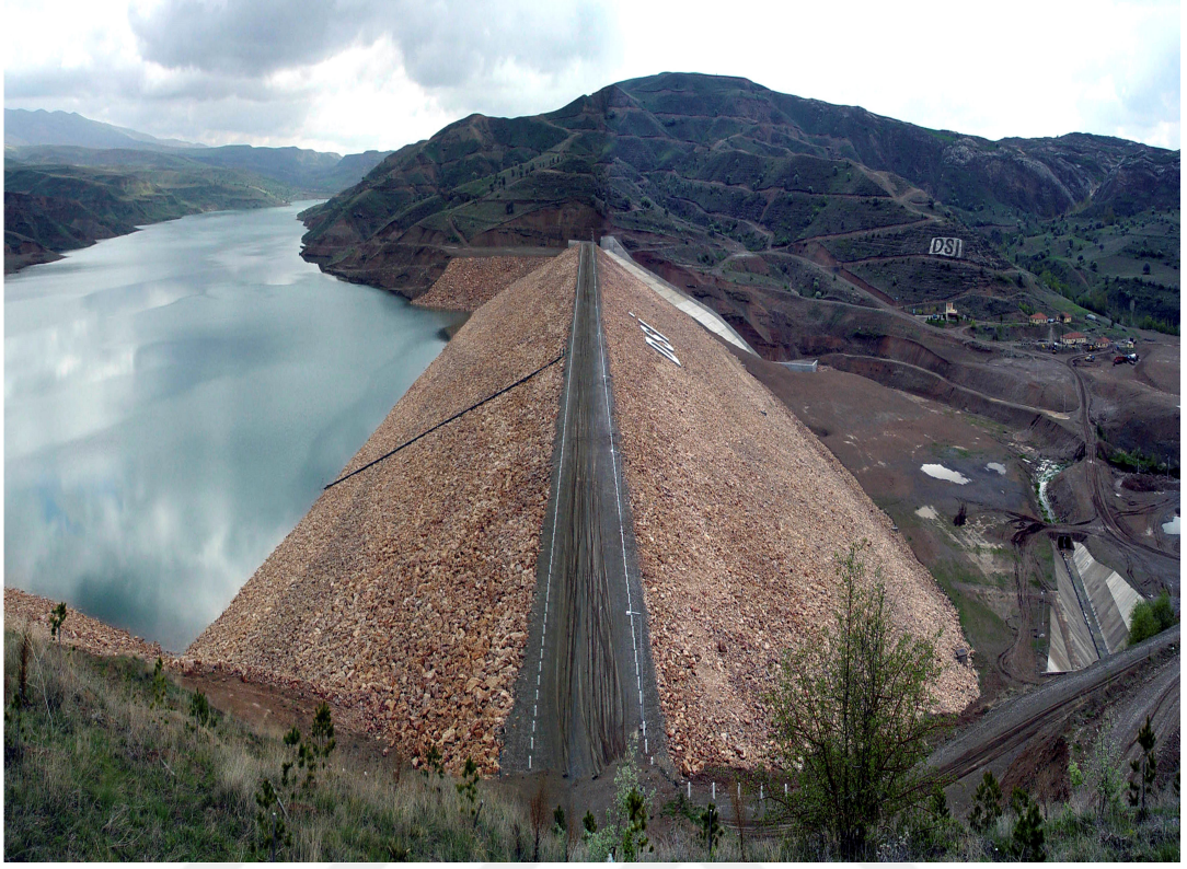
Şekil 3.3. Sivas 4 Eylül Barajı'na Ait Görüntü (09.11.2017)
