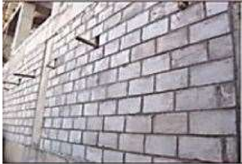
Şekil 2. 12 Hafif Köpük Beton Bina Taşıyıcı Duvarı [86]
