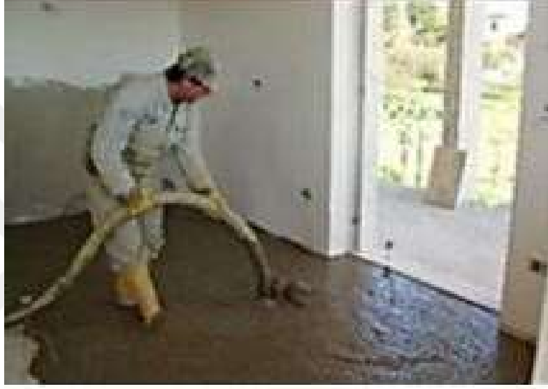
Şekil 2. 13 Köpük Betonun Şap Uygulaması [86]
