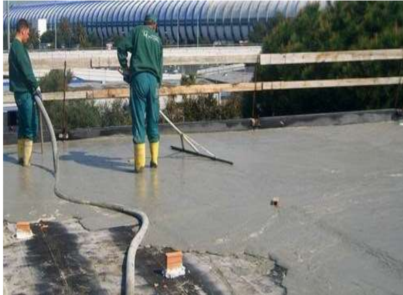
Şekil 2. 14 Köpük Betonun Çatı Yalıtım Uygulaması [86]
