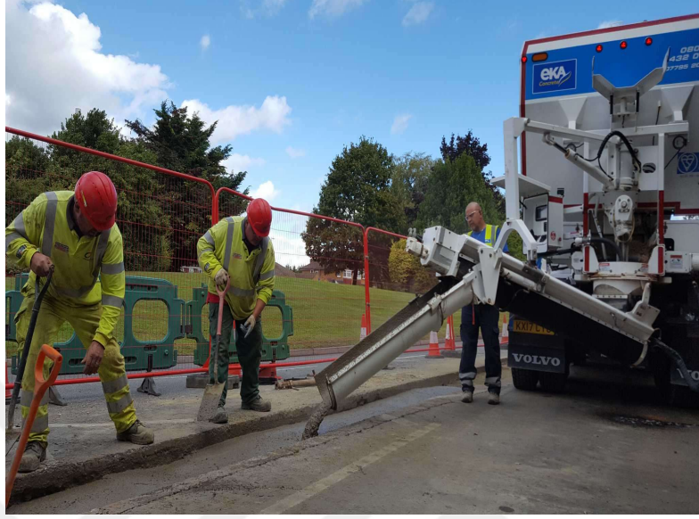
Şekil 2. 9 Köpük Beton İle Yol Kenarı Kazısı Dolgusu [84]
