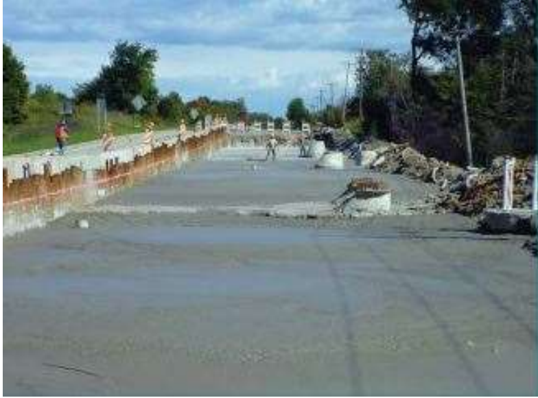
Şekil 2. 10 Köpük Beton Yol Alt Temel Uygulaması [85]
