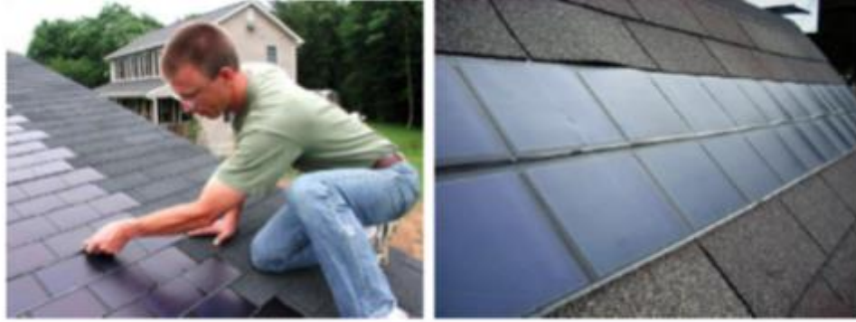
Şekil 2.18 Şingil çatıda fotovoltaik sistemlerin kullanımı [26]
