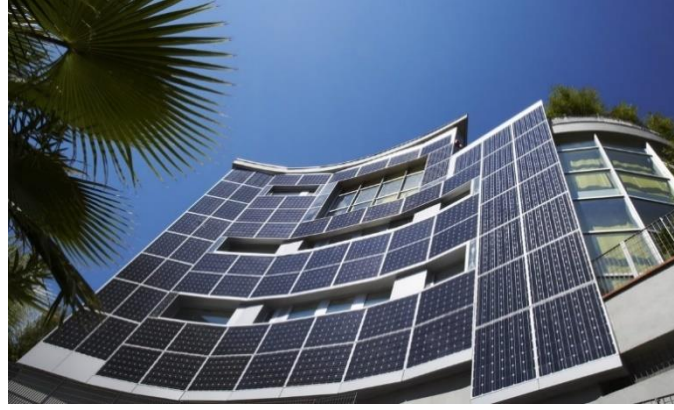
Şekil 2.23 Fotovoltaik sistemlerin perde duvarlarda kullanımına ait bir örnek [30]
