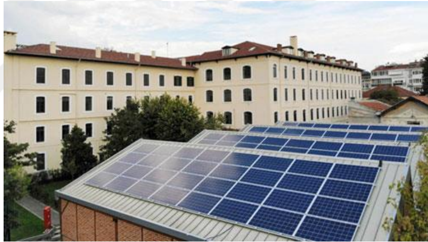
Şekil 2.19 Fotovoltaik şet çatı uygulaması [27]
