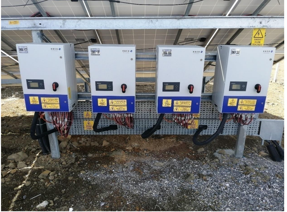
Şekil 5.7 Sistemde kullanılan inverterlere ait resim.
