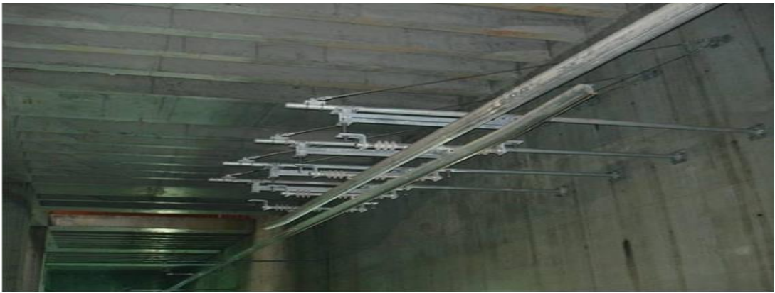
Şekil 4.4. Rijit Kataner Sistemi [84]
