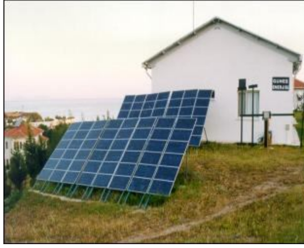
Resim 1.2 EİE'nin 4,8 kWp gücünde şebeke bağlantılı PV pil sistemi (İnt. Kyn. 3).
