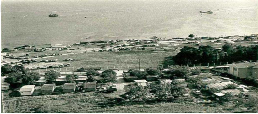
Şekil 3.3. Eski avcılar ilçesinden bir görünüm (Anonim 2017c)
