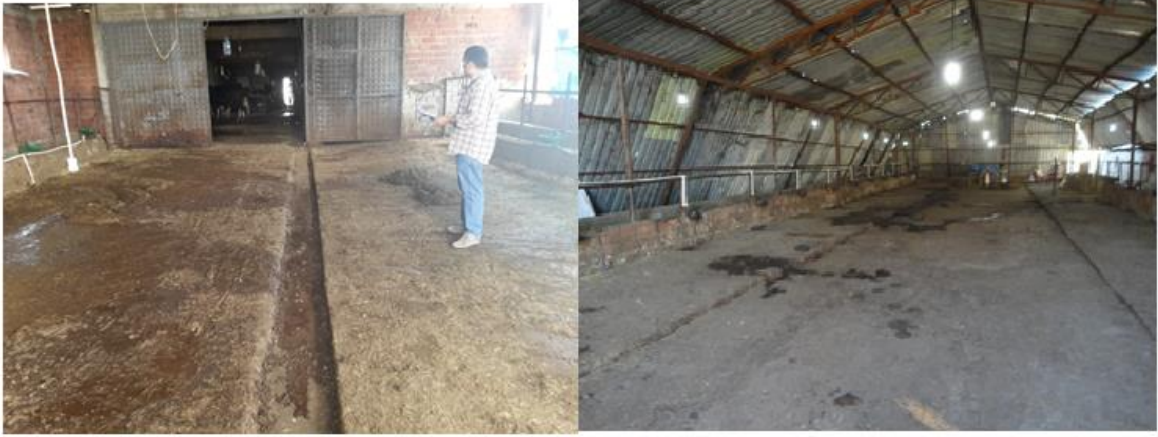
Şekil 4.3. İdrar kanalı ve servis yolu düzgün planlanmamış ahırlar
