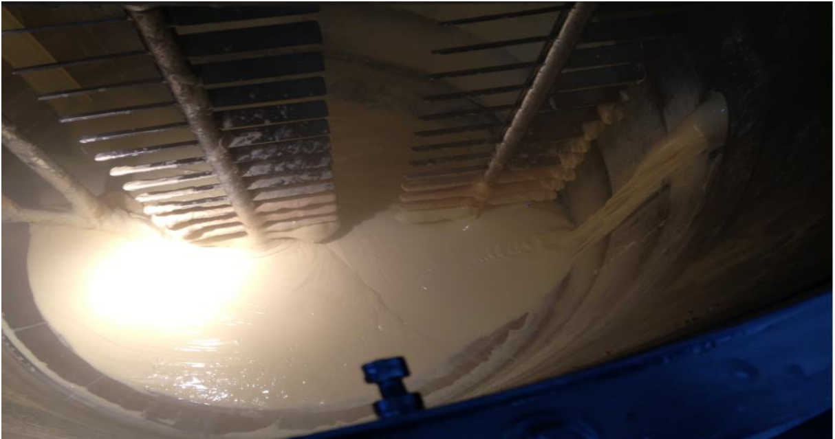
Şekil 3.8. UHT sonrası buffer tank görünümü
