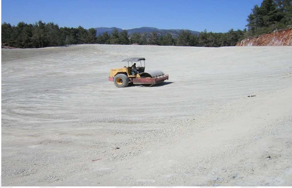
Şekil 2.4. Kil Geçirimsizlik Tabakasının Sıkıştırılması İşlemi
