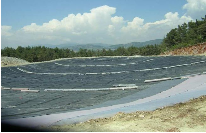
Şekil 2.5. Geomembran Serilmesi
