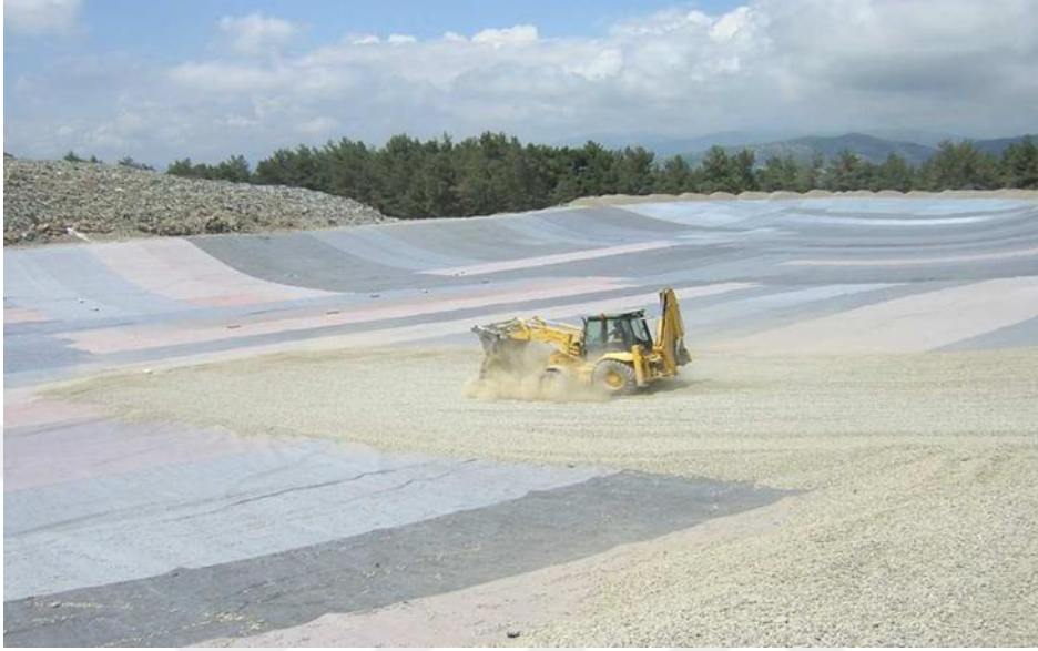
Şekil 2.7. Drenaj İçin Filtre Çakılı Serilmesi
