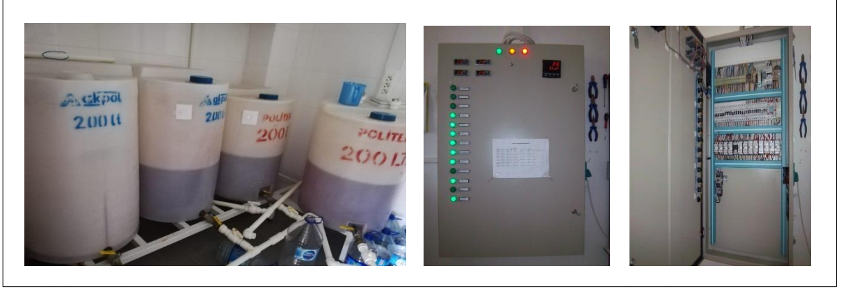
Şekil 3.4. 200 litre hacmindeki Hoagland çözelti ile doldurulmuş plastik tanklar ile iklim odası otomatik kontrol panosunun görünümü
