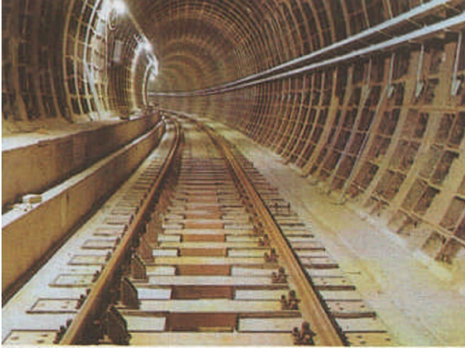
Resim 2.8 Tünel içerisinde plastik travers uygulaması (Anonim 2008)
