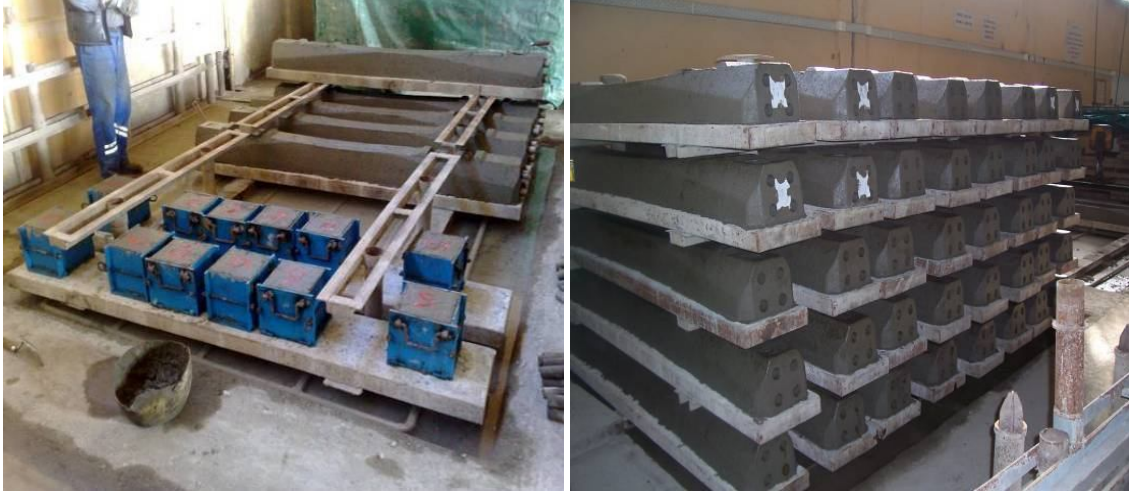
Resim 3.25 Üretilen küp ve beton traverslerin buhar kürü için istiflenmesi
