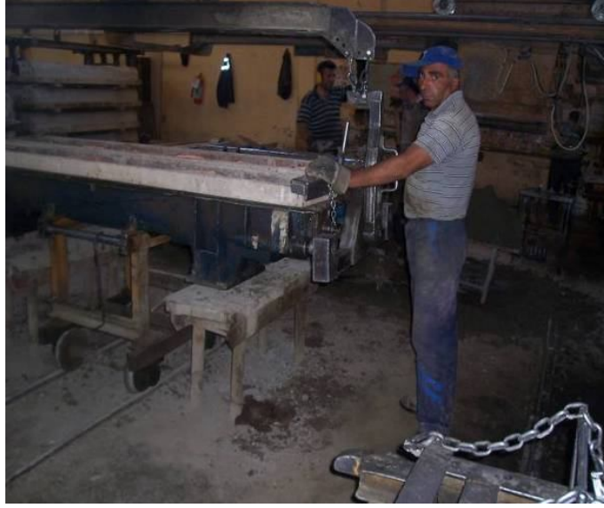
Resim 3.22 Beton travers kalıbına döndürme düzeneğinin takılması
