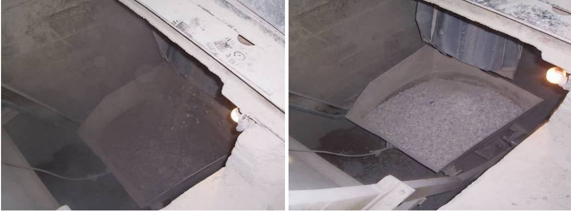
Resim 3.17 Ağırlık esasına göre tartılan malzemenin betoniyere alınması
