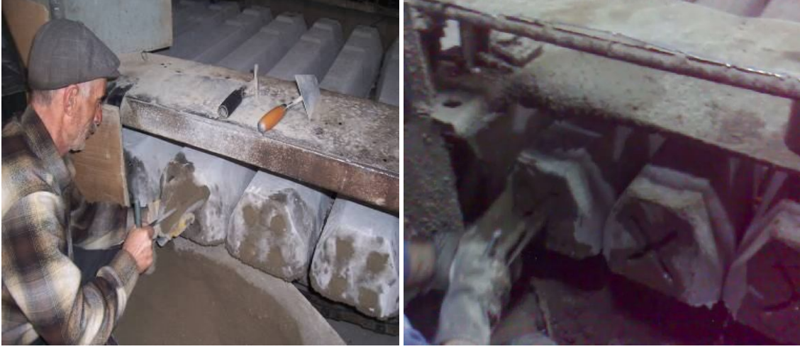
Resim 3.31 Traverslerin krozet ve öngerilim uçlarının kalafat harcı ile doldurulması
