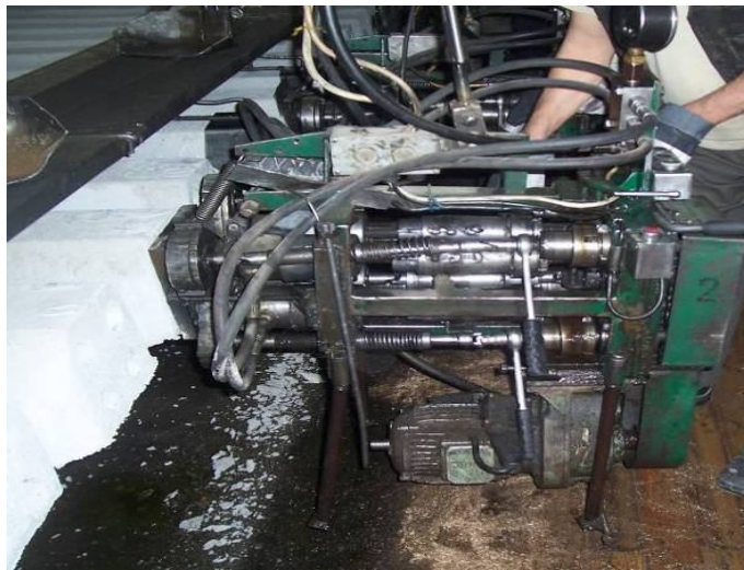
Resim 3.28 Beton traverslere öngerme yükünün uygulanması
