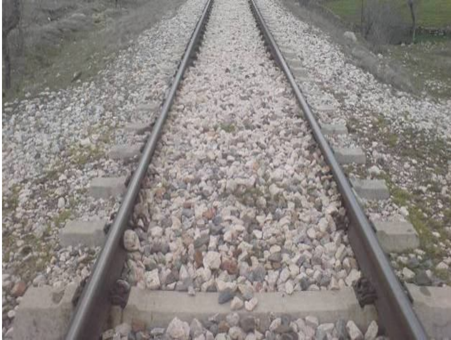
Resim 2.5 Beton travers uygulaması
