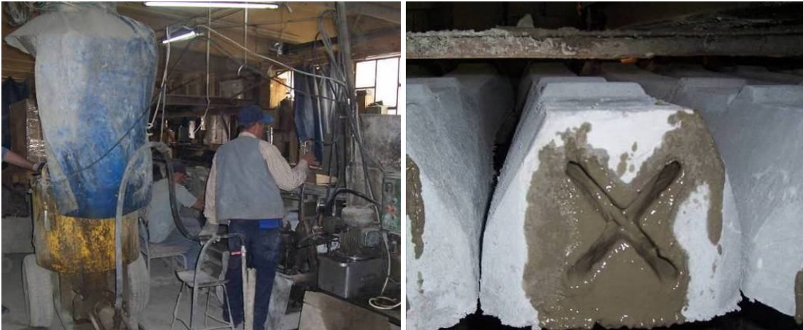
Resim 3.30 Beton şerbetinin beton travers kanallarına sıkılması
