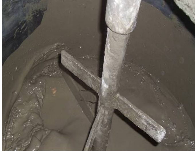
Resim 3.29 Beton şerbetinin hazırlanması
