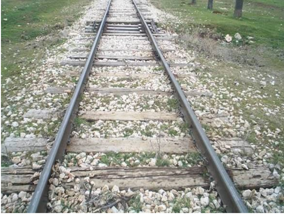
Resim 2.2 Ahşap travers uygulaması
