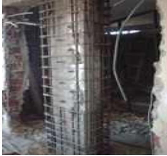
Şekil 2.2 Betonarme yapıda kolona mantolama yapılması (Kocaman 2008)
