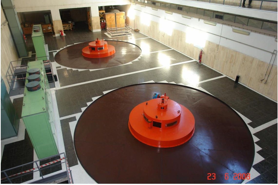
Resim 1.3. Adıgüzel HES Senkron Generatörler
