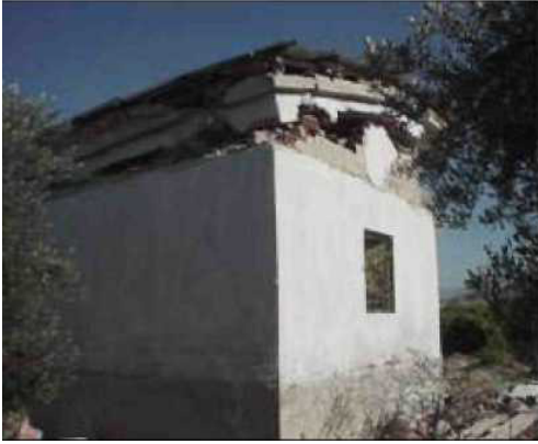
Şekil 3.41: Daha önce hasar gören yapının üst katı artçı depremler ile yıkılmıştır
