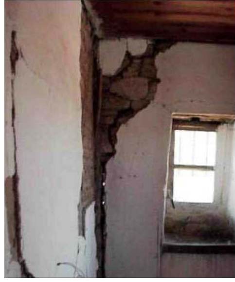
Şekil 3.20: Köşede meydana gelen hasarın dıştan ve içten görünüşü
