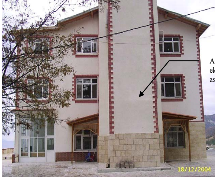
Şekil 4.7: Ana binaya sonradan eklenen asansör kovası
