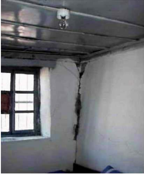
Şekil 3.30: Hasar gören yapıda köşe noktalarının görünüşü
