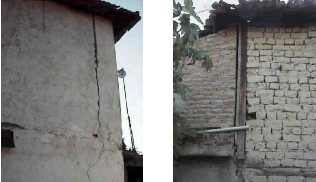
Şekil 3.37: Köşelerde meydana gelen ayrışmalar.
