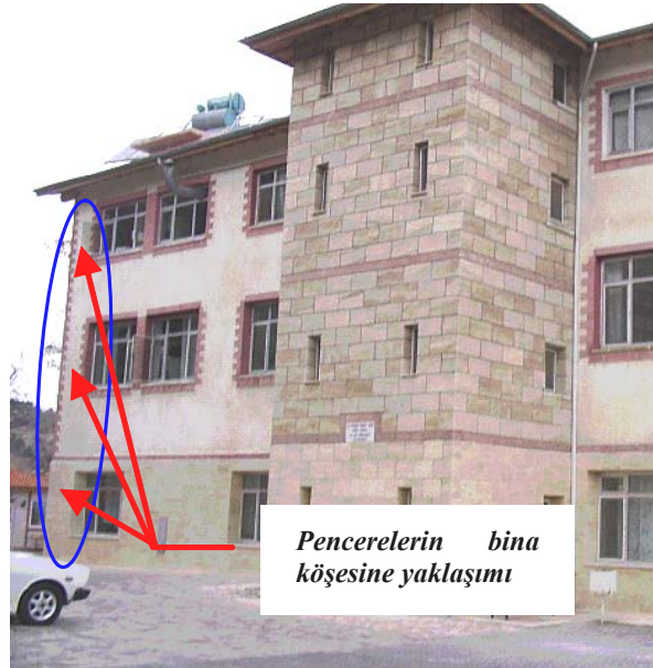
Şekil 4.24: Bina köşesinde pencerelerin yerleşimi
