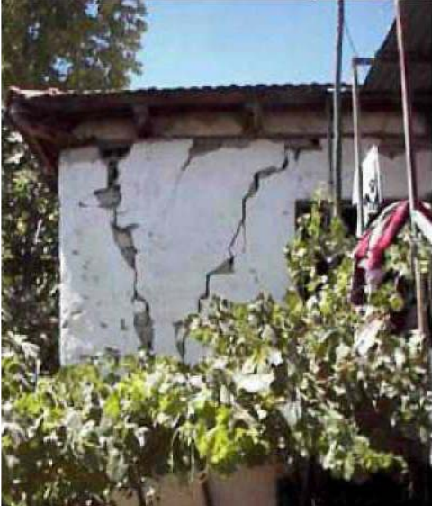
Şekil 3.20: Köşede meydana gelen hasarın dıştan ve içten görünüşü
