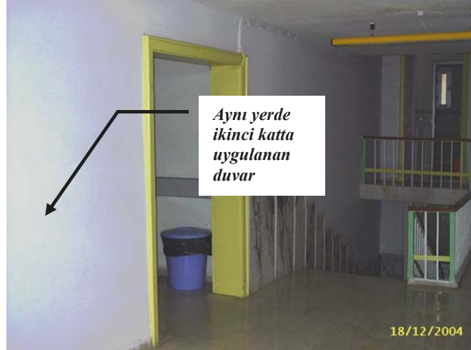
Şekil 4.22: Aynı yerde, ikinci katta uygulanan duvar
