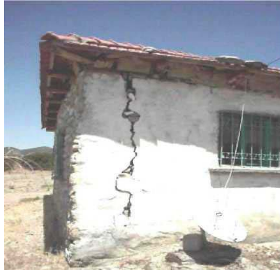
Şekil 3.25: Birleşim bölgesinde ayrışma
