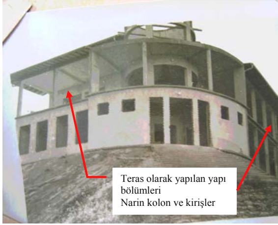
Şekil 4.25: Hastane binasının inşaat aşaması (Seyirlik terasları)
