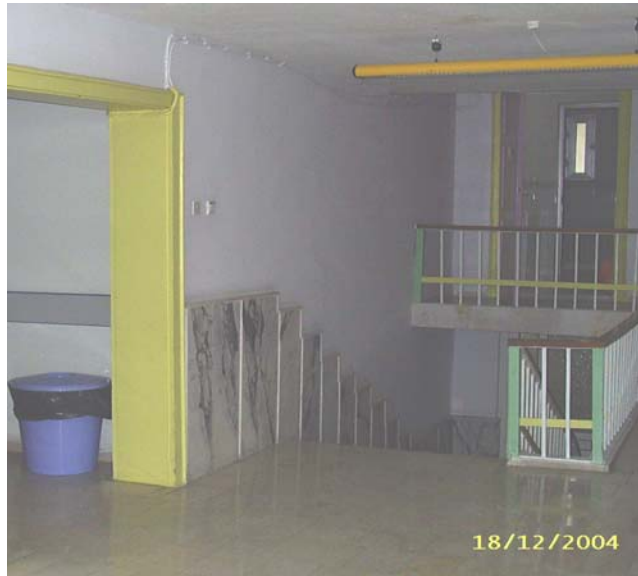
Şekil 4.18: Mermer kaplı döşeme plağı
