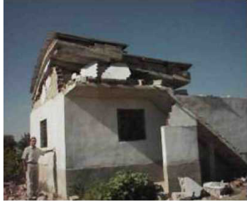
Şekil 3.41: Daha önce hasar gören yapının üst katı artçı depremler ile yıkılmıştır
