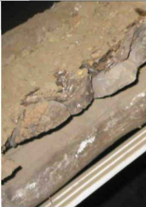
Şekil 3.8: Yıkılan evlerin damında kullanılan taş ve toprak örtü
