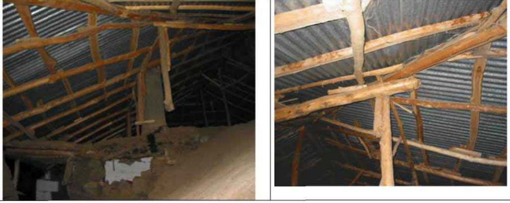
Şekil 3.9: Su izolasyonu için yapılan çatı
