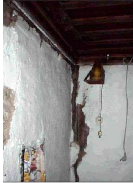
Şekil 3.30: Hasar gören yapıda köşe noktalarının görünüşü
