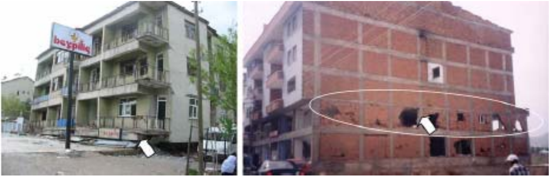
Şekil 2.5 : Deprem enerjisinin tek bir katta yoğunlaşması
