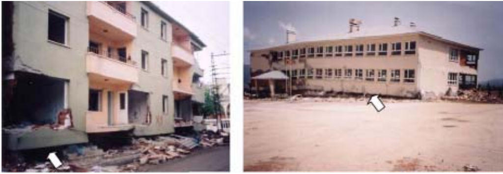
Şekil 2.3 : 2003 Bingöl depreminde yumuşak kat nedeniyle göçen binalar
