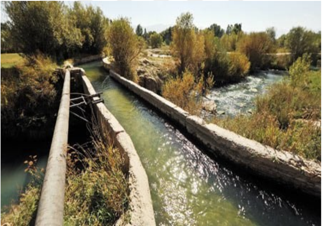
Resim 3: Urartu Şamram Su Kanalları. (Bildirici, 1994: 425).
