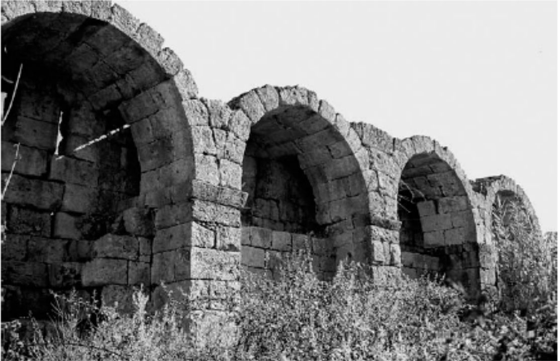
Resim 22: Güney Surlarda Kazematlı Sur Duvarı
