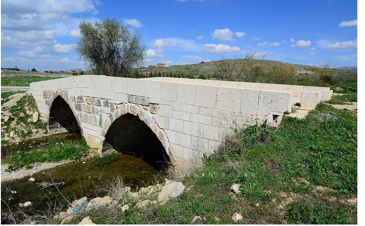
Resim 109 Afşar Köyü Köprüsü
