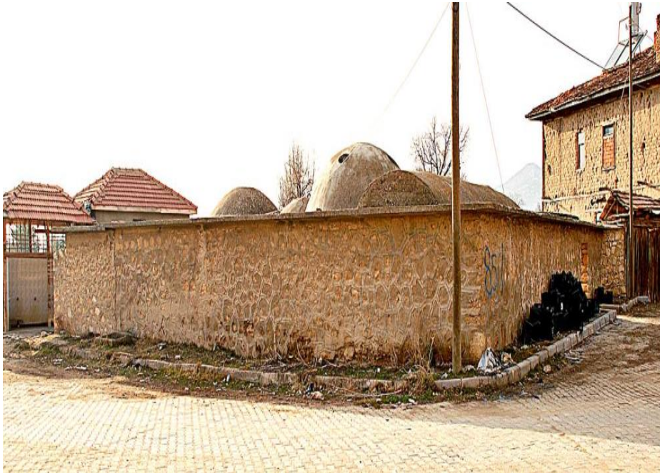
Resim 108 Afşar Köyü Hamamı
