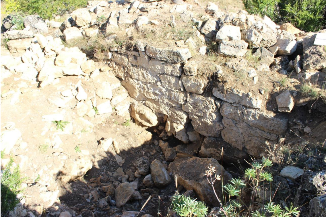
Resim 88. Kaledibi Kilisesi duvar örgüsü
