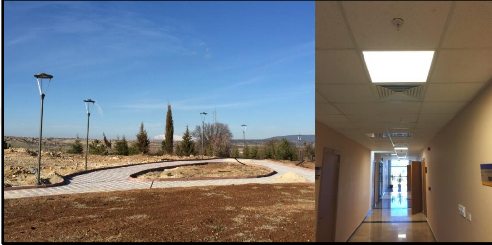
Şekil 6.7. MAKÜ Rektörlük binası bina içi ve çevre led aydınlatma sistemleri (Özipek arşivi, 2017)
