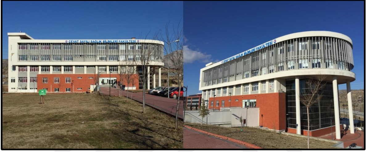
Şekil 6.11. Cevat Sayılı Sağlık Bilimleri Binasının Cephesindeki Güneş Kırıcıları (Özipek arşivi, 2017)
