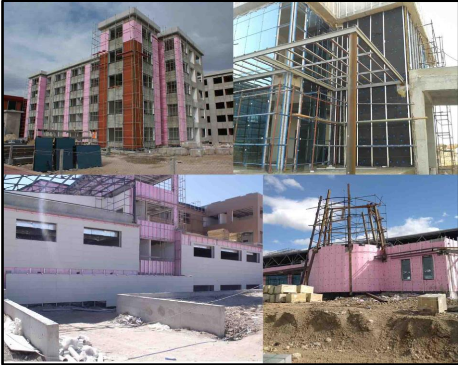
Şekil 6.6. İstiklal Yerleşkesi Binalarında Yapılan Mantolama Çalışmaları (Özipek arşivi, 2015)
