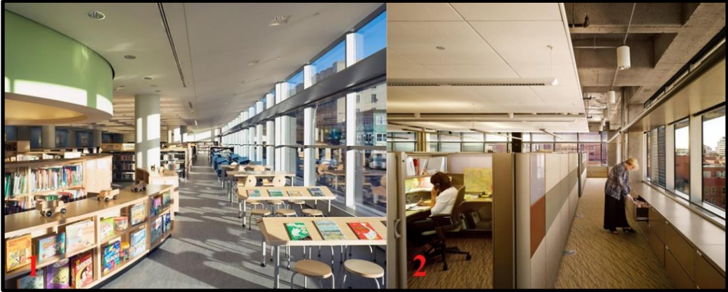
Şekil 6.18. Işık rafı uygulamaları (1. URL-48 (Bronx Kütüphane Merkezi, New York, ABD) - 2. Chen, R., 2011. 112 s.(Çevre Koruma Ajansı, Bölge 8 Genel Müdürlük Binası, Denver, ABD))
