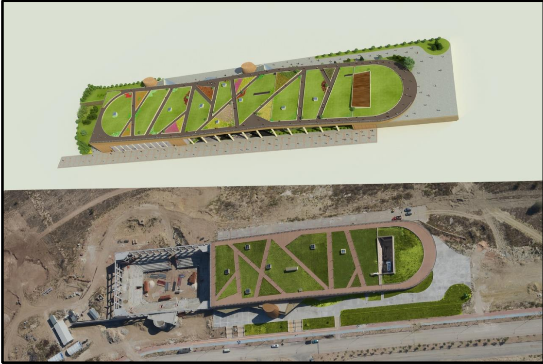
Şekil 6.25. MAKÜ kapalı spor salonu (gezilebilir yeşil çatı uygulaması) (Özipek arşivi, 2017)
