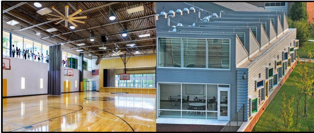
Şekil 6.20. Manassas Park İlköğretim Binasının çatısındaki ve iç mekânların doğal ışık aydınlatmaları, ışık tüpleri (Chen, R., 2011. 31-33 s.)
