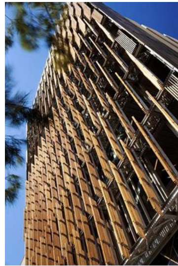
Şekil 2.19. CH2 Binası Melbourne, Avustralya (URL-8, 2019)
