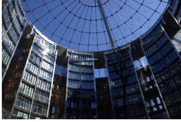
Şekil 4.11. Gazometre D çatının iç mekandan fotoğrafı (URL-11, 2018)
