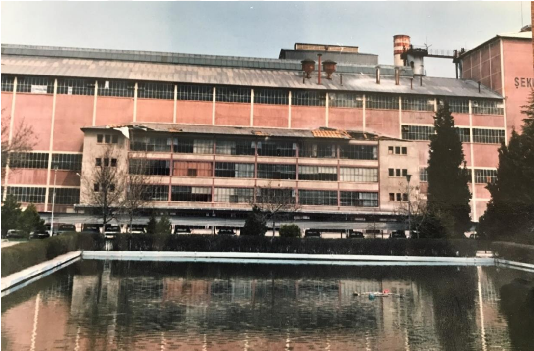
Şekil 6.30. Fabrika ve işletme binası (Yılmaz Özev, 2017)
