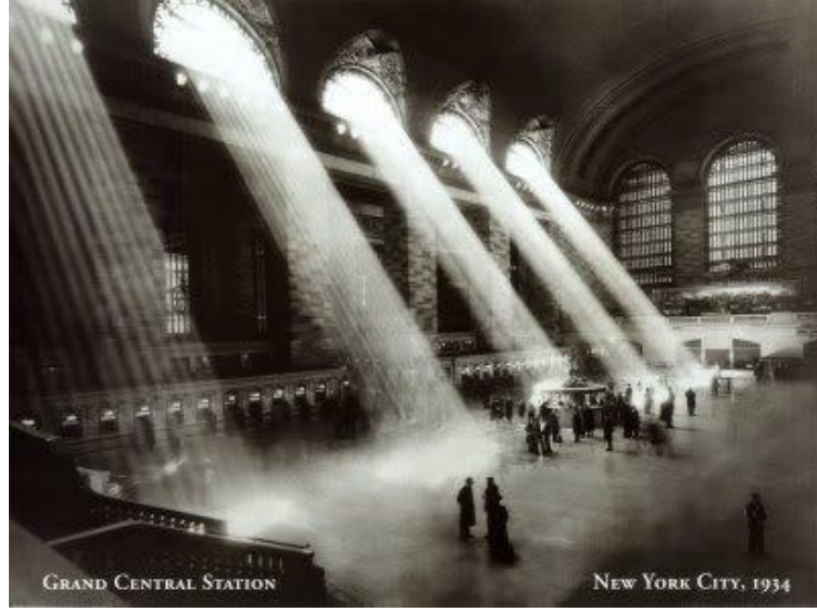
Şekil 4.23. Tren Garı iç cephe fotoğrafı (URL-21, 2019)
