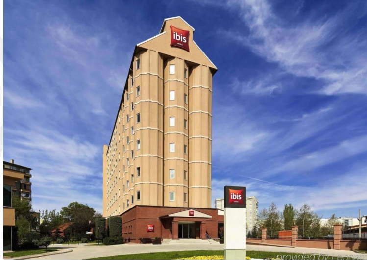
Şekil 3.2. Eskişehir İbis Otel eski un fabrikası siloları (URL-9, 2019)
