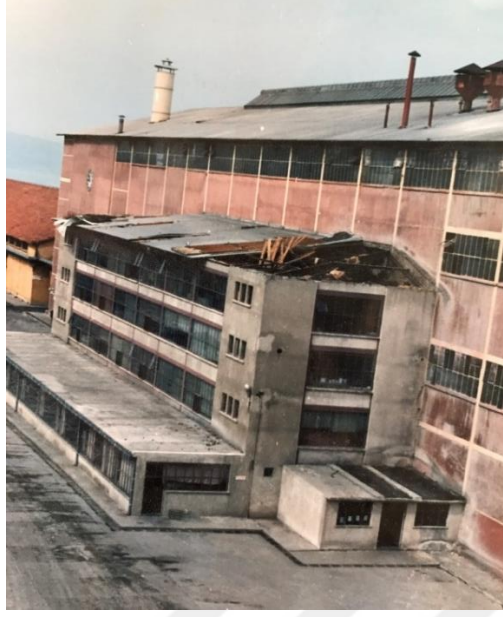
Şekil 6.37. Fabrika ve işletme binası (Yılmaz Özev, 2017)
