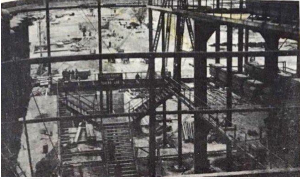
Şekil 6.19. Montaj esnasında iç mekan fotoğrafı (Anonim, 1955)
