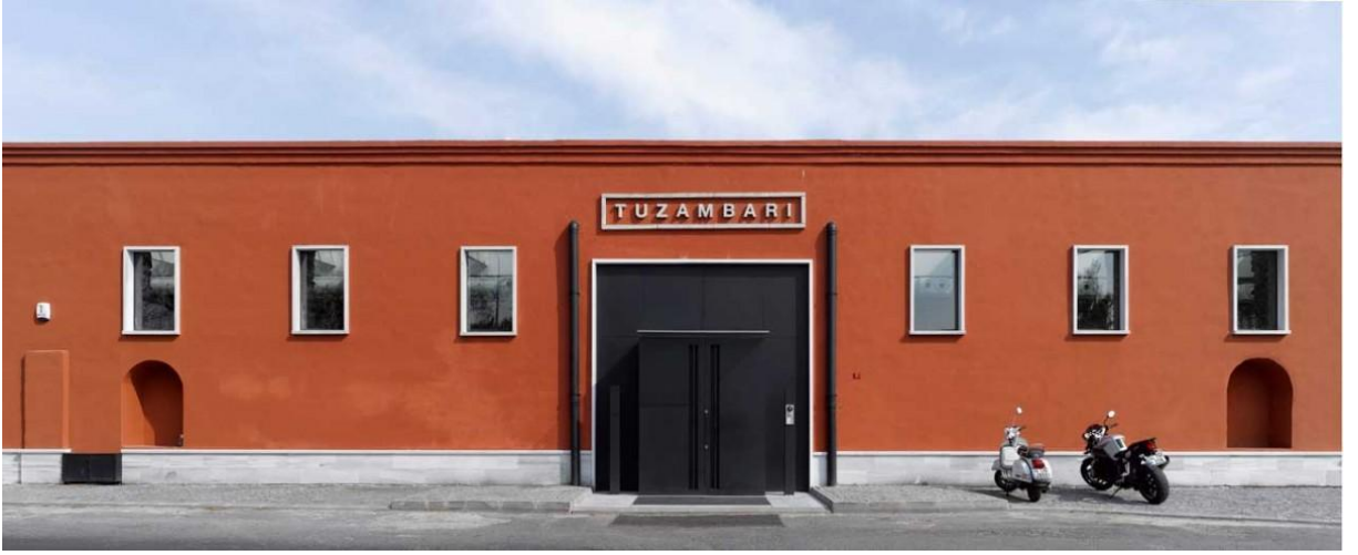
Şekil 5.21. Kasımpaşa Tuz Ambarı dönüşüm sonrası ön cephe fotoğrafı (URL-35, 2019)
