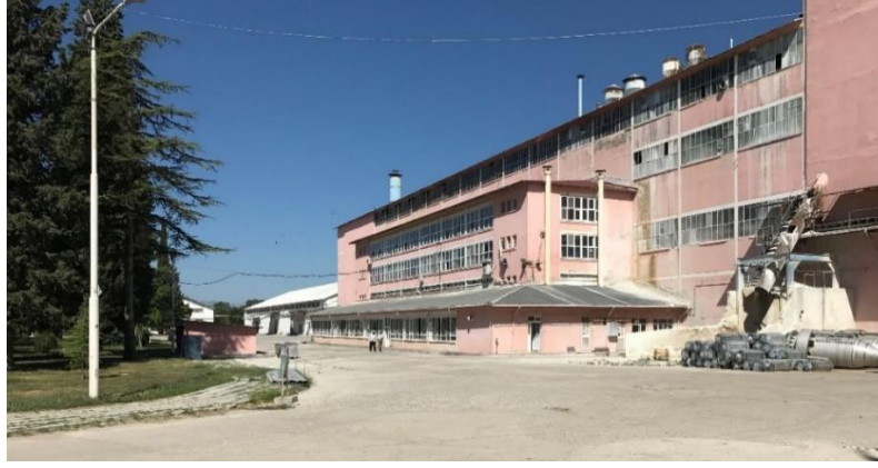
Şekil 6.35. Fabrika ve işletme binası (Yılmaz Özev, 2018)
