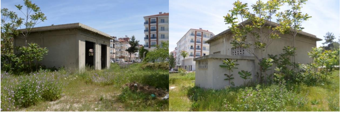
Şekil 6.80. Gül yağı depo binası fotoğrafları (Yılmaz Özev, 2019)
