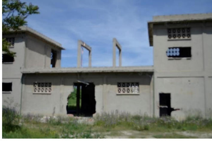
Şekil 6.75. Gül yağı üretim binası yol cephesi fotoğrafı (Yılmaz Özev, 2019)
