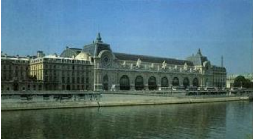
Şekil 4.22. Tren Garı ön cephe fotoğrafı (URL-20, 2019)
