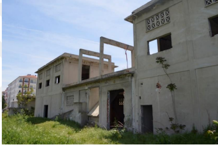
Şekil 6.76. Gül yağı üretim binası arka cephesi fotoğrafı (Yılmaz Özev, 2019)
