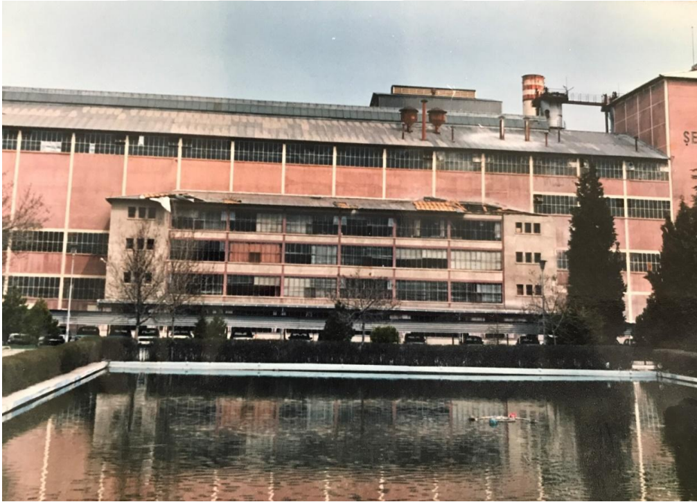
Şekil 6.24. Burdur Şeker Fabrikası ön cephe fotoğrafı (Yılmaz Özev, 2017)
