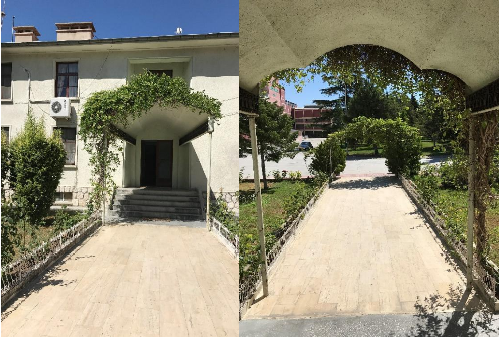
Şekil 6.42. Ofis binası ön görünüşü (Yılmaz Özev, 2018)
