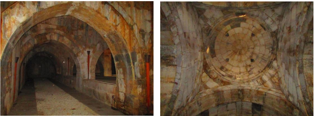
Şekil 4.24. Susuz Han iç mekânı sol sahnın ve kubbe (Bakır, 2017)
