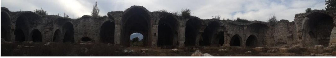
Şekil 3.11. Evdir Han avludan portal ve cephesinin görünüşü (Bakır, 2017)
