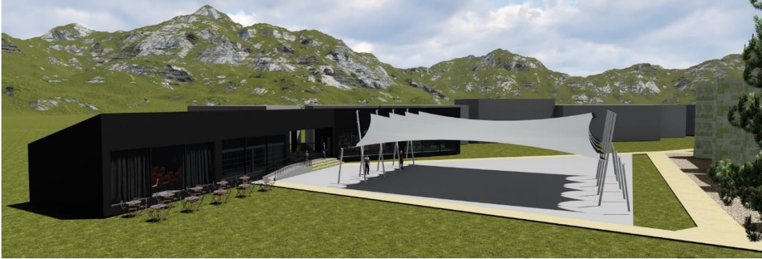
Şekil 5.33. Alternatif 8: İhtiyaç duyulması durumunda yapılabilecek, membran malzemesi ve alüminyum profil kullanılarak oluşturulmuş üst örtü (Modelleme ve Görselleştirme: Bakır D. R.)
