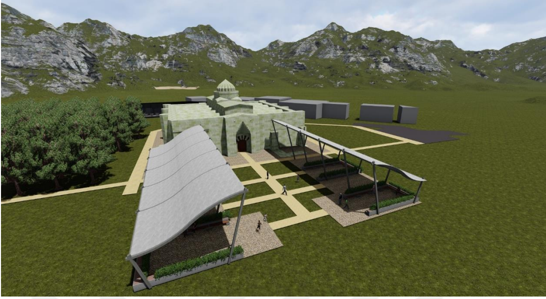
Şekil 5.12. Alternatif 3: Membran malzemesi ve alüminyum profil kullanılarak oluşturulmuş üst örtü (Modelleme ve Görselleştirme: Bakır D. R.)
