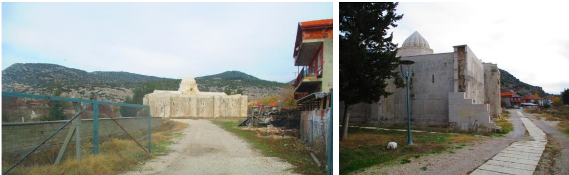
Şekil 4.13. Susuz Han'ın ve avlusunun güney ve kuzeyden görünüşü (Bakır, 2017)
