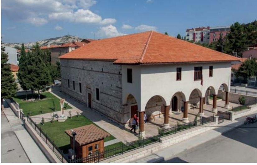
Şekil 2.19. Burdur Doğa Tarihi Müzesi mevcut durumu (Alpagut, 2016)
