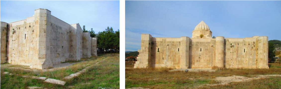
Şekil 4.16. Susuz Han doğu ve güney cephesi (Bakır, 2017)
