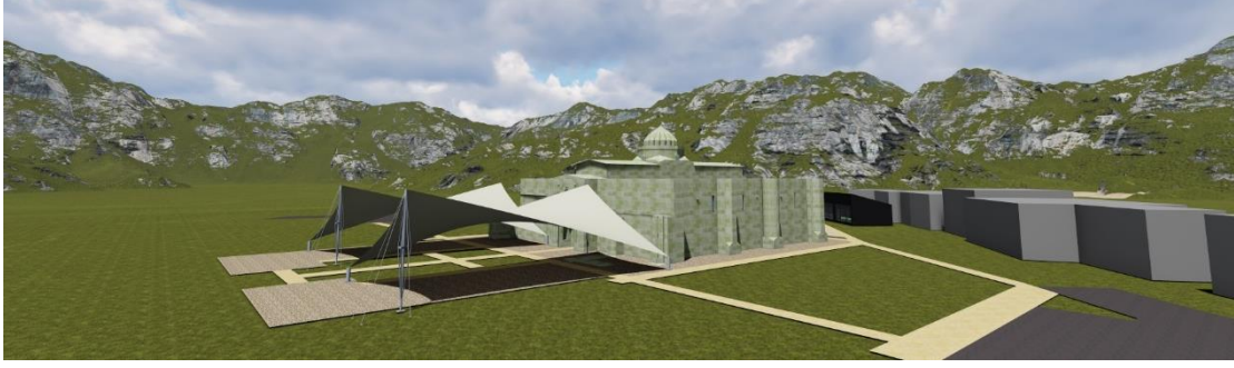
Şekil 5.24. Alternatif 6: Membran malzemesi ve alüminyum profil kullanılarak oluşturulmuş üst örtü (Modelleme ve Görselleştirme: Bakır D. R.)
