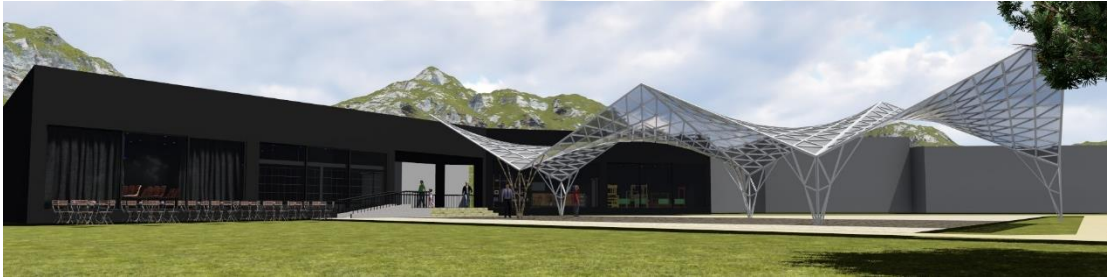
Şekil 5.22. Alternatif 5: Termokromik - elektrokromik tabakalı camlar kullanılarak oluşturulmuş üst örtü (Modelleme ve Görselleştirme: Bakır D. R.)
