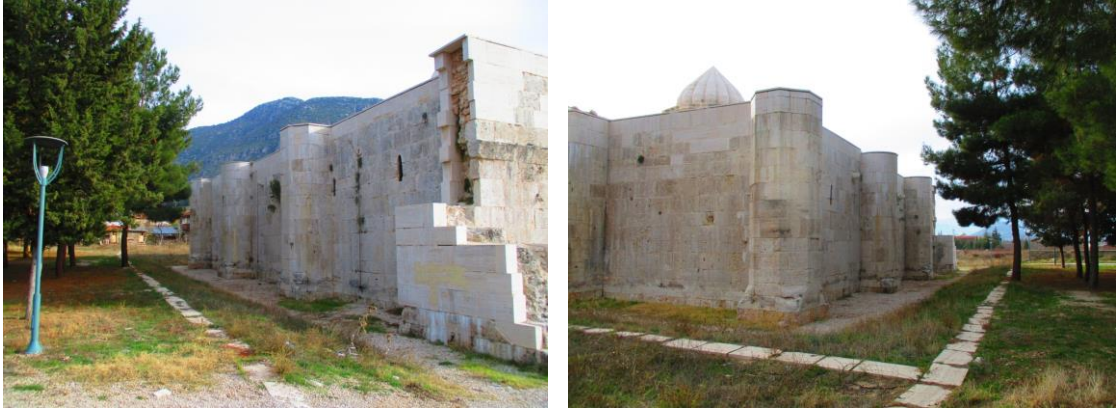
Şekil 4.14. Susuz Han kuzey cephesi (Bakır, 2017)
