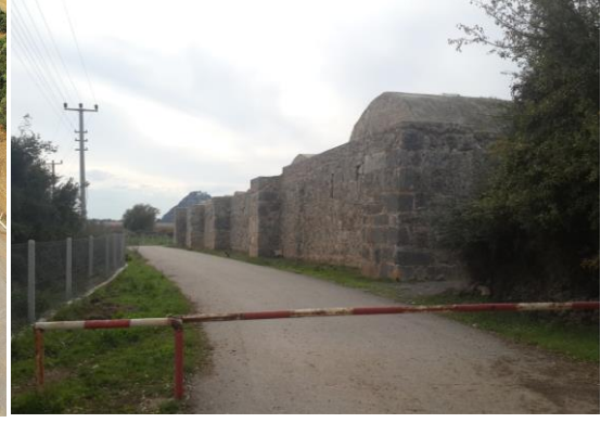
Şekil 3.26. Kırkgöz Han yapı alanı girişi (Bakır, 2017)
