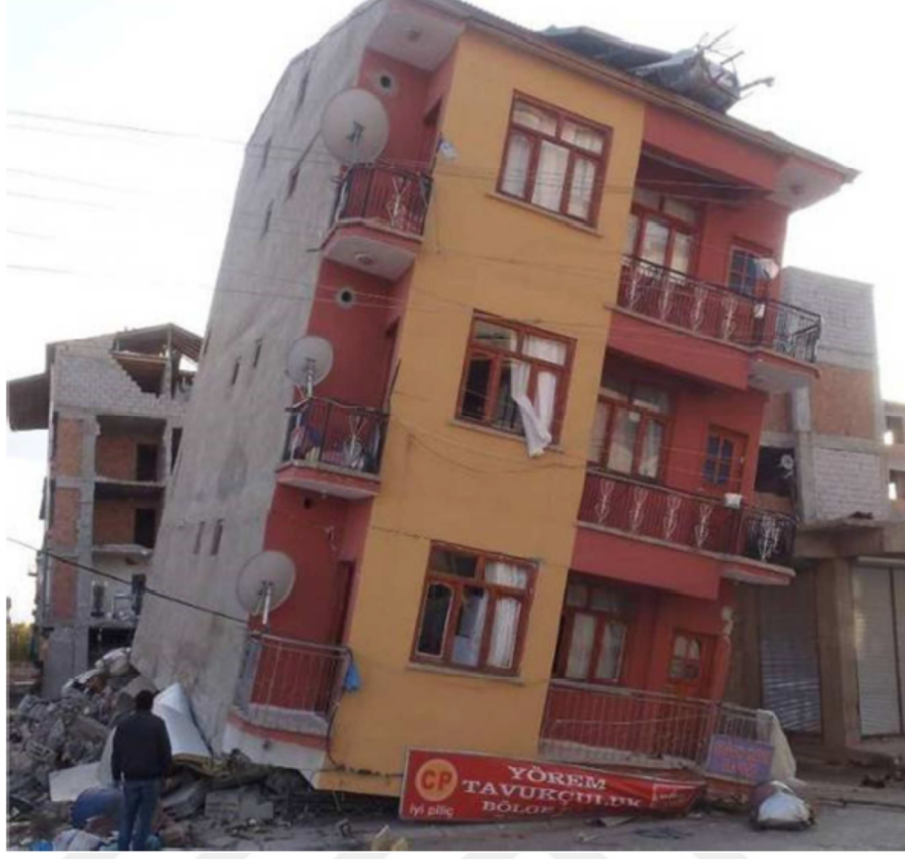
Şekil 2.5: Yumuşak kat sebebiyle giriş katı göçmüş bir bina, Van Depremi, 2011 (İnel vd., 2011)
