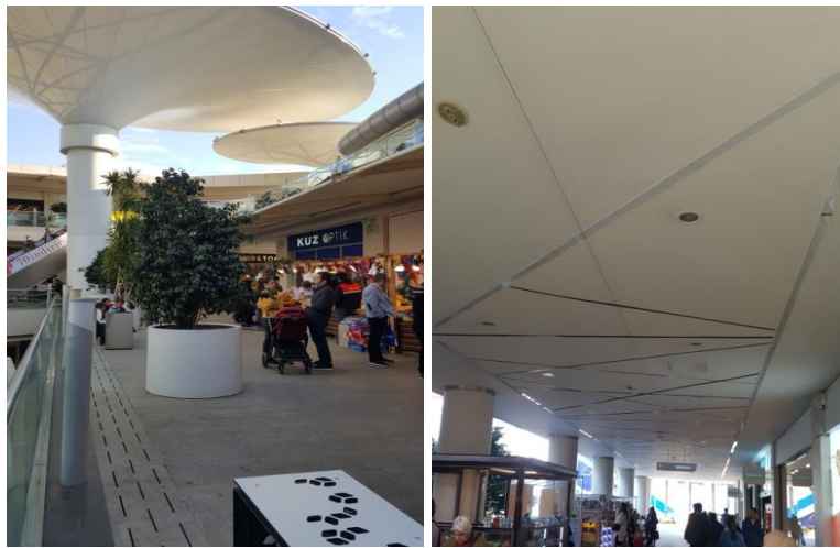
Şekil 4.28. Erasta AVM dış mekan aydınlatma
