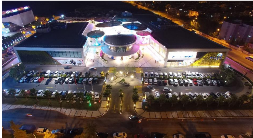
Şekil 4.20. Yapının genel görünümü (Anonim, 2017h)
