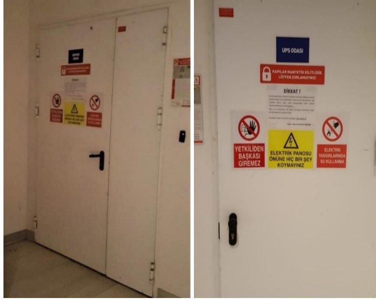
Şekil 4.40. Merkezde bulunan Server ve UPS odası
