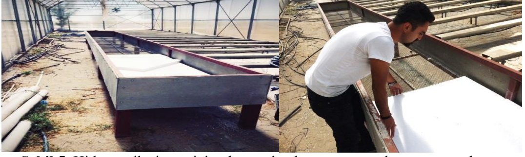
Şekil 5. Hidroponik sistem için oluşturulan havuzun ısı yalıtımının yapılması
