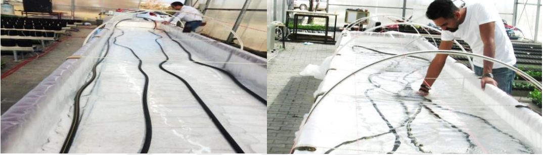
Şekil 6. Termostatlı ısıtma düzeneğinin havuz içerisine yerleştirilmesi
