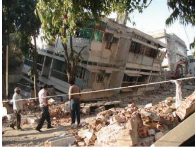
Şekil 2.5: İlk katı yumuşak kat sebebiyle çökmüş bina
