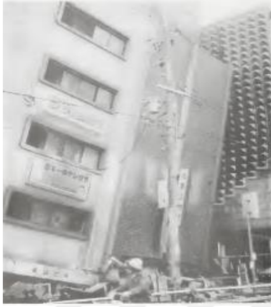
Şekil 2.3: 1995 Kobe depreminde bir binanın göçmesi
