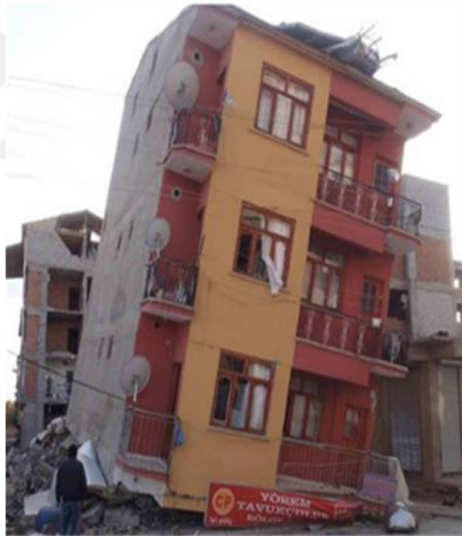
Şekil 2.4: Yumuşak kat düzensizliği nedeniyle zemin katı çökmüş bir bina görüntüsü, Van depremi 2011 (İnel ve diğ., 2012)
