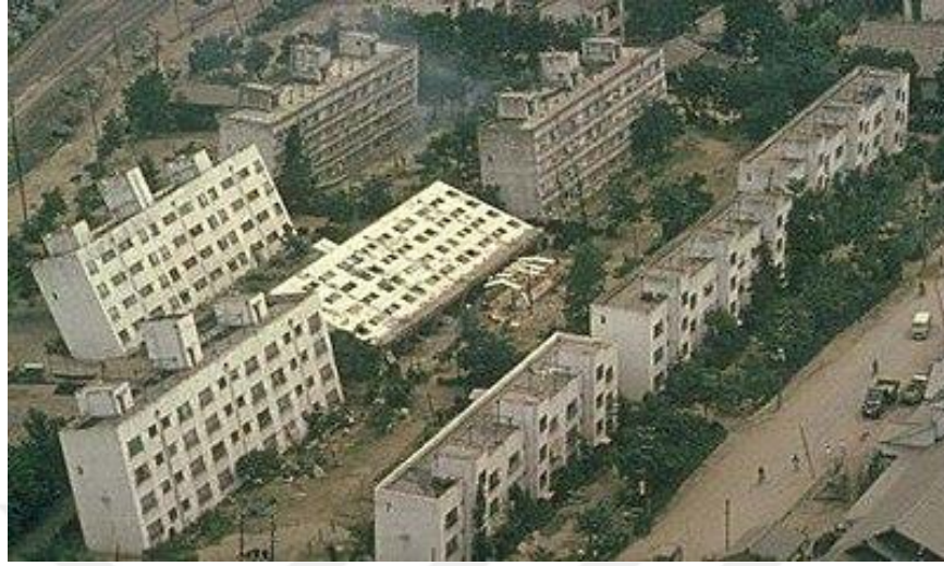
Şekil 2.8: 1964 Niigata depremi sonrasında zemin sıvılaşması sebebiyle oluşan hasarlar
