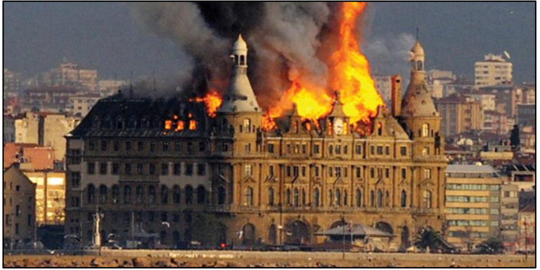
Şekil 2.9: Haydarpaşa Garı'nda meydana gelen yangına ait görsel
