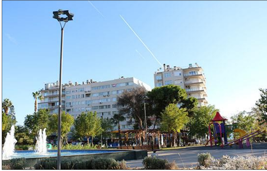
Resim 16. Yavuz Özcan Parkı içerisinde yer alan akıllı aydınlatma direğinden bir görüntü
