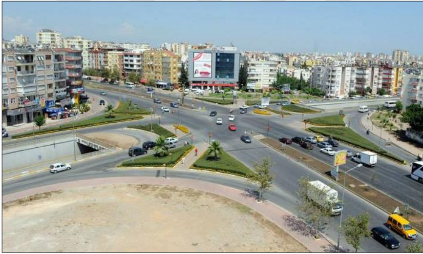
Resim 18. Sinyalizasyon sistemiyle akıllı kavşağa dönüştürülen Mevlâna Kavşağı
