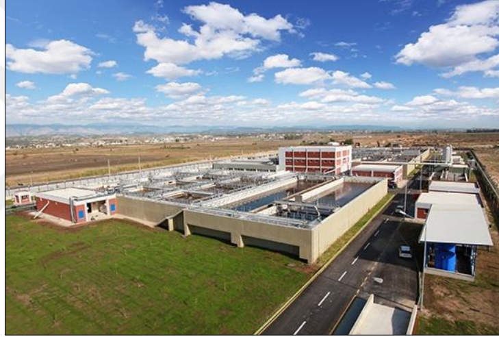
Resim 25. Serik akıllı arıtma tesislerinden bir görüntü, Kaynak: Antalya Büyükşehir Belediyesi Su ve Kanalizasyon İşleri Genel Müdürlüğü
