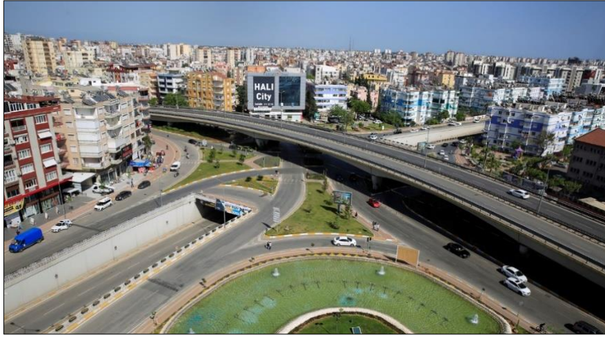
Resim 19. Sinyalizasyon sistemlerinin yetersiz kalması nedeniyle fiziki altyapısı değiştirilerek üç katlı akıllı kavşağa dönüştürülen Mevlâna Kavşağı
