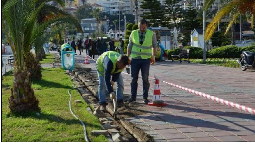
Resim 15. Park ve orta refüjlere akıllı sulama sensörlerinin yerleştirilmesi Kaynak: Antalya Büyükşehir Belediyesi
