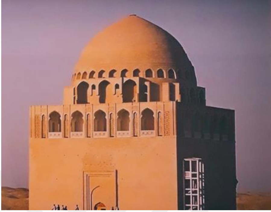
EK 15 Sultan Sanjar Türbesi Restorasyon sonrası
