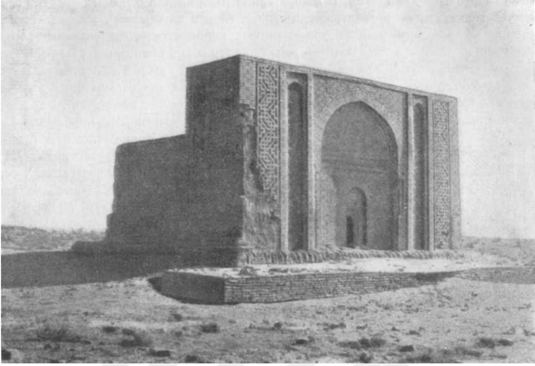
EK 9 Hüdanazar Evliya Türbesi Doğu Cephesi (Pugaçenkova, 1958:311).
