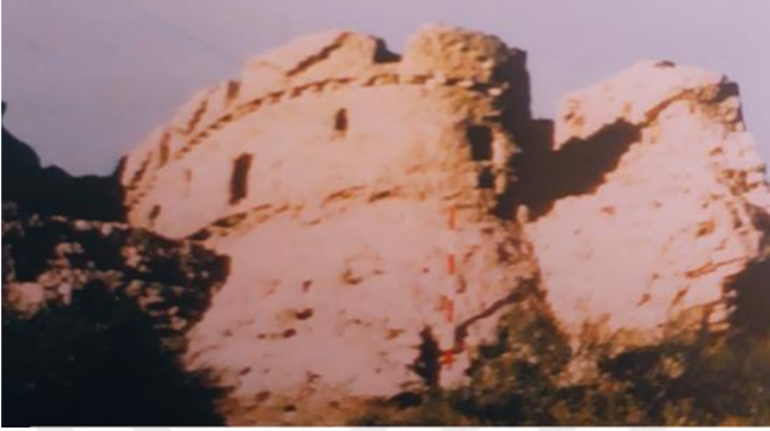
EK 3 Sultankale Sur Duvarı Güney Cephesi (Jepbarov, 2017:37)
