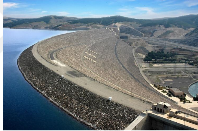
Resim 2.8 Kil Çekirdekli Kaya Dolgu Baraj Örneği (Atatürk Barajı).
