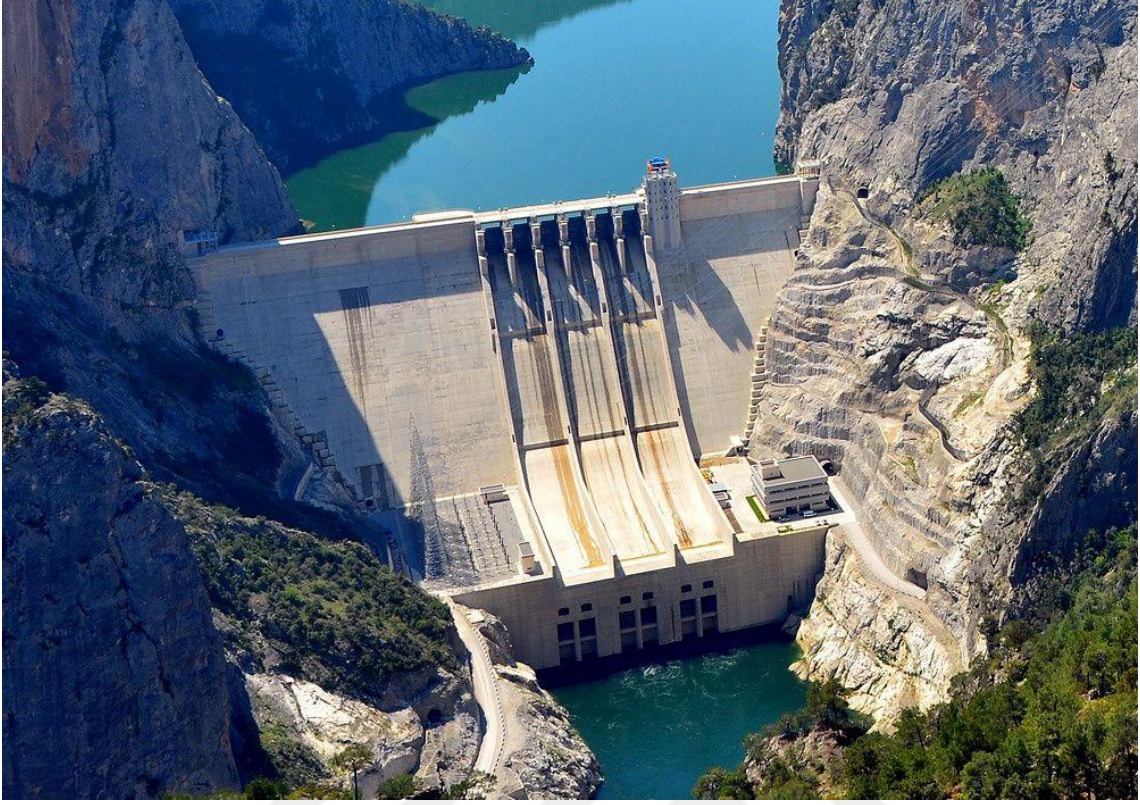
Resim 2.2 Beton Ağırlık Baraj Örneği (Boyabat Barajı).
