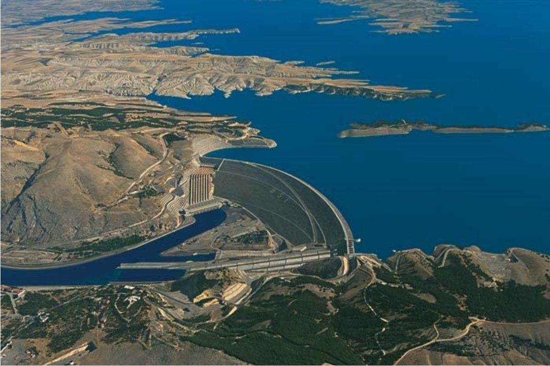
Resim 2.4 Beton Kemer Baraj Örneği (Oymapınar Barajı).
