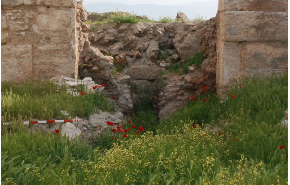
Resim 27. Merkezi Hamam Caldariumununun Kuzey Havuzu.
