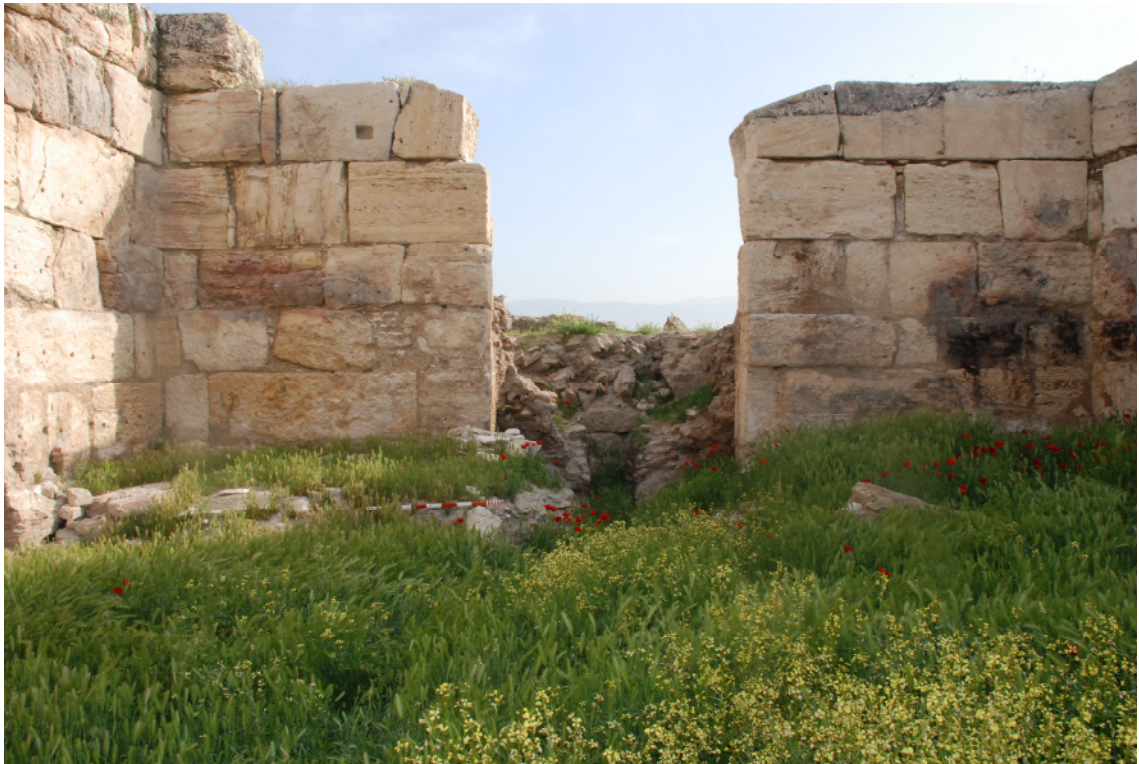
Resim 25. Merkezi Hamam Caldariumunun Kuzey Külhanı.
