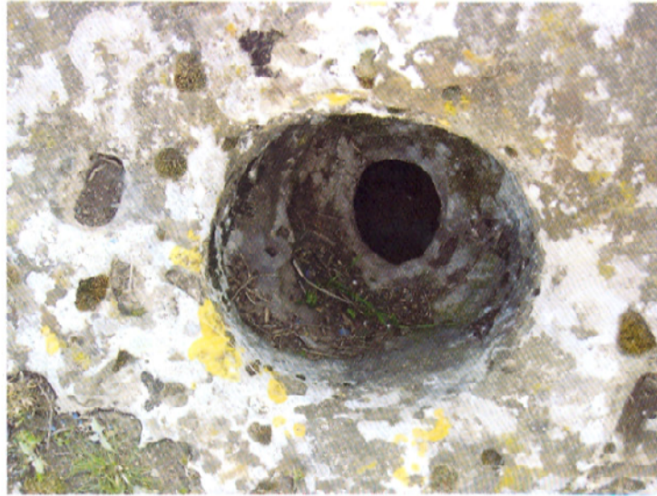
Resim 10. Laodikeia' ya su sađlayan traverten ikiz hat ve traverten hat üzerinde yer alan emniyet ve temizleme deliđi. (Şimşek 2007, Res. 29d, 29e)
