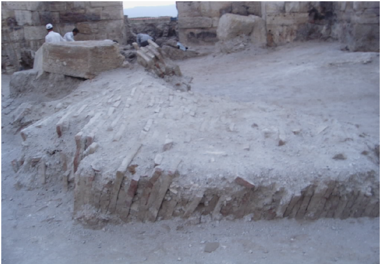
Resim 23. Merkezi Hamam Caldariumu Tonoz Tuğlaları.
