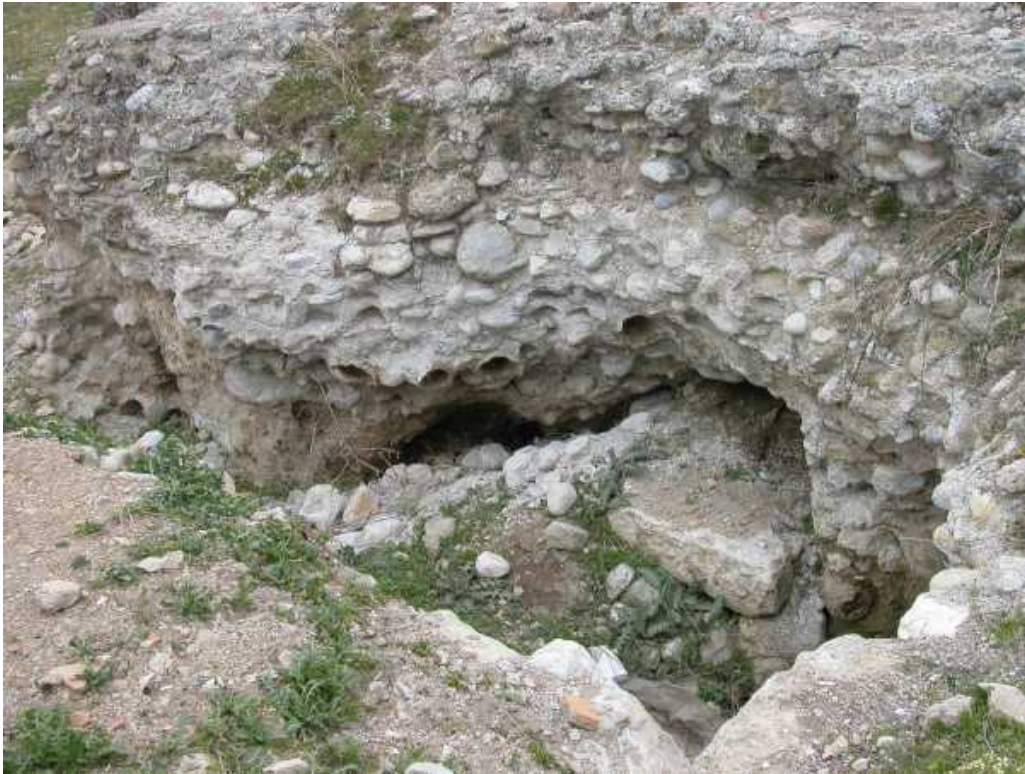
Resim 14. II. Su Dağıtım Terminali. (Laodikeia kazı arşivinden alınmıştır)
