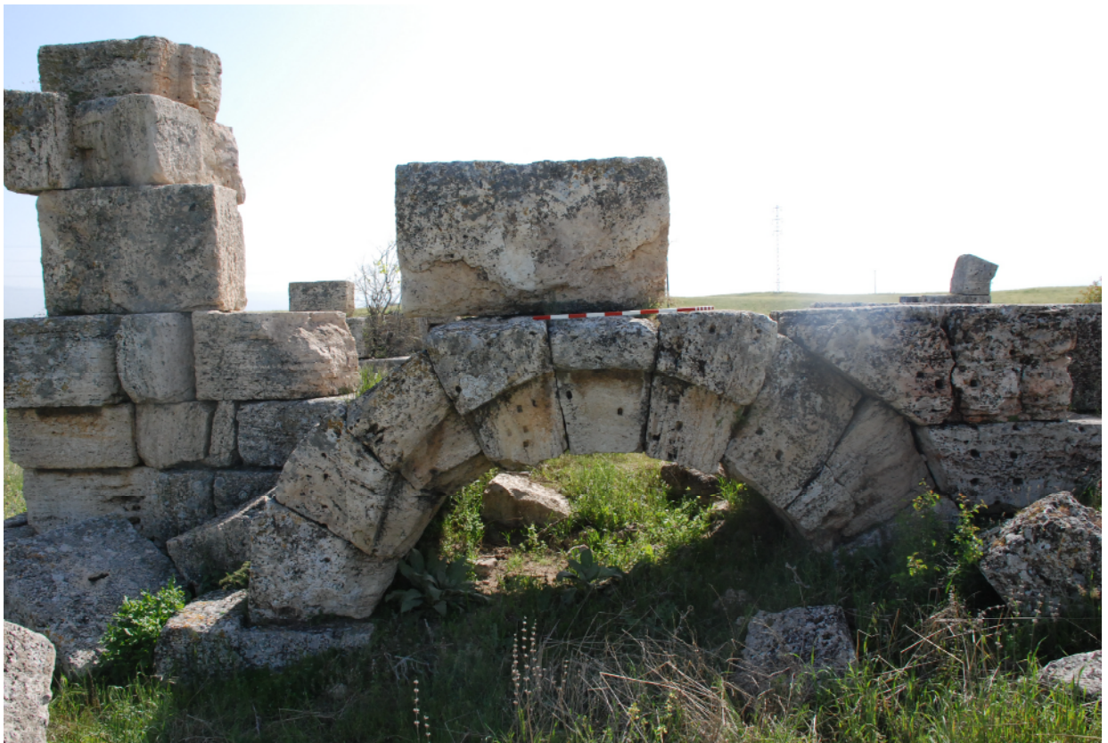
Resim 56. Batı Hamamı Caldariumu Kemerleri.
