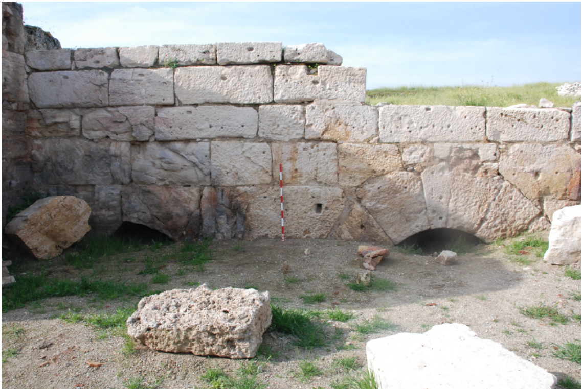
Resim 35. Merkezi Hamam Tepidariumundaki ısıtma sistemi.
