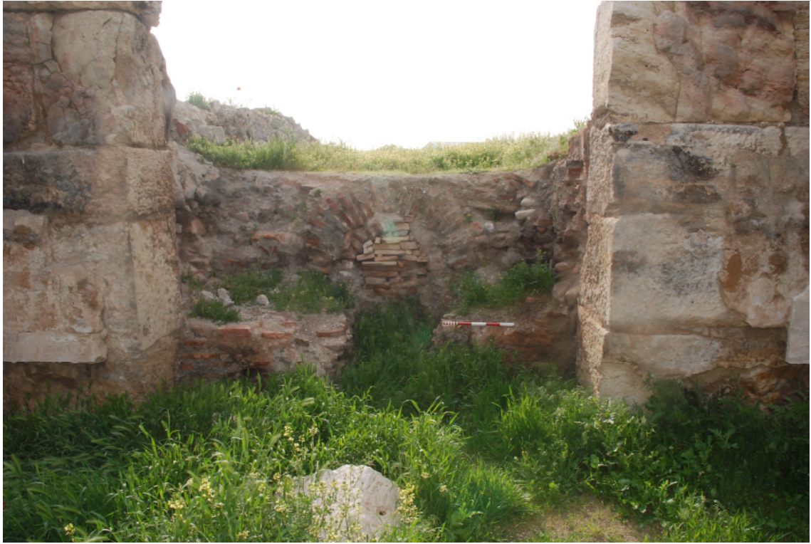
Resim 24. Merkezi Hamam Caldariumunun Doğu Külhanı.
