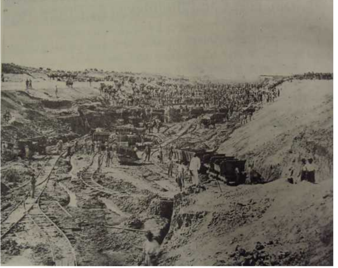
EK-40 Süveys Kanalı'nda Kazı Çalışmaları (Burchell, 1967: 116).
