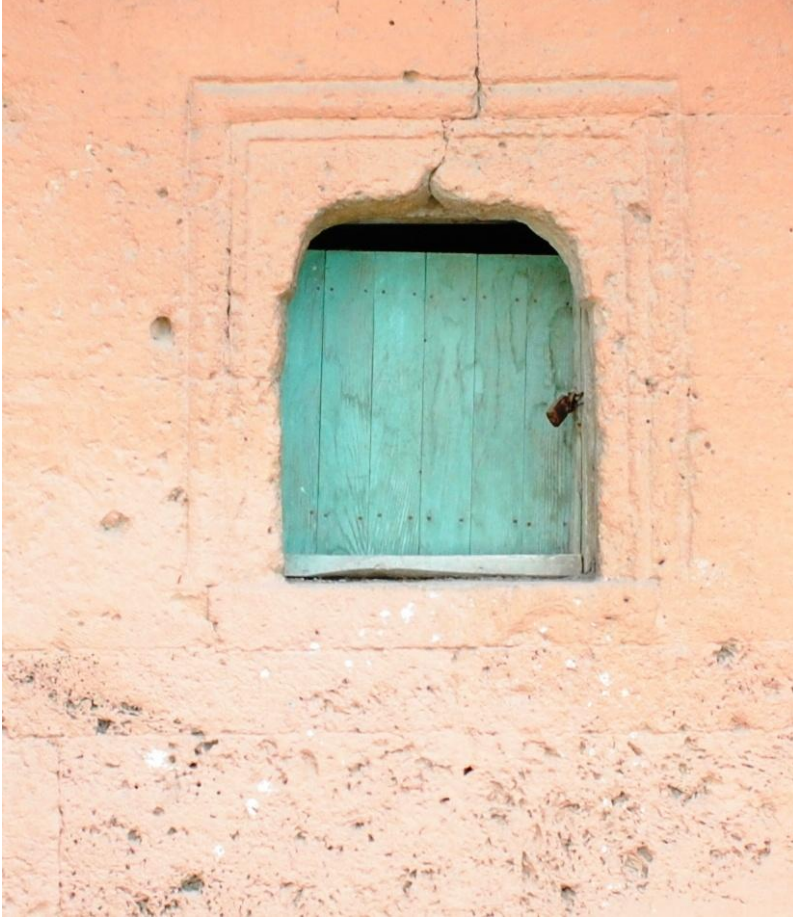
Fot.32: Hecin Dede Camii Çeşmesi Depo Bölümüne Açılan Açıklık
