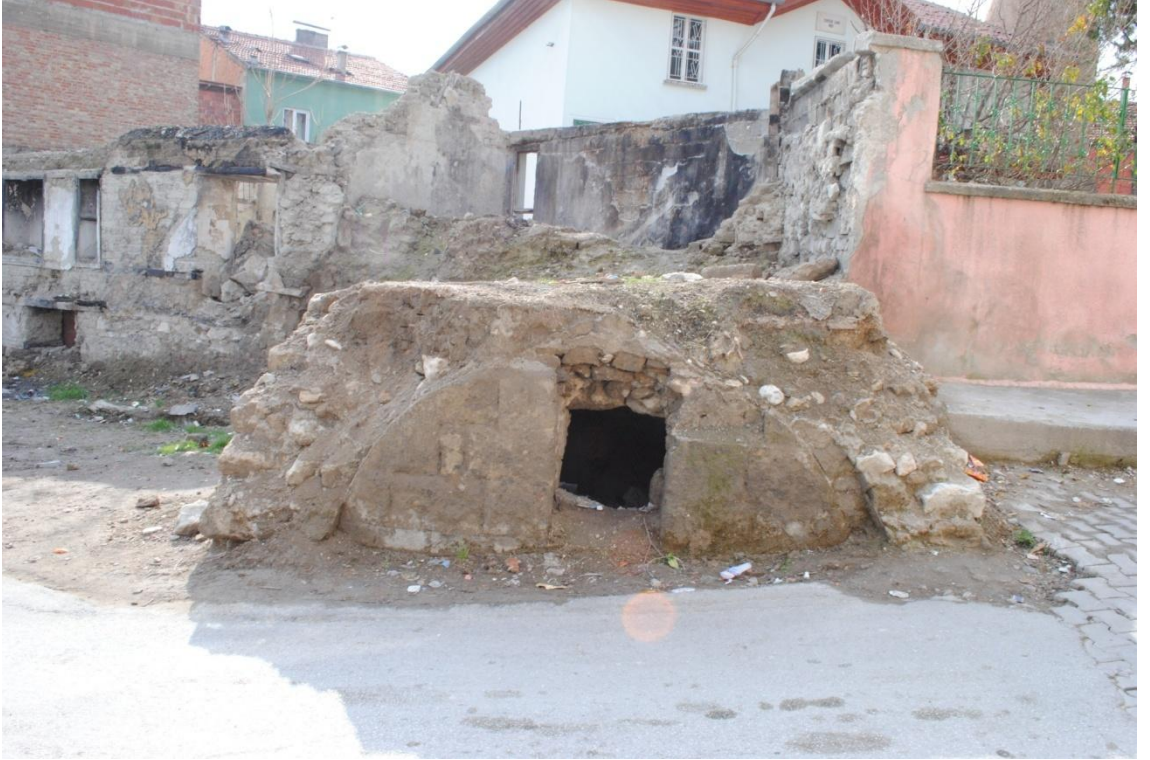
Fot.15: Eskiye Camii Çeşmesi
