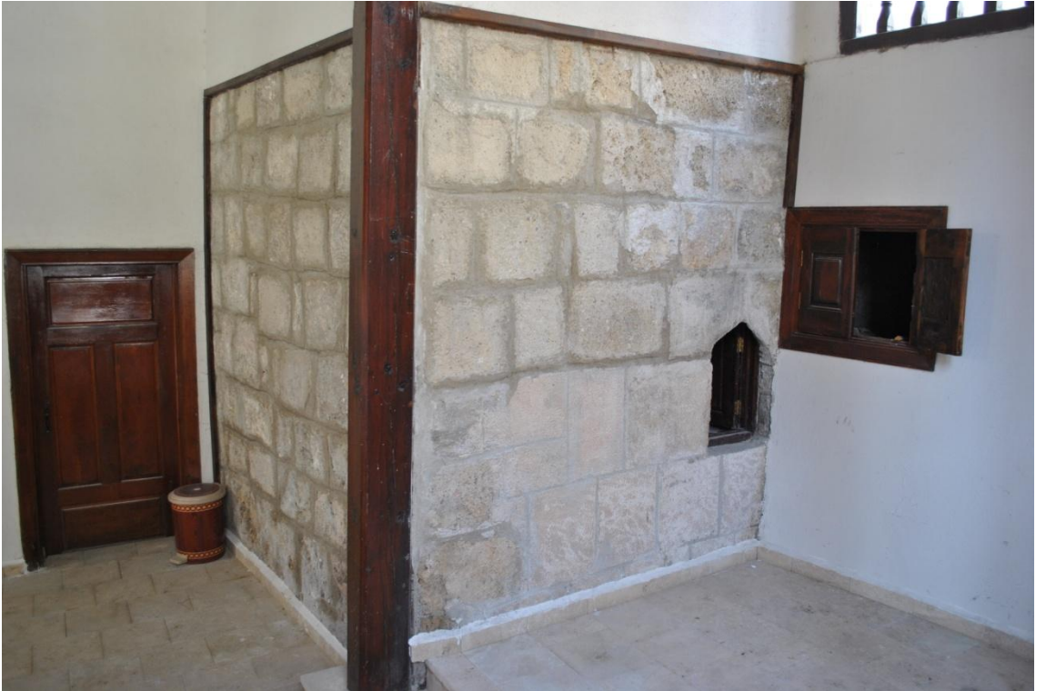
Fot. 51: Mısırlılar Evi Çeşmesi 2 Depo Bölümüne Geçiş Açıklığı
