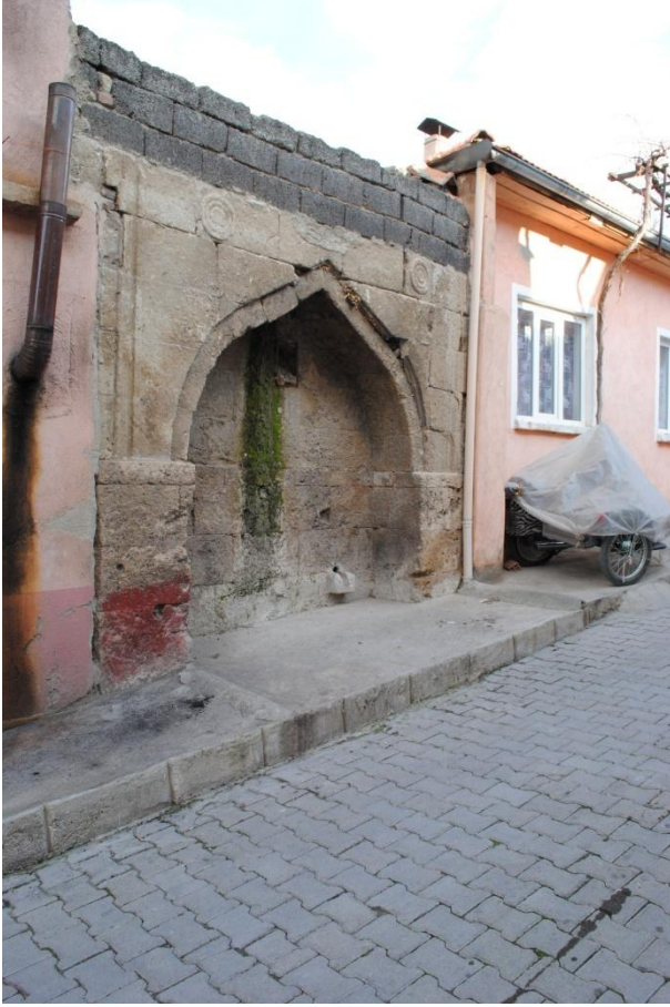
Fot.6: Akın Mahallesi Çeşmesi
