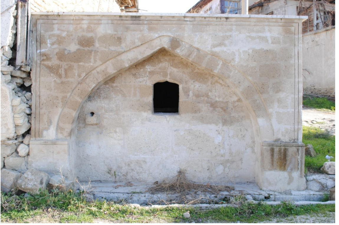
Fot.34: Hocannın Çeşmesi Güneybatı Cephesi
