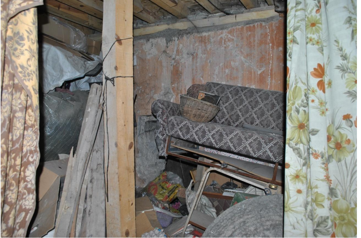
Fot. 23: Hacı Hüseyin Ağa Çeşmesi Depo Giriş Bölümü
