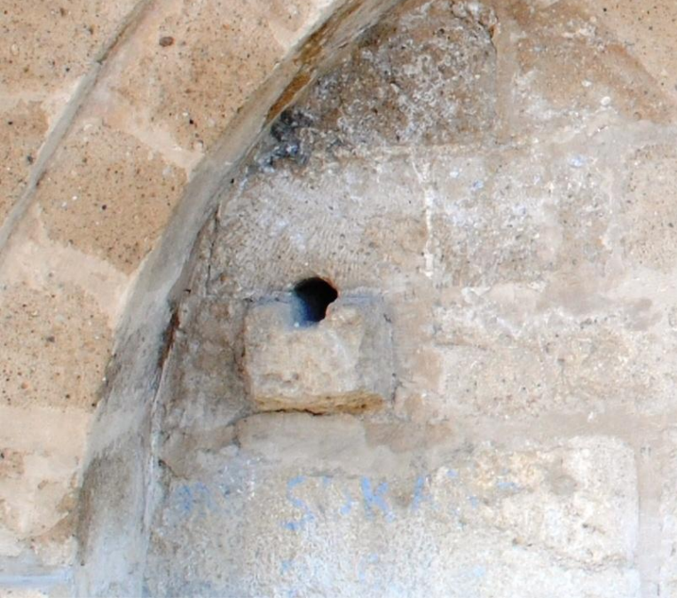
Fot.36: Hocanın eşmesi örtlen Şeklindeki Dolu Savağı
