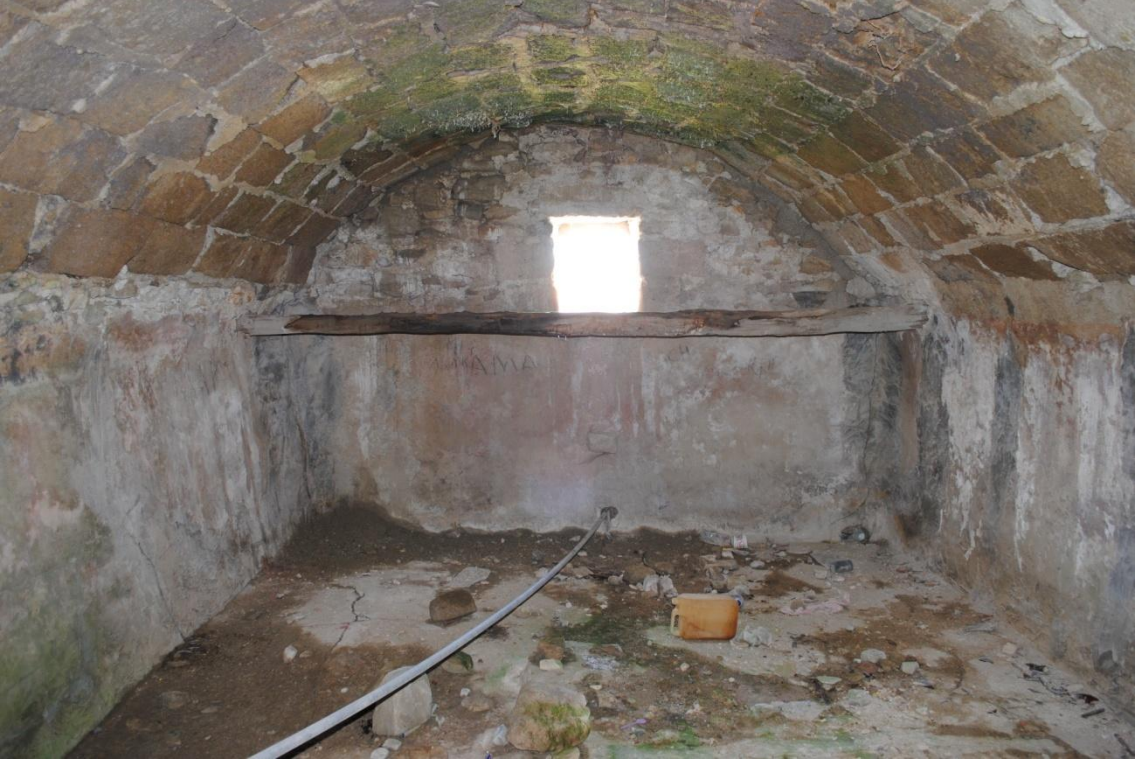
Fot.37: Hocanın eşmesi Depo Bölümündeki Ahşap Hatıl
