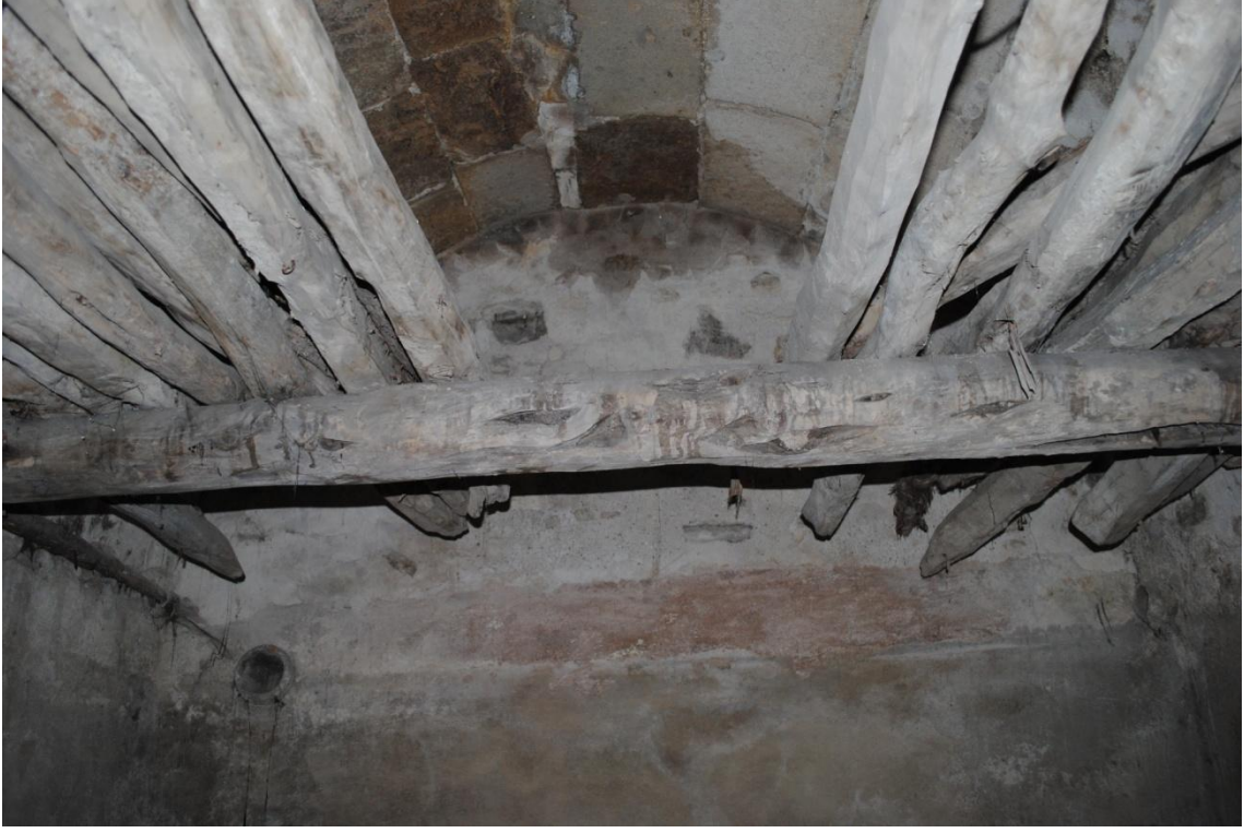
Fot. 60: Şehit Mükerrerem Sokağı Çeşmesi Depo Bölümü ve Ahşap Hatıl
