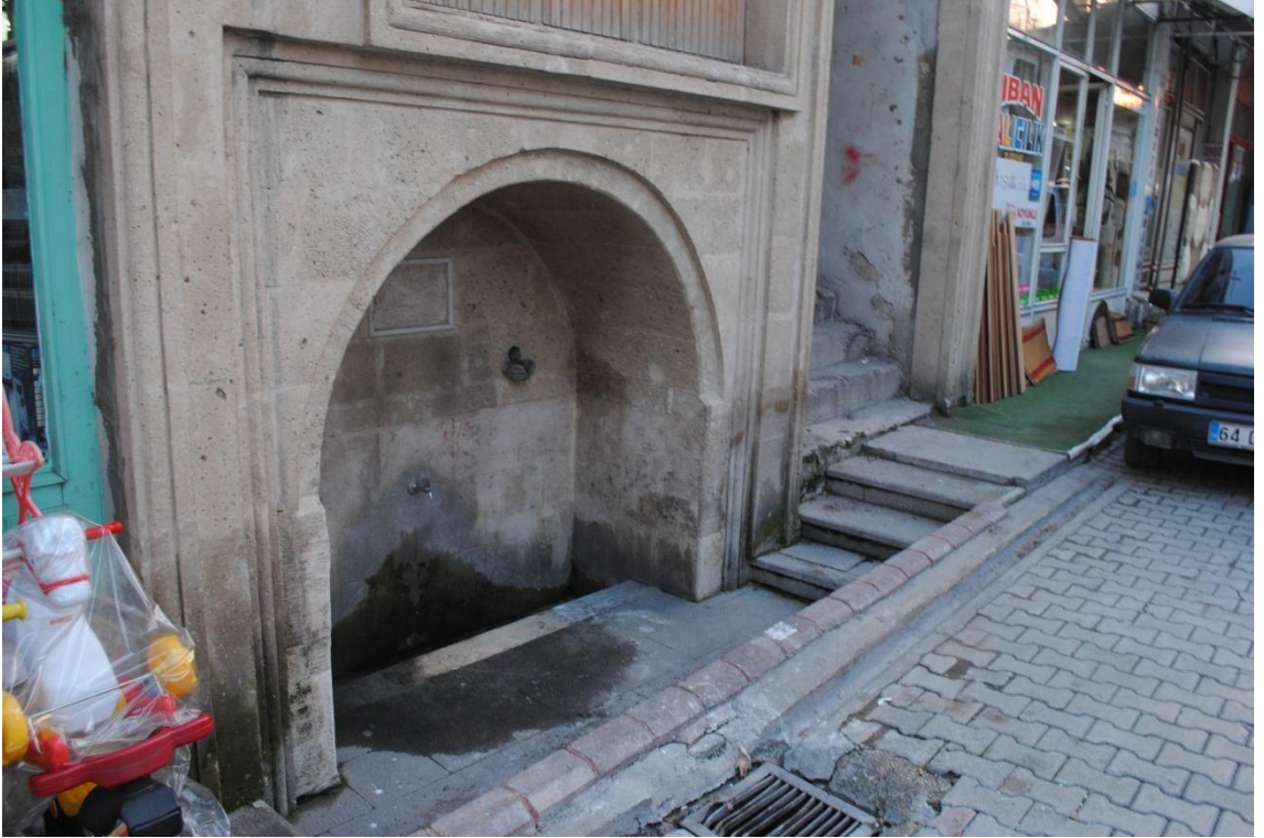
Fot.69: Zülal-i huş Çeşmesi Kot Seviyesi
