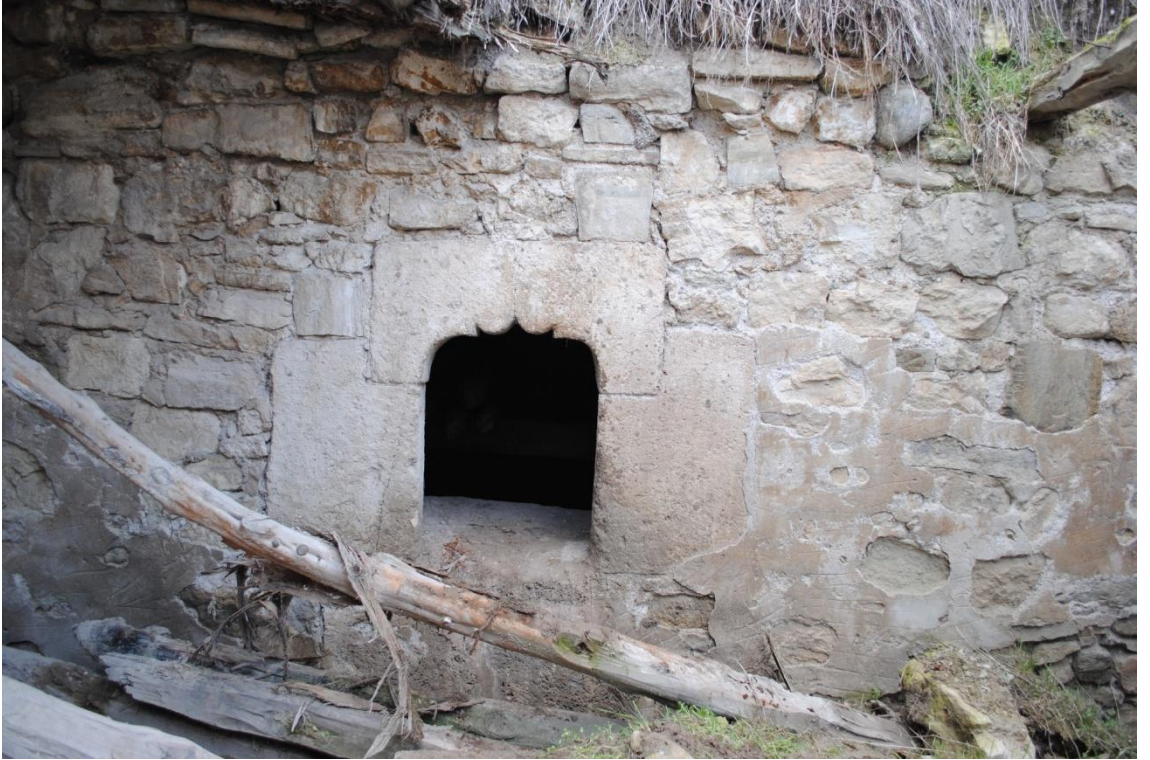
Fot. 59: Şehit Mükerrer Sokağı Çeşmesi Depo Bölümüne Geçiş Açıklığı
