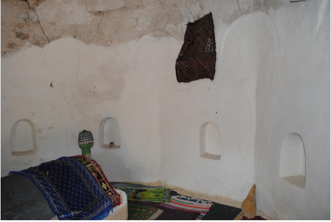
Resim 119: Yeşilova Onacak Veli Dede Türbesi, içten görünüş
