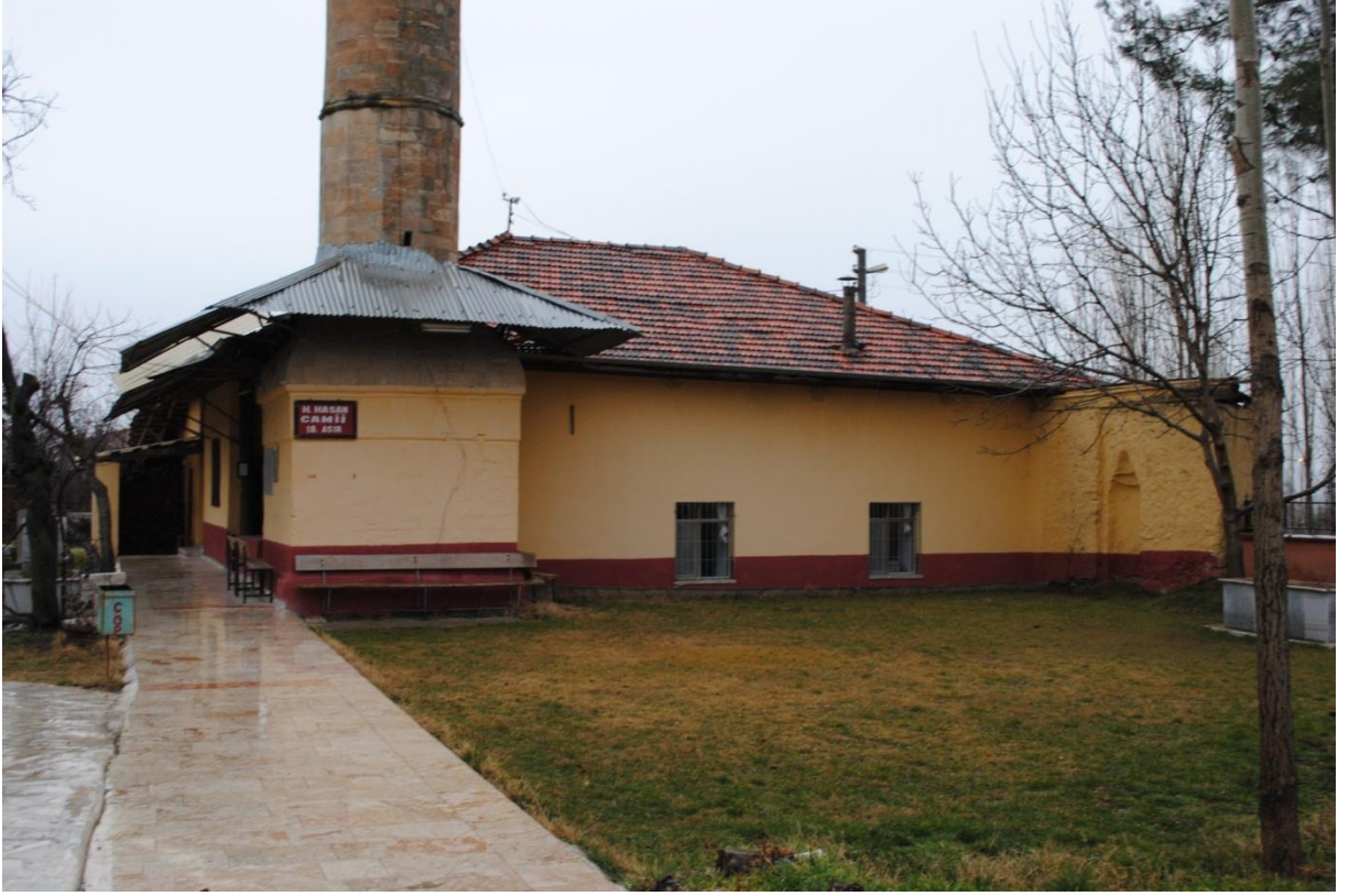
Resim 55: Gölhisar Hacı Hasan Camii, doğu cephe
