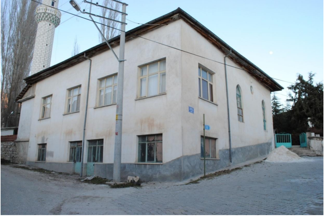
Resim1:Ağlasun Mülazımoğlu Camii, güney ve batı cephelerden genel görünüş
