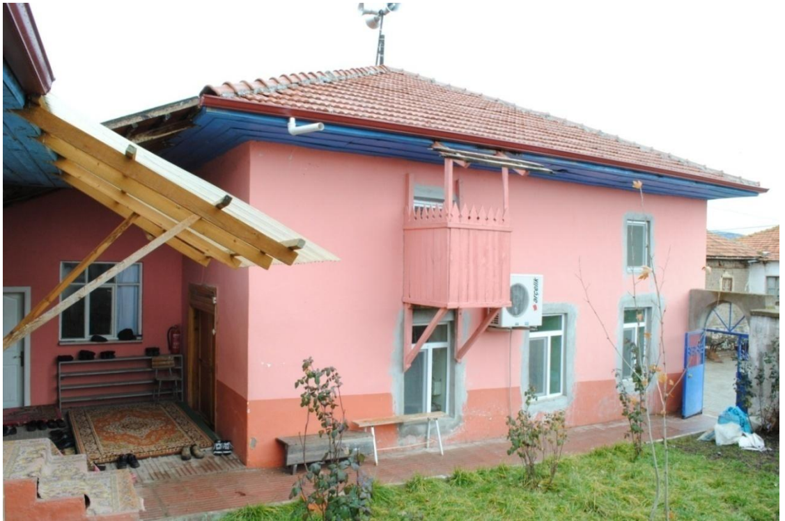
Resim 14: Çavdır Bayır Köyü Eski Cami, batı ve kuzey cepheden genel görünüş
