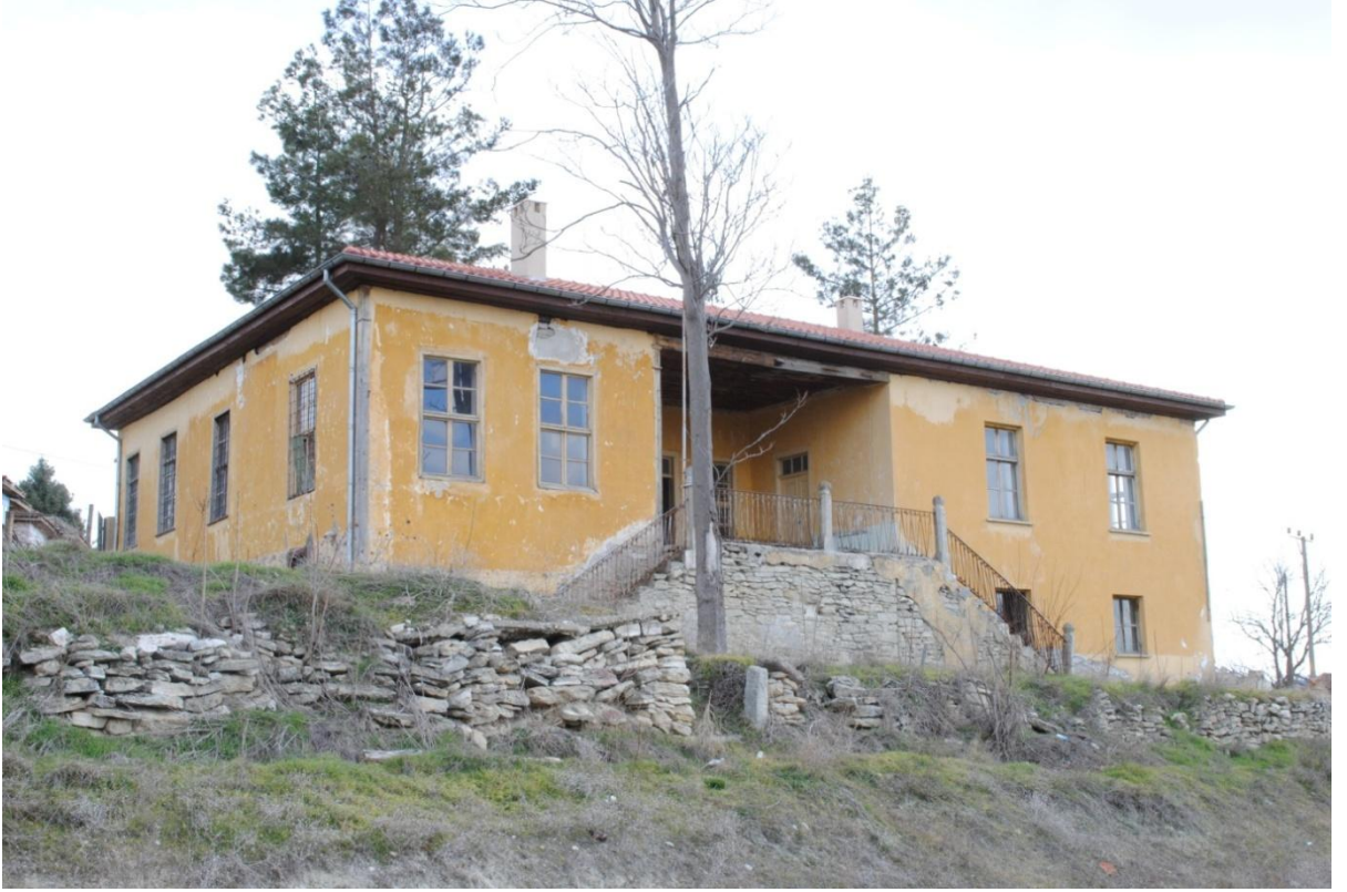
Resim 187: Kemer Elmacık Köyü İlkokulu, genel görünüş
