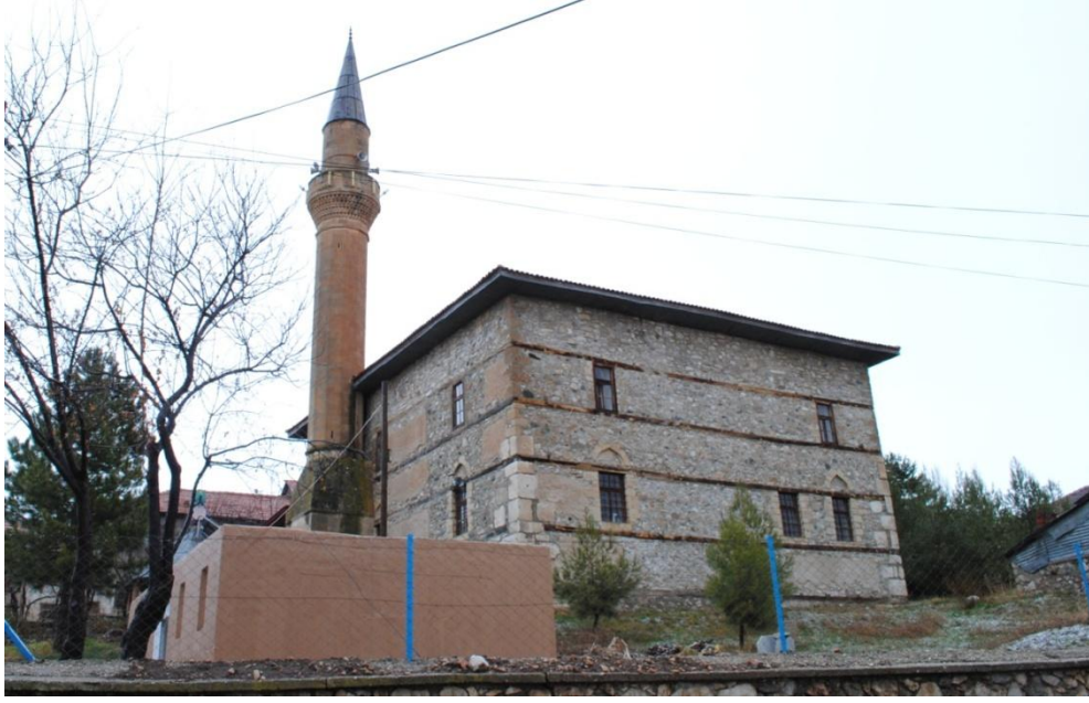
Resim 19: Çavdır Dengere Eski Cami, kuzey ve batı cephelerden görünüş
