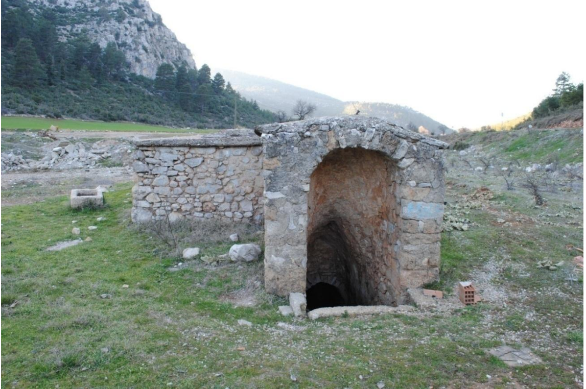
Resim 165: Bucak Kuyucak Sarnıcı, giriş kısmından görünüş
