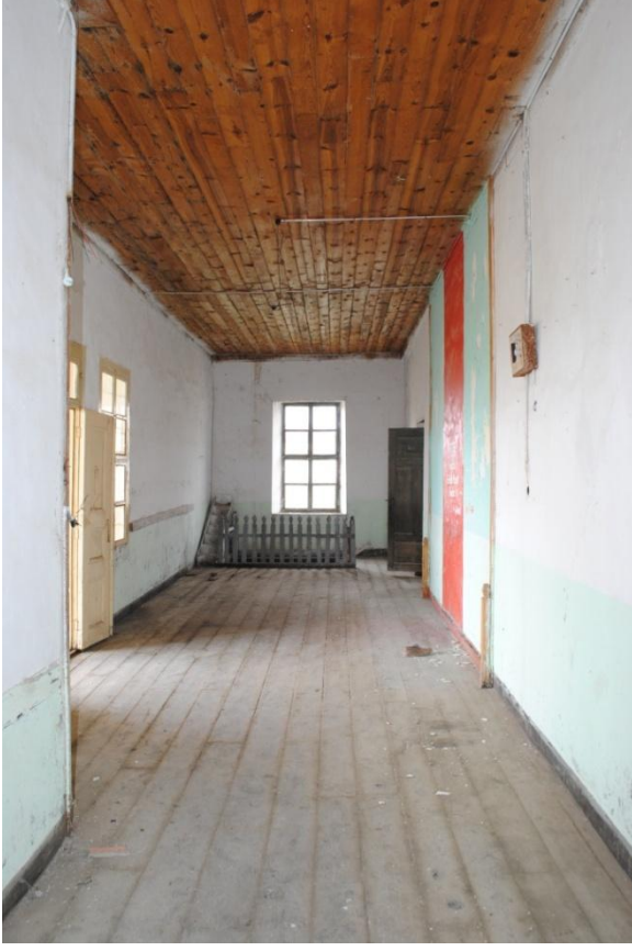
Resim 191: Kemer Elmacık Köyü İlkokulu, koridordan görünüş
