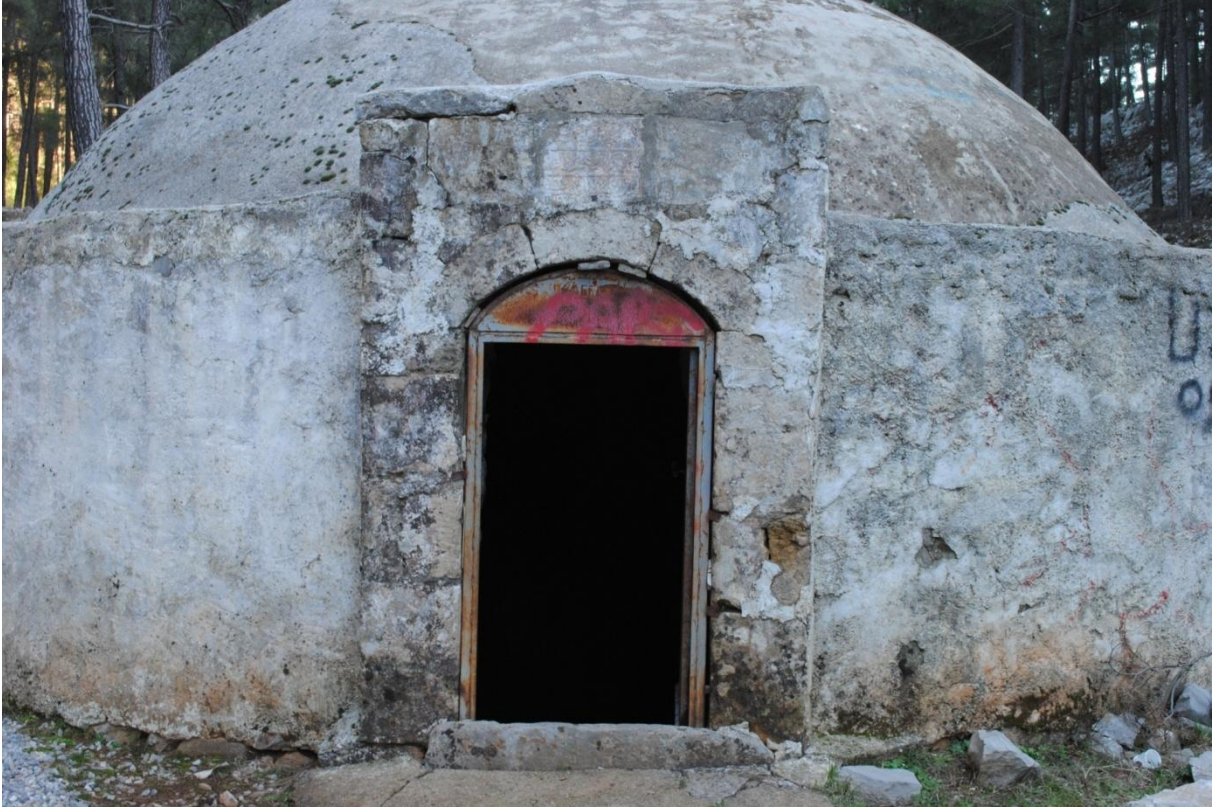
Resim 174: Bucak Top Sarnıç, giriş kapısından görünüş
