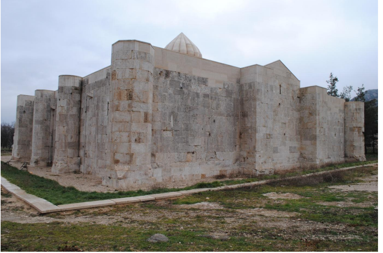
Resim 136: Bucak Susuz Han, güney ve doğu cephelerden görünüş
