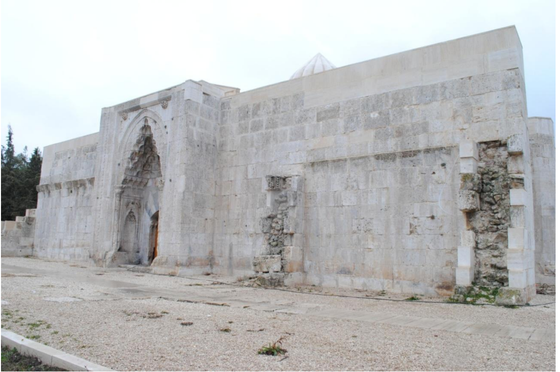
Resim 135: Bucak Susuz Han, batı duvardaki avluya ait duvar kalıntıları
