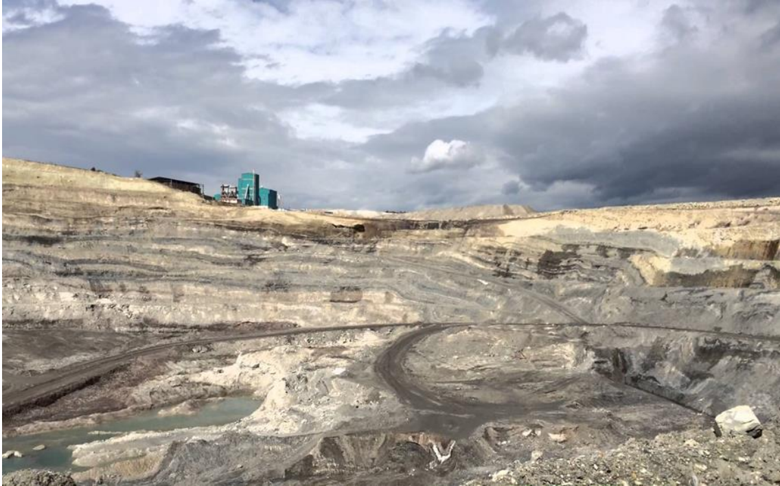
Şekil 3.2 Açık ocak sahasının genel görünümü.
