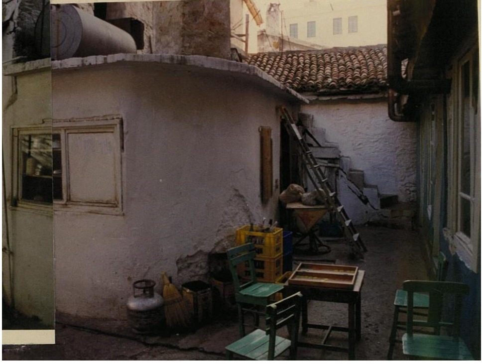
Foto. 152: Yarım Han Güney Kanadının Önceki Durumu (Muğla Belediyesi Arşivi)
