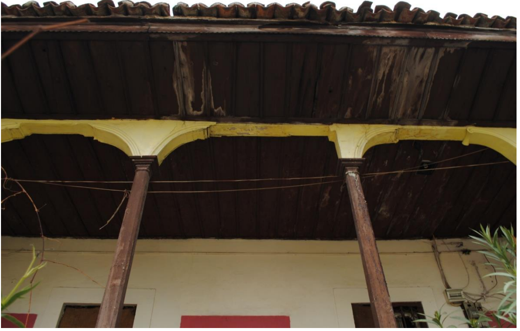
Foto. 47: Bıcalar (Kıraathane) Hanında Bağdadi Teknikle Yapılan Kemerler
