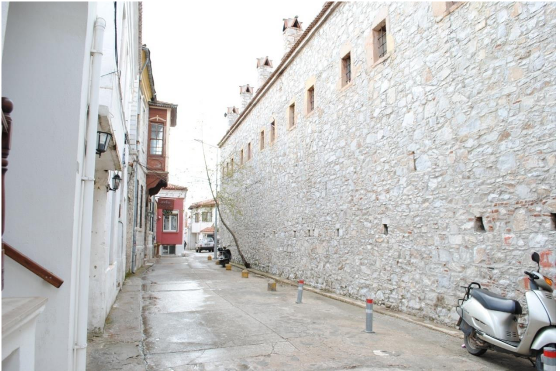
Foto. 131: Yağcılar Hanı Güney Cephe Dış Görünüşü
