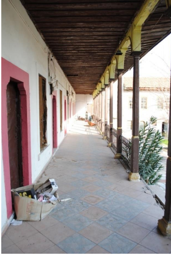
Foto. 49: Bıcılar (Kıraathane) Hanı Revağının Taban ve Tavan Döşemeleri
