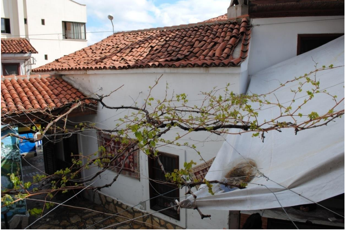
Foto. 145: Yarımcı Han Avlu Geçidinin Güneydoğusundaki Mekânın Görünüşü
