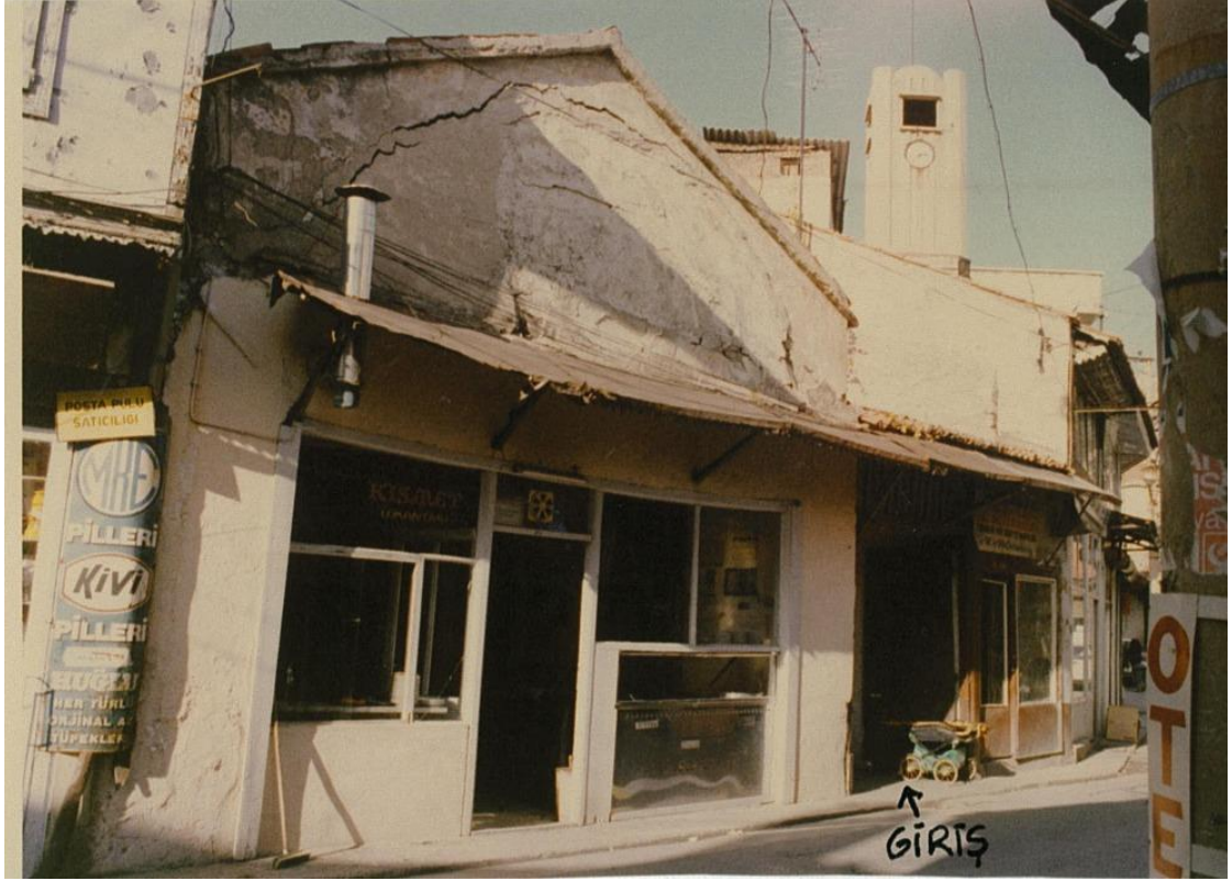
Foto. 146: Yarımcı Han'ın Güneydoğu Cephesindeki Mekânların Görünüşü (Muğla Belediyesi Arşivi)
