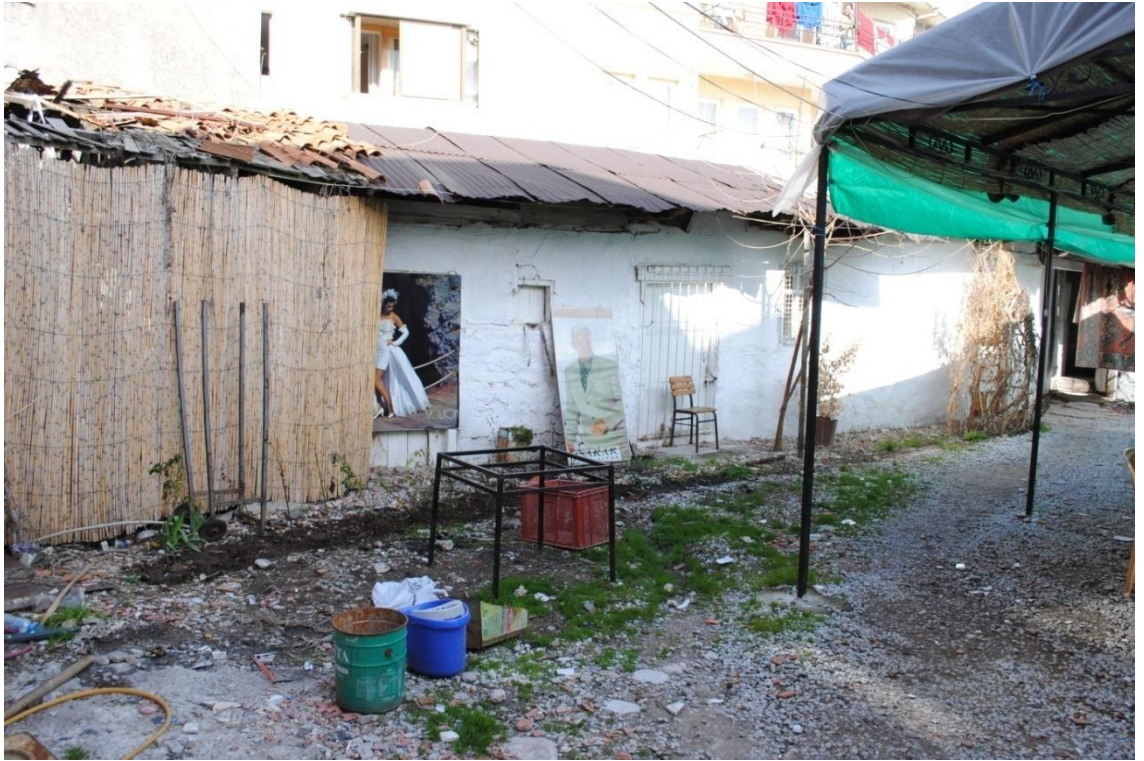
Foto. 12: Balcioğlu Hanı Doğu Kanattaki Mekânların Avluya Bakan Cephesi
