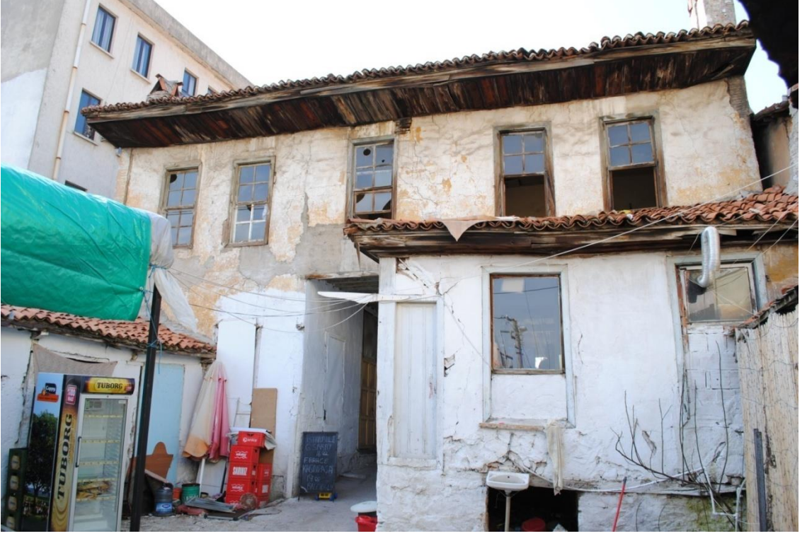
Foto. 35: Balcioğlu Hanı Üst Kat Güney Cephesi Görünüşü
