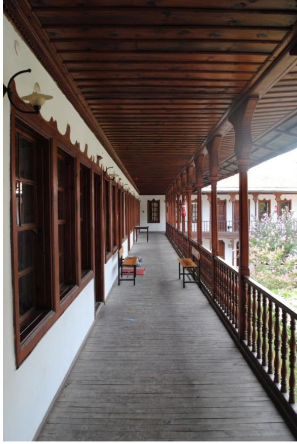
Foto. 85: Konakaltı (Hacılar) Hanı Üst Kat Revak Taban ve Tavan Döşemeleri
