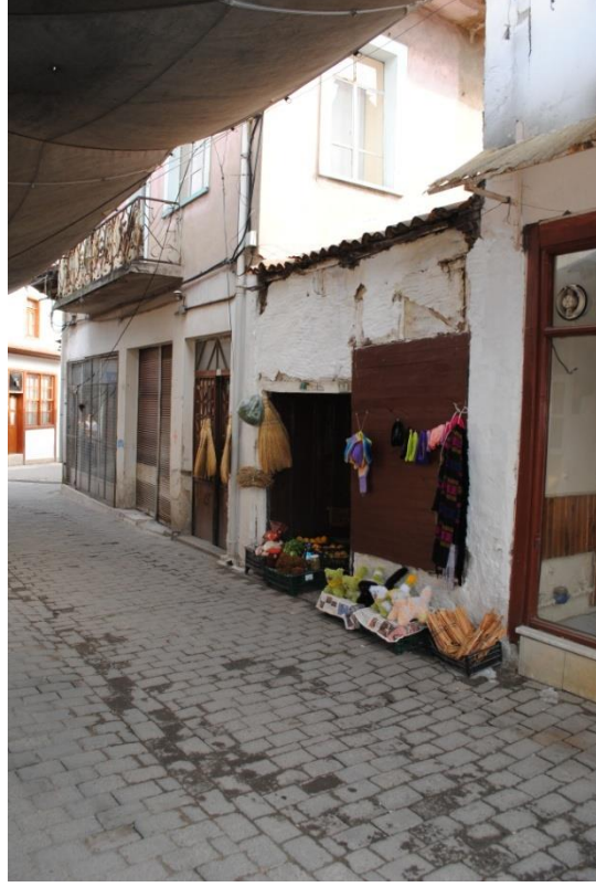
Foto. 87: K m rc  (K m r uvalı)Hanı Kuzey Cephesi
