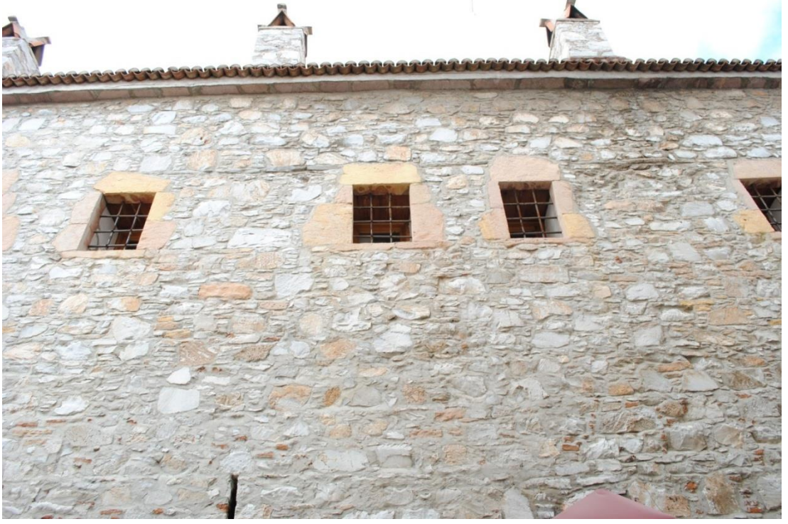
Foto. 132: Yağcılar Hanı Güney Cephesi Üst Kat Pencereleri
