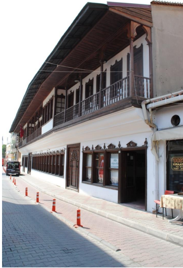
Foto. 80: Konakaltı (Hacılar) Hanı Güney Cephesi ve Güneydoğu Kapısı
