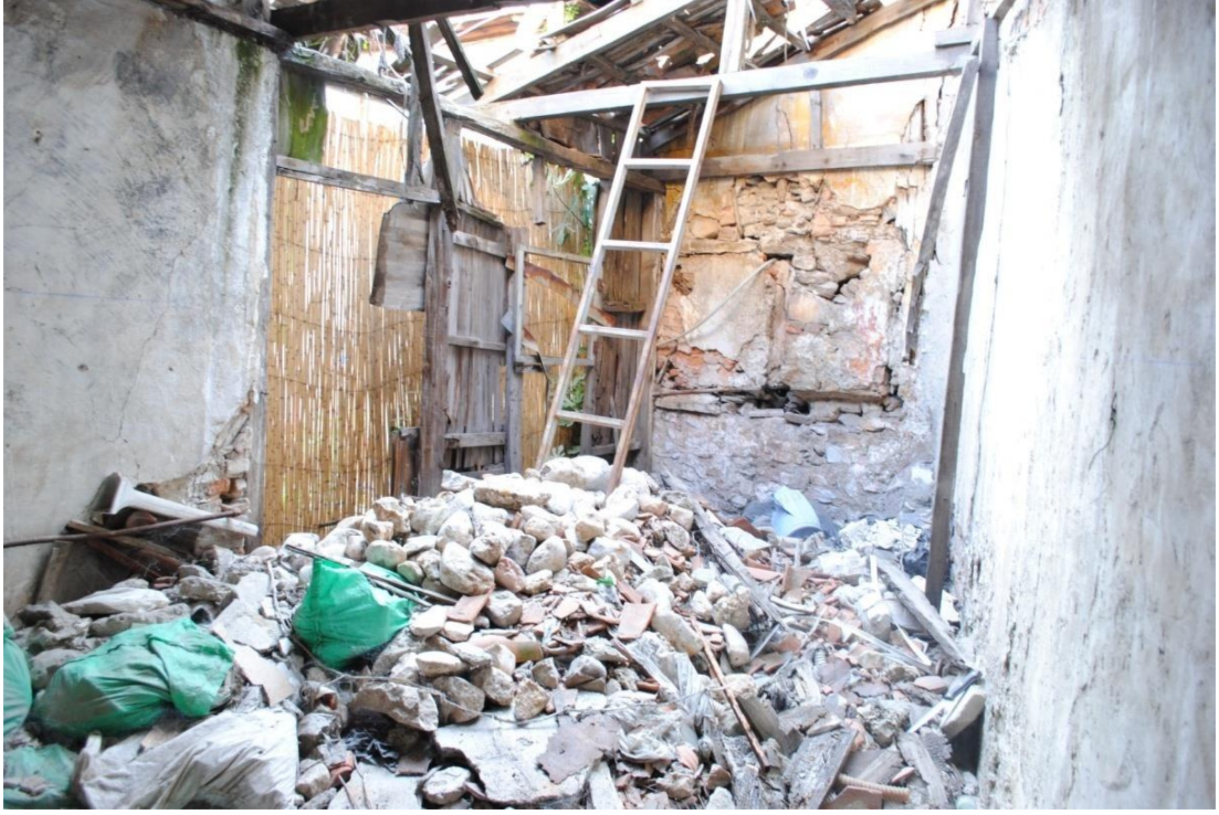
Foto. 25: Balcıođlu Hanı Avlusunun Kuzeydođu Kõşesindeki Mekânın İç Görünüşü
