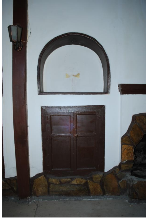
Foto. 52: Bıcılar (Kıraathane) Hanı Kapaklı Dolap ve Yuvarlak Kemerli Nişlerden Görünüş
