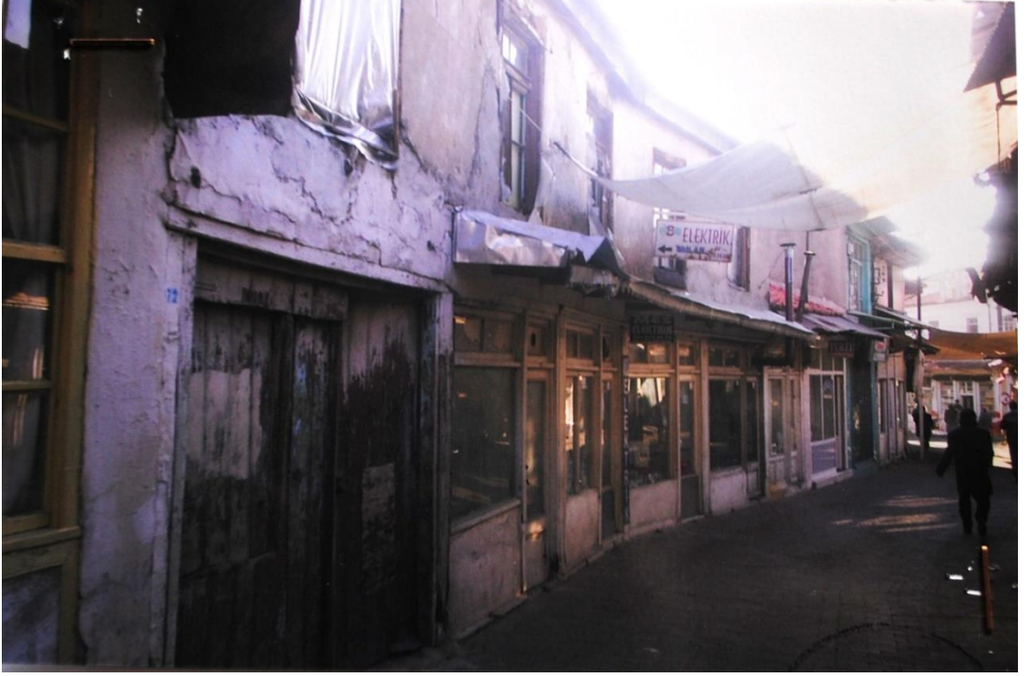
Foto. 59: Halil İbrahim Hanı Güney Cephesindeki Mekânların Dıştan Görünüşü (Muğla Belediyesi Arşivi)
