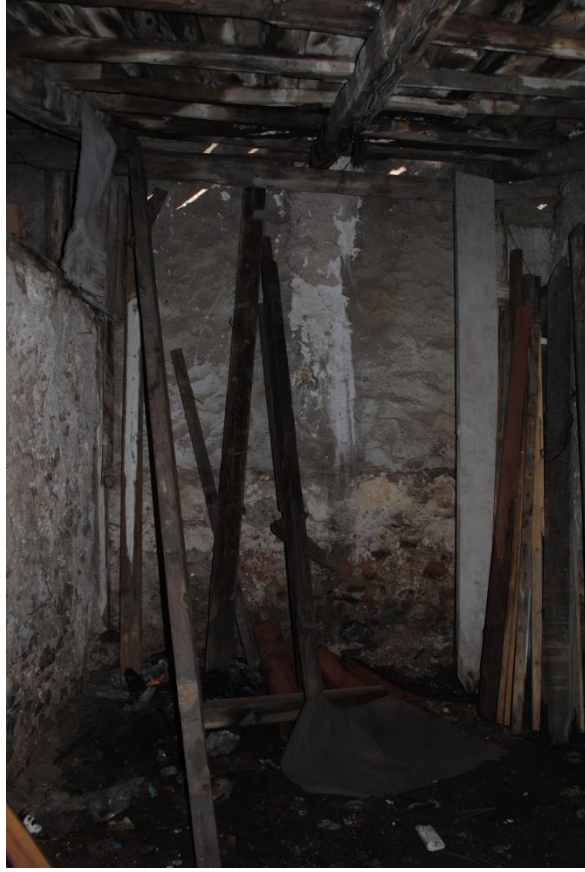
Foto. 27: Balçiođlu Hanı Eyvan Şeklindeki Mekândan İç Görünüş
