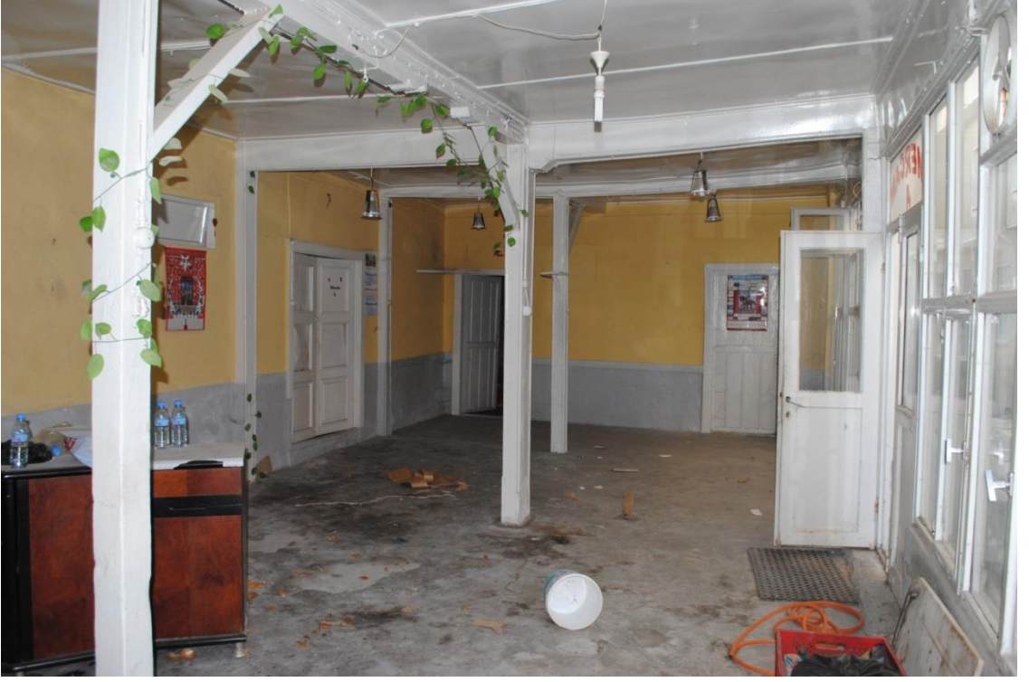
Foto. 95: Mercan Han Alt Kat Dođu Cephesinde Bulunan Mekânın İçi
