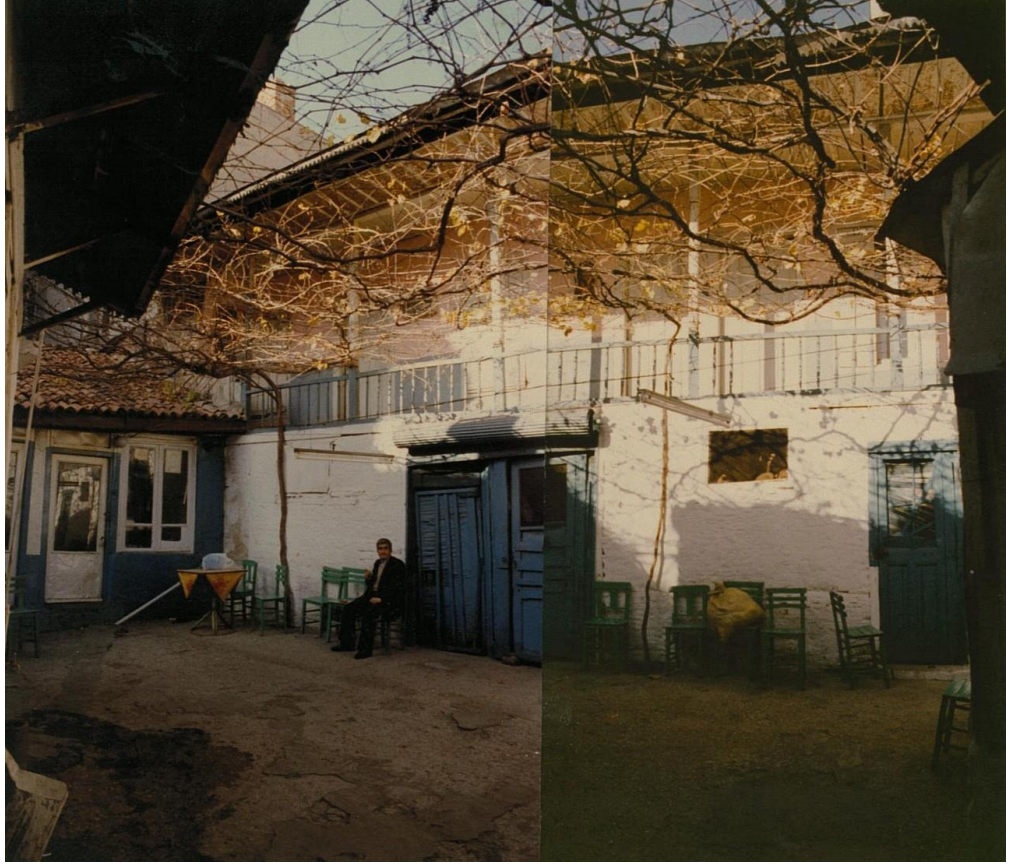
Foto. 150: Yarımlı Han'ın Kuzey Kanat İki Katlı Kısım (Muğla Belediyesi Arşivi)
