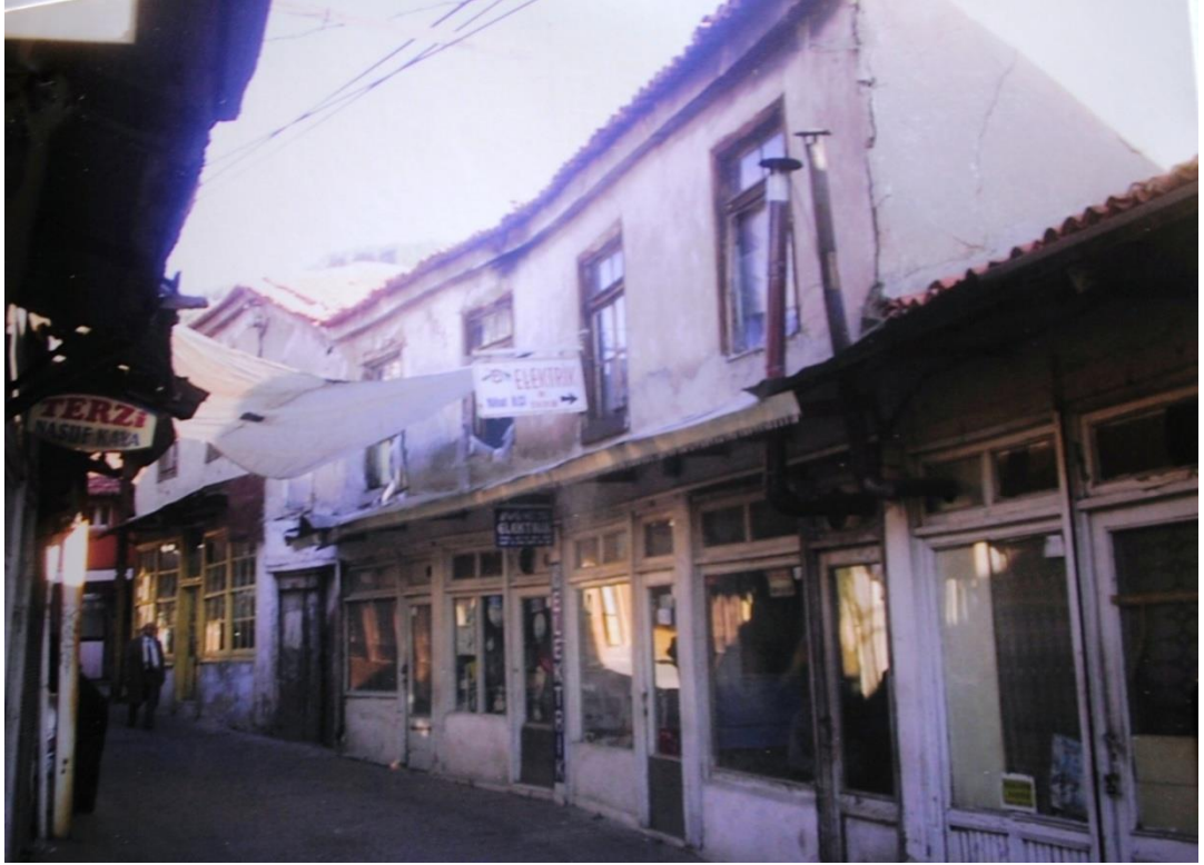
Foto. 55: Halil İbrahim Hanı Güney Cephesi Genel Görünüşü (Muğla Belediyesi Arşivi)
