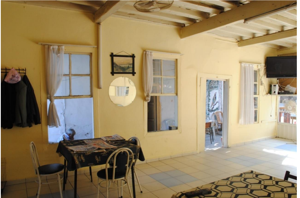
Foto. 20: Balcıođlu Hanı Avlu Geçidinin Doğusundaki Mekânın Kapı ve Pencereleri
