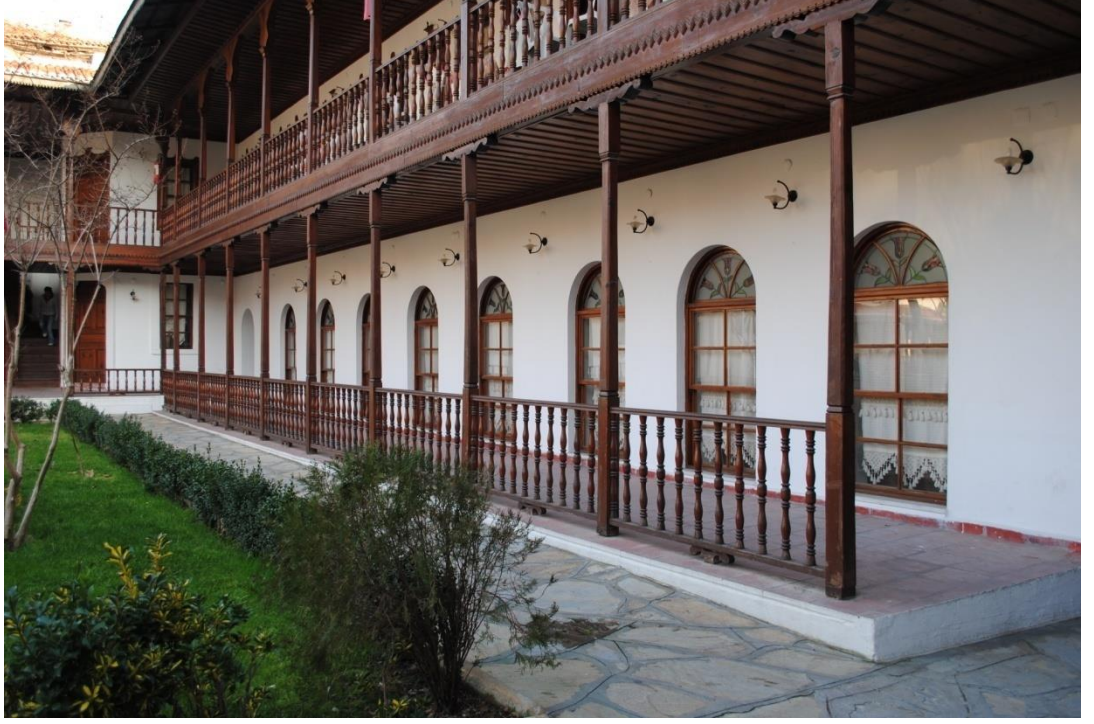
Foto. 77: Konakaltı (Hacılar) Hanı Güney Kanadının Avluya Bakan Cephesinde Alt Kat Görünüşü
