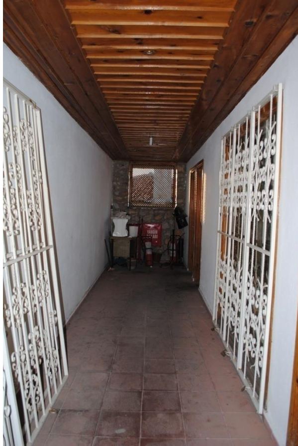
Foto. 127: Yağcılar Hanı Kuzey Kanadı Üst Kat Koridor Kısmı
