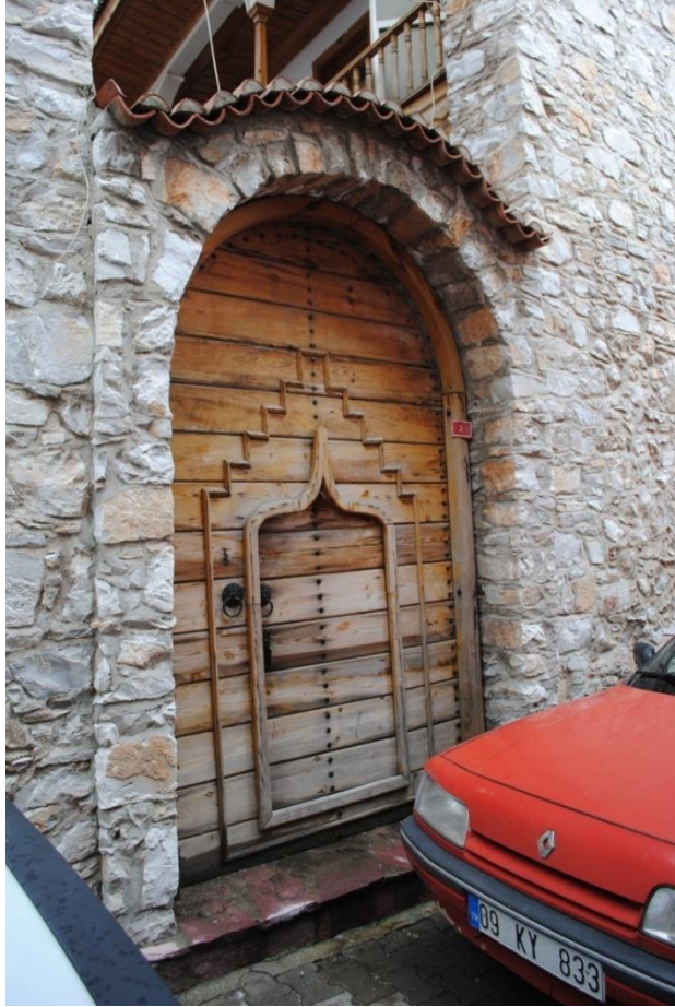
Foto. 111: Yağcılar Hanı Güneybatı Kapısı
