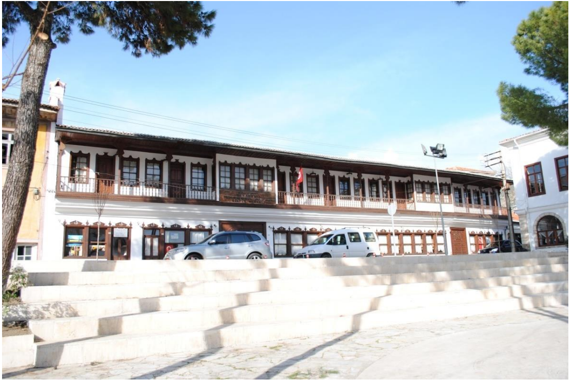
Foto. 66: Konakaltı (Hacılar) Hanı'nın Güney Kanadının Caddeye Bakan Cephesi
