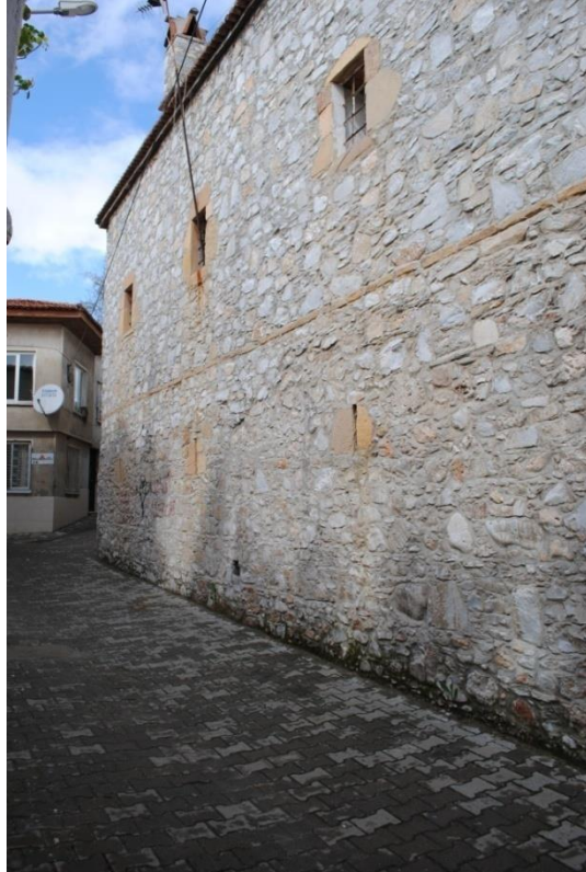
Foto. 133: Yağcılar Hanı Batı Cephesi
