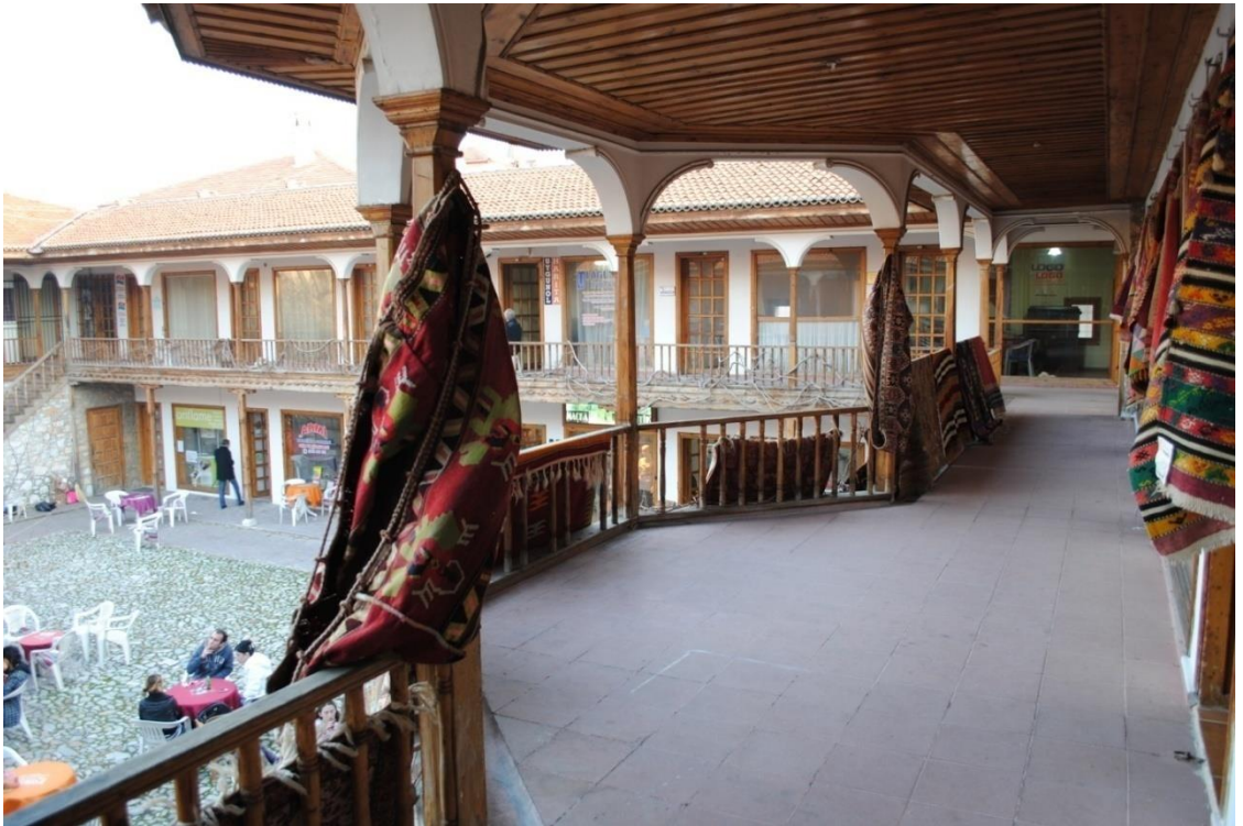
Foto. 123: Yağcılar Hanı Batı Revak Kısımındaki Balkon Taşıntısı, İçten Görünüşü
