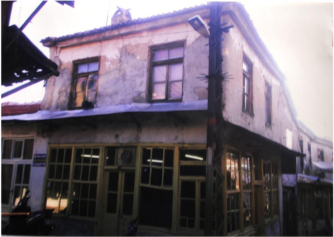
Foto. 56: Halil İbrahim Hanı Batı Köşesindeki Mekânın Dış Görünüşü (Muğla Belediyesi Arşivi)
