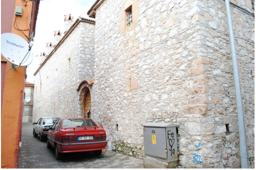
Foto. 110: Yağcılar Hanı Güney ve Batı Kanatları Arasındaki Güneybatı Girişi
