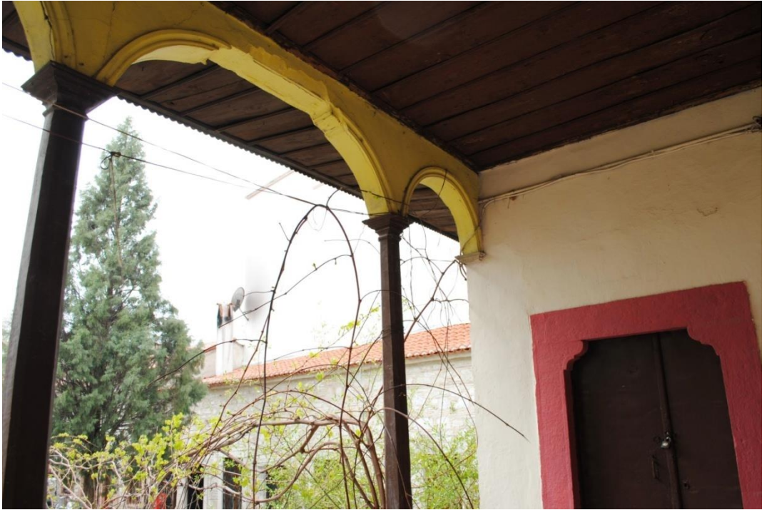
Foto. 48: Bıcalar (Kıraathane) Hanı Revaktaki Yuvarlak ve Bursa Kemerleri Tarzındaki Kemerlerden Görünüş
