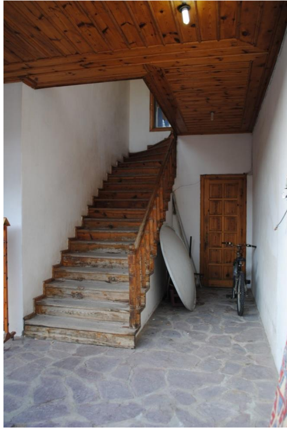
Foto. 139: Yağcılar Hanı Kuzeydoğu Köşedeki Merdiveni
