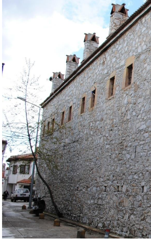
Foto. 142: Yağcılar Hamı Güney Cephesinin Yukarısındaki Bacalar
