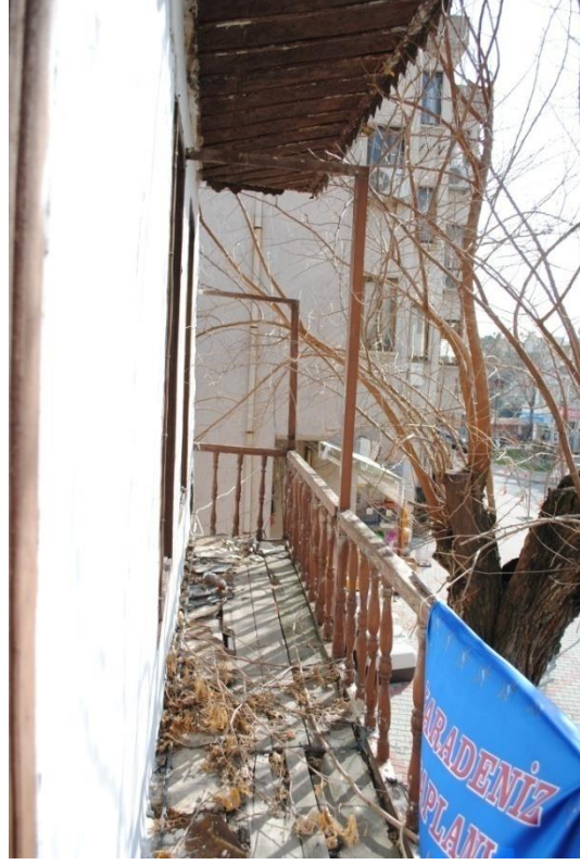
Foto. 17: Balçiođlu Hanı Kuzey Cephe de Yer Alan Balkon Kısmı
