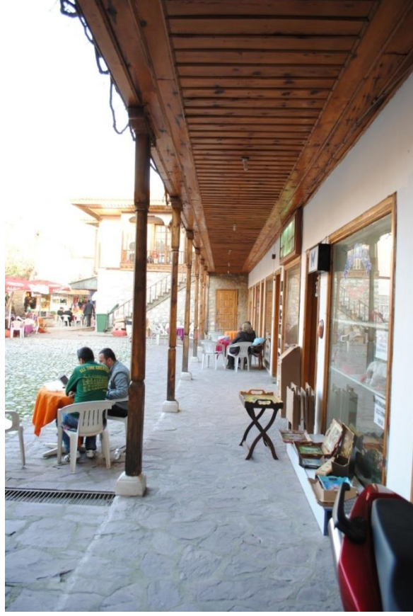
Foto. 114: Yağcılar Hanı Güney Kanadı Alt Kat Mekânlarının Kapıları ve Pencerelerinin Açıldığı Revak Kısım
