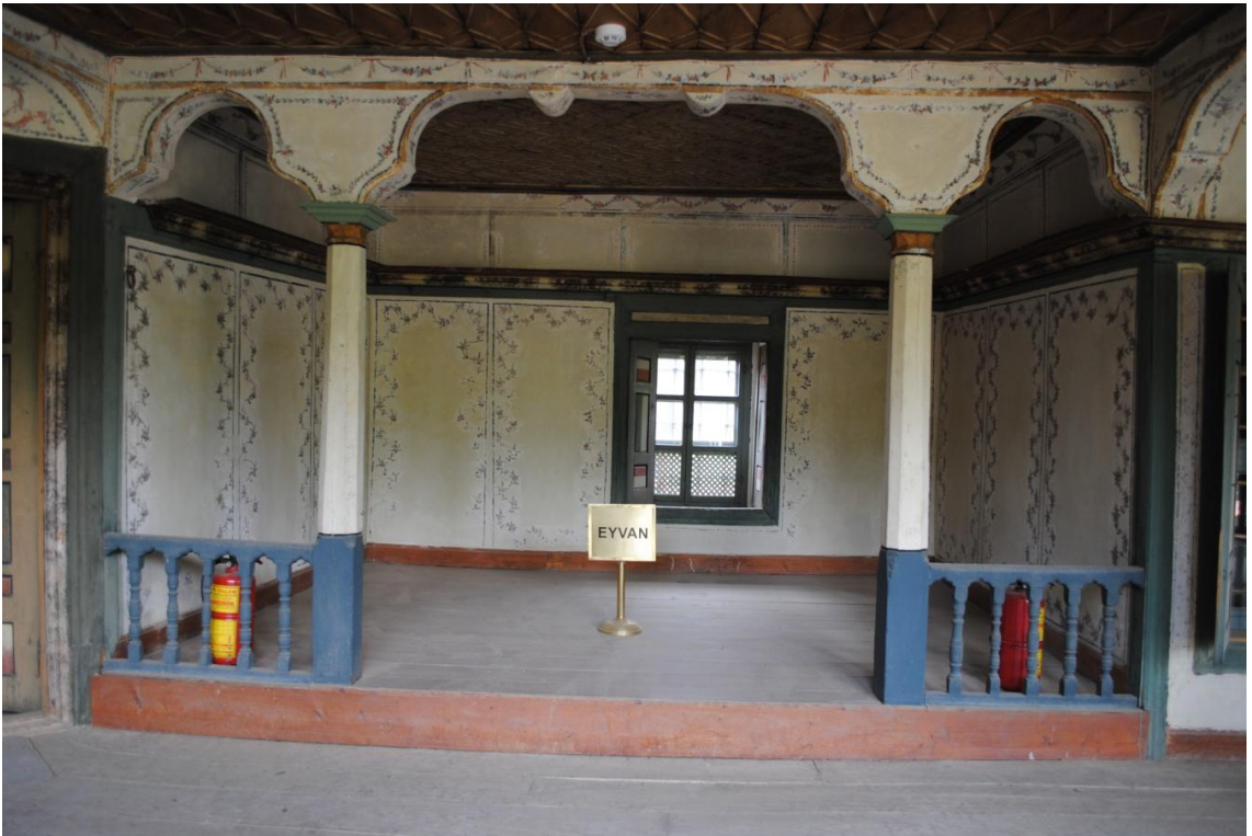
Fot.104: Çakırağa Konağı Birinci Kat Batı Yönündeki Eyvan
