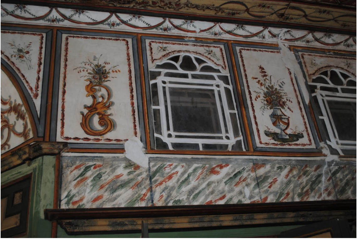
Fot.113: Çakırağa Konağı İkinci Kat Güney Eyvanı Duvarındaki Süslemeler
