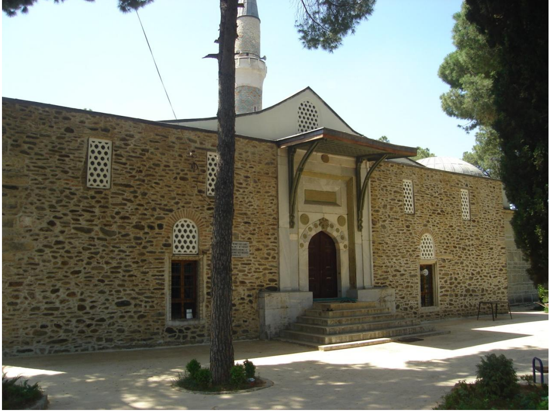
Fot.5: Birgi Ulu Camii Kuzey Cephesi
