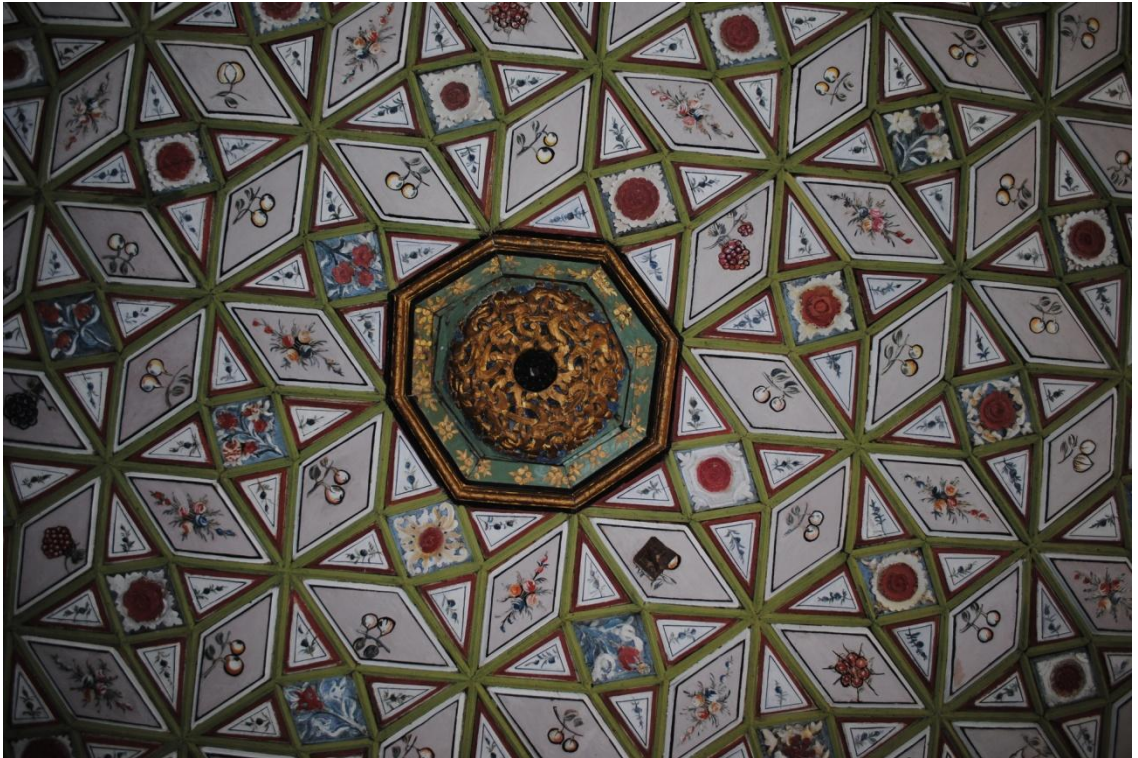
Fot.120: Çakırağa Konağı İstanbul Odasının Tavanı
