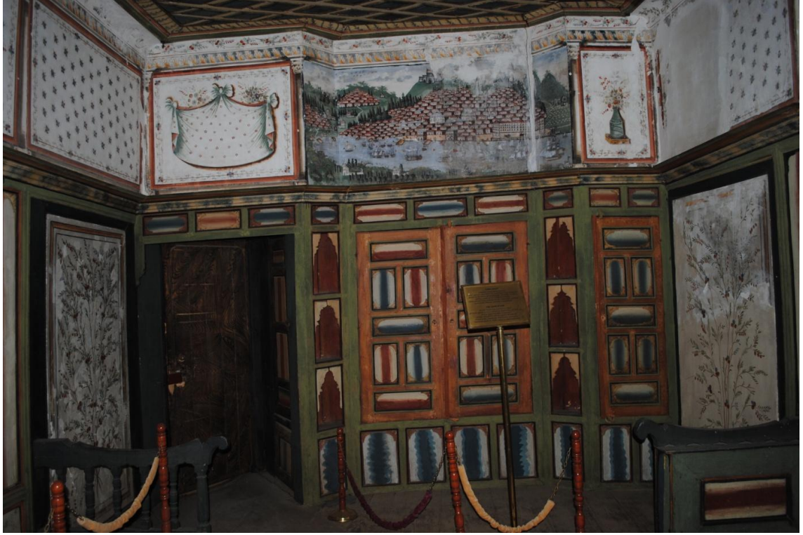
Fot.129: Çakırağa Konağı İzmir Odasının Güney Cephesi
