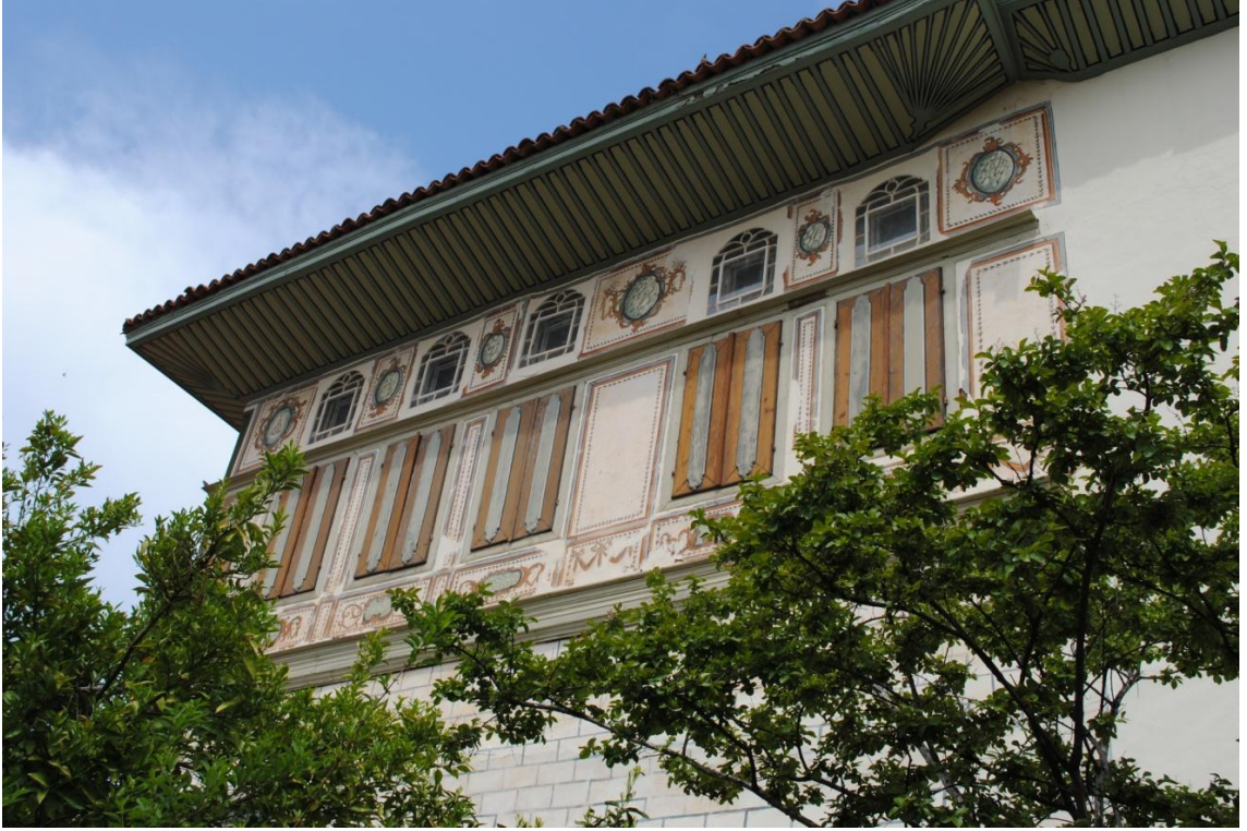
Fot.87: Çakırağa Konağı Güney Cephesi
