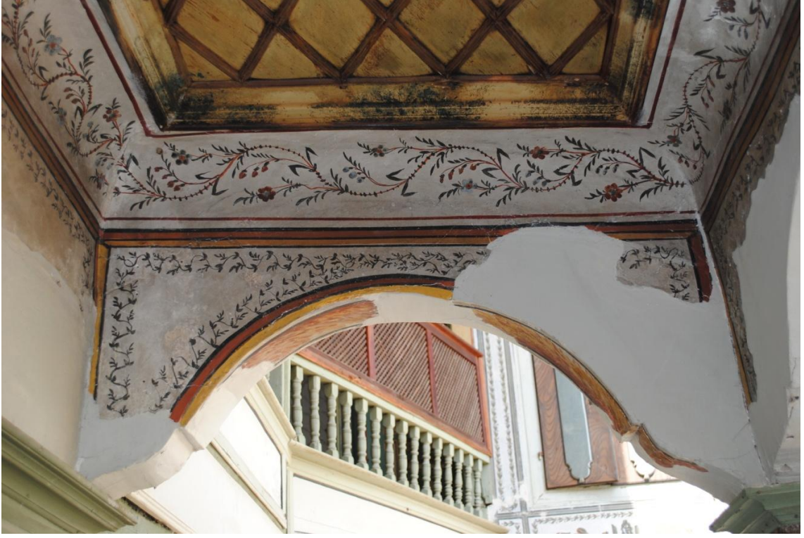
Fot.105: Çakırağa Konağı Birinci Kat Köşk
