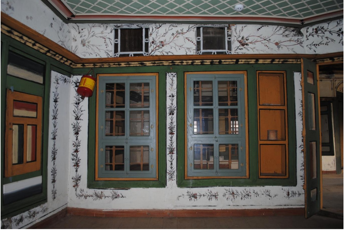
Fot.99: Çakırağa Konağı Birinci Kat Kışlık Misafir Odasının Kuzey Cephesi
