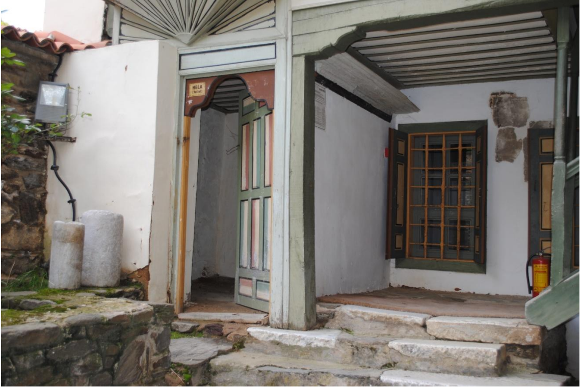
Fot.97: Çakırağa Konağı Zemin Katındaki Tuvalet
