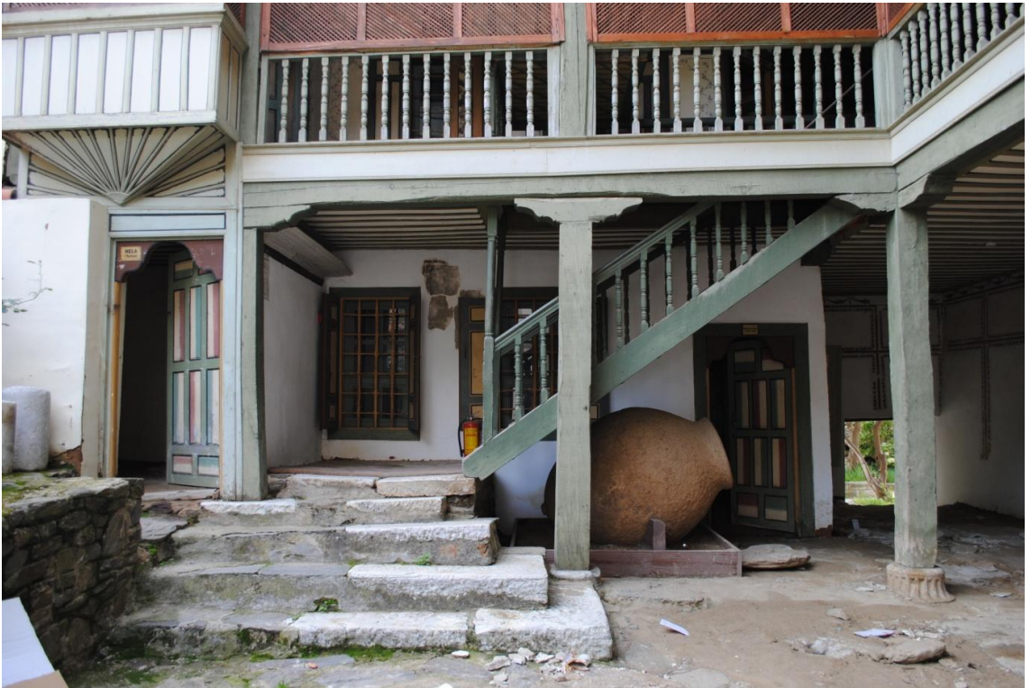
Fot.172: akıraęa Konaęı Taşıyıcı Stunlar
