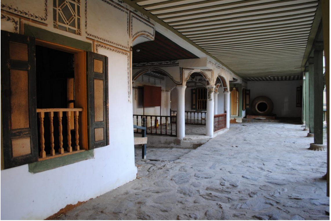
Fot.95: Çakırağa Konağı Zemin Katı
