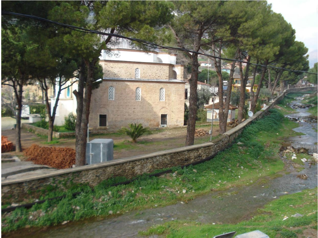
Fot.37: Derviş Ağa Camii Güney Cephesi
