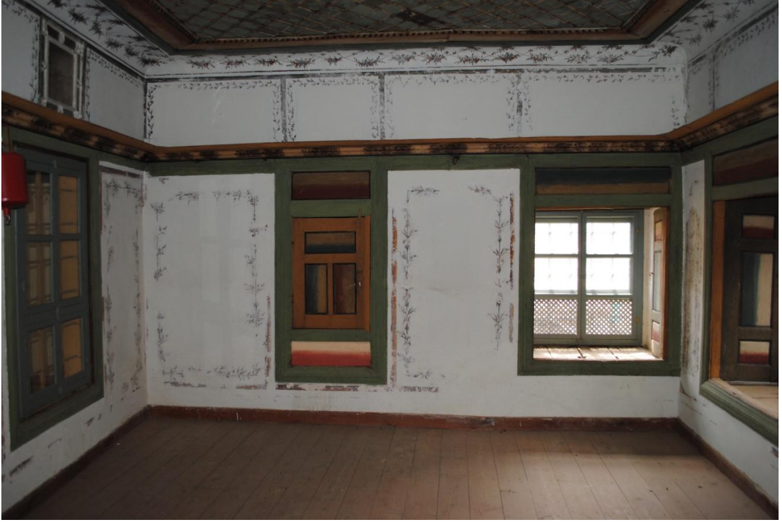
Fot.103: Çakırağa Konağı Birinci Kat Oturma Odası Batı Cephesi
