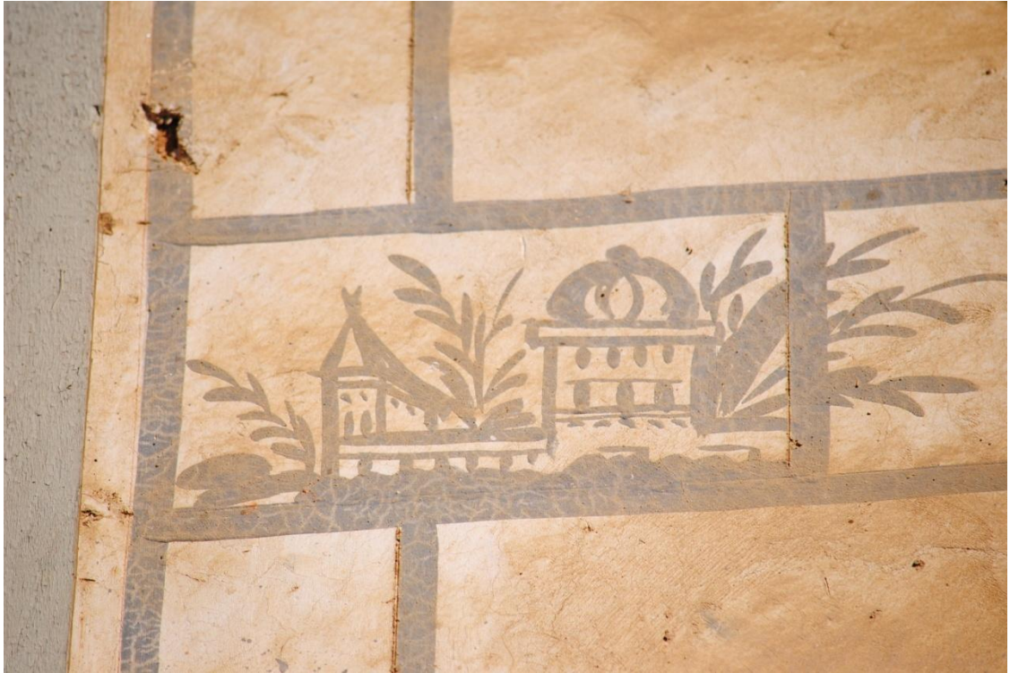
Fot.90: Çakırağa Konağı Batı Cephesinin Alt Duvarındaki Mimari Tasvir
