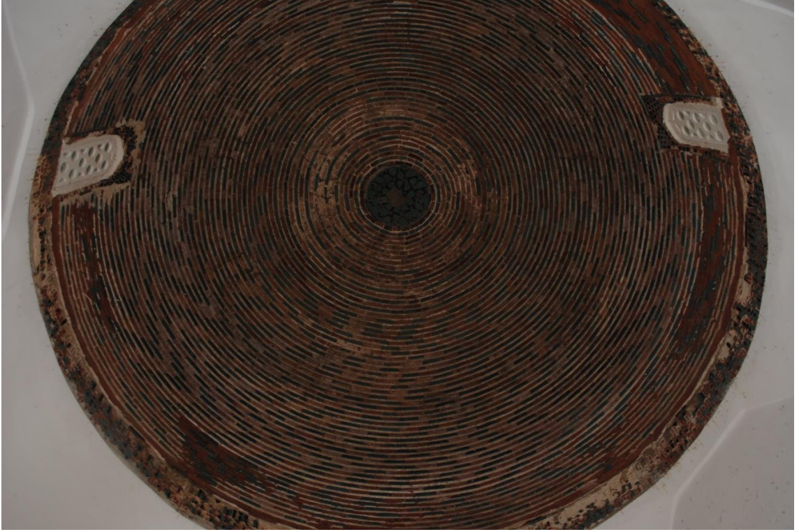
Fot.75: Aydınoğlu Mehmed Bey Türbesinin Kubbesi
