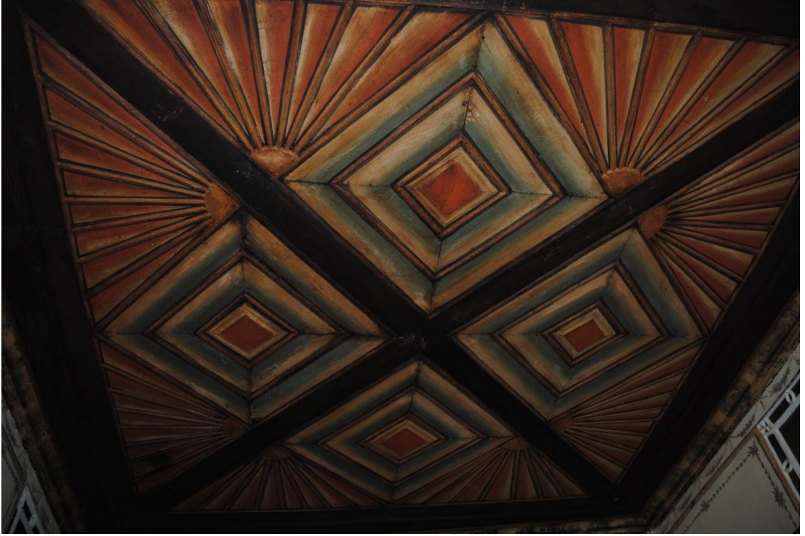
Fot.101: Çakırağa Konağı Birinci Kat Güney Eyvanı Tavanı
