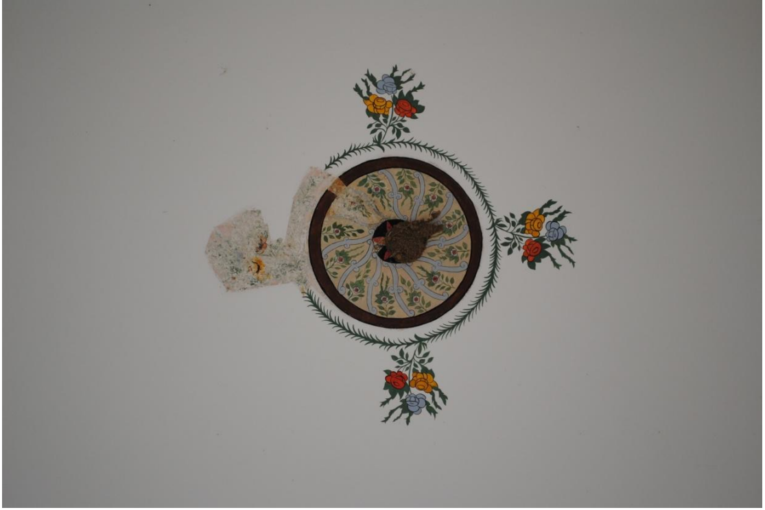
Fot.42: Derviş Ağa Camii Son Cemaat Yeri Kenarlarındaki Kubbe Göbeği
