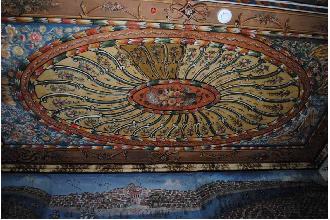
Fot.119: Çakırağa Konağı İstanbul Odasının Tavanı
